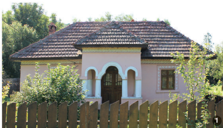
Locuință cu structura din zidărie, edificată în prima jumătate a sec. al XX-lea. Se remarcă decorația de la acces, cornișă și ancadramentele ferestrelor.
