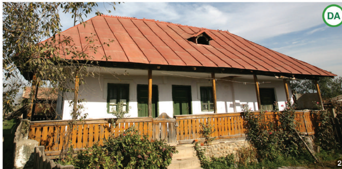
ASA DA: Acoperiș din tablă având o culoare care se încadrează în specificul tradițional al locuinței.
