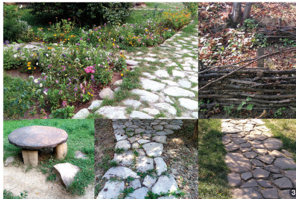
Amenajări de grădini și spații exterioare: pentru împrejurimi s-a utilizat scândura de lemn, piatra sau împletitura de nuiele. Pentru alei, intrări și trepte s-a utilizat piatra, iar pentru balustradă lemnul.
