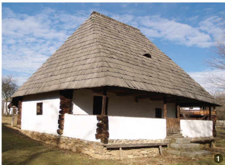
Locuință tradițională cu un singur nivel din „Muzeul arhitecturii gorjene Curtișoara”: Construcția este ridicată pe temelie de piatră, având pereți din bârne de stejar tencuite, finisat cu var alb. Pe latura din față are prispă cu balustradă de lemn, tencuită. Proporția casei este de 1 : 2, înălțimea pereților fiind cuprinsă de două ori în înălțimea acoperișului.
