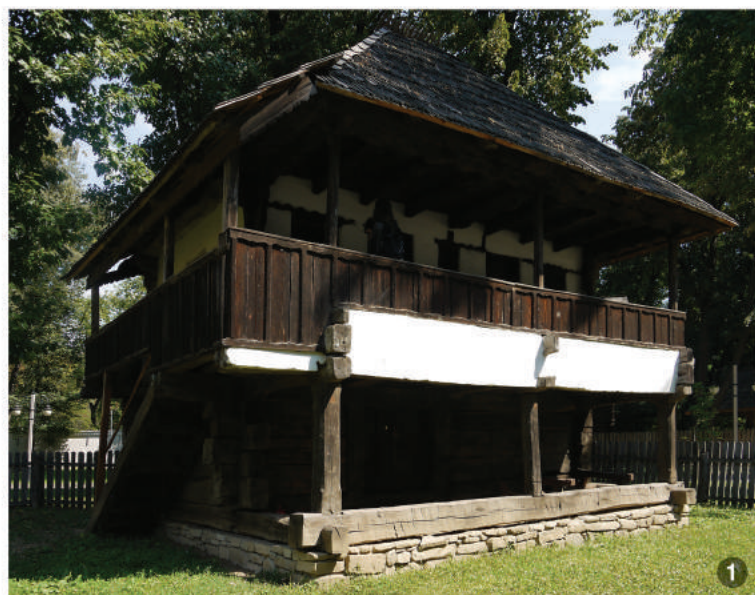
Locuință tradițională de viticultor din Țicleni, județul Gorj (sec. al XIX-lea). Gospodăria se află în prezent în Muzeul Național al Satului „Dimitrie Gusti” din București. Casa cuprinde parter (cu funcțiune de depozitare a alimentelor și uneltelor) și etaj (cu funcțiune de locuire). Este o construcție ridicată pe temelie de piatră, pe tălpi groase („urși” sau „groși”), cu pereți din bărne de stejar, cioplite pe patru laturi și îmbinate în cheutori drepte. Se remarcă la etaj prisma, având decorație specifică, precum și tâmplăria, cu decorații din lemn la partea superioară. Pereții de la etaj sunt tencuiți, iar finisajul este cu var alb.
