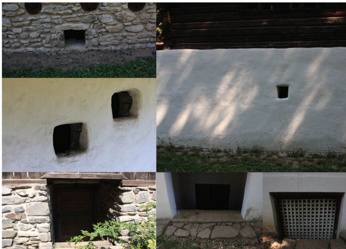
Exemple de goluri de ventilație pentru pivnițe.
