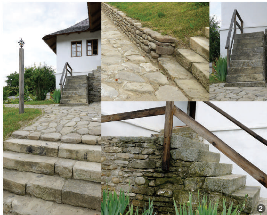
Amenajări de grădini și spații exterioare: pentru împrejurimi s-a utilizat scândura de lemn, piatra sau împletitura de nuiele. Pentru alei, intrări și trepte s-a utilizat piatra, iar pentru balustradă lemnul.
