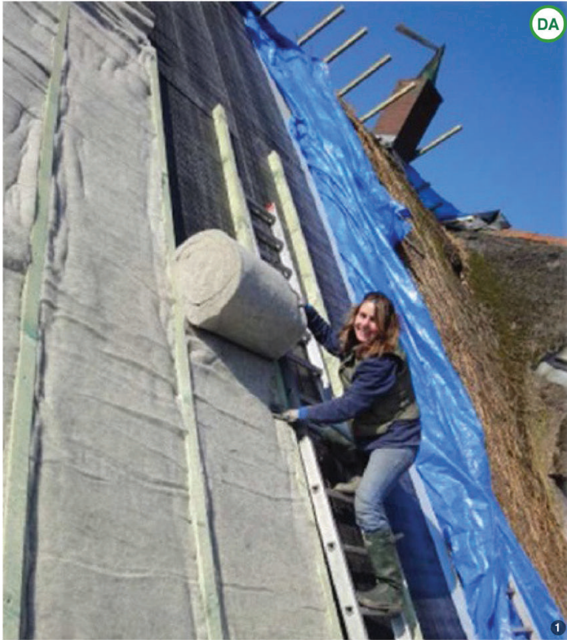
AȘA DA: Termoizolația din lână este deosebit de recomandată. Folosind lână, se sprijină o industrie a prelucrării produselor locale: lână, în prezent, în general se aruncă. Această măsură este încă la început în țara noastră, dar se folosește cu succes și pe scară largă în majoritatea țărilor europene.
