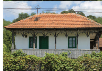
Exemple de fațade cu prispe din lemn, cu balustradă traforată, sau cu prispe închise, vitrate. Se remarcă în toate exemplele tâmplăria din lemn natural sau vopsit.
