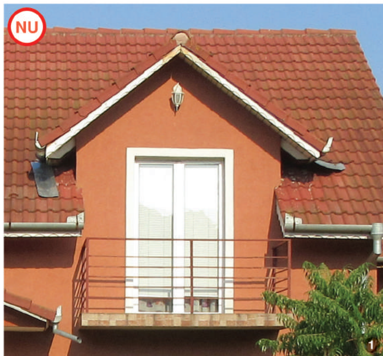
ASA NU: Reabilitarea necorespunzătoare a unei construcții: volume, materiale și culori care nu corespund specificului local.
