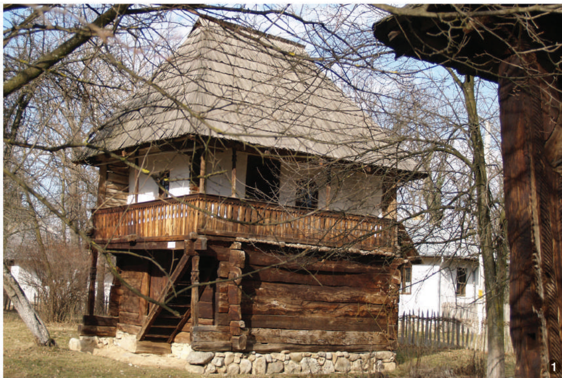
Locuință tradițională din „Muzeul arhitecturii gorjene Curtișoara” cu două nivele. Construcția este ridicată pe temelii de piatră, având schelet din bârne de lemn tencuite numai la etaj, pe cele două laturi care cuprind prispa. Se remarcă decorația de la stâlpi la parter și de la balustrada traforată la etaj.
