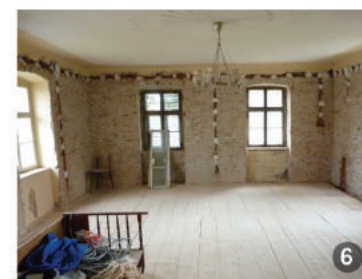
ASA DA: Folosirea unui sistem de încălzire montat pe pereții exteriori, în grosimea tencuiei, este o metodă eficientă și elegantă de încălzire. Încălzind zidurile groase, cu inerție termică mare, întreaga construcție se comportă ca o teracotă. Sistemul are însă și dezavantajul că nu permite amplasarea mobilierului adiacent pereților respectivi și necesită atenție sporită la montarea elementelor fixate în perete. (În fotografie, o construcție din Nocrich, jud. Sibiu)
