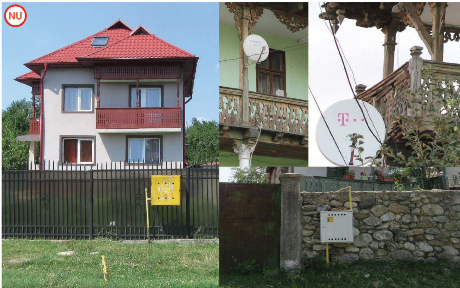
AȘA NU: Bransamente pentru gaze amplasate vizibil pe elementele de împrejurare și antene TV și satelit amplasate pe fațada principală.
