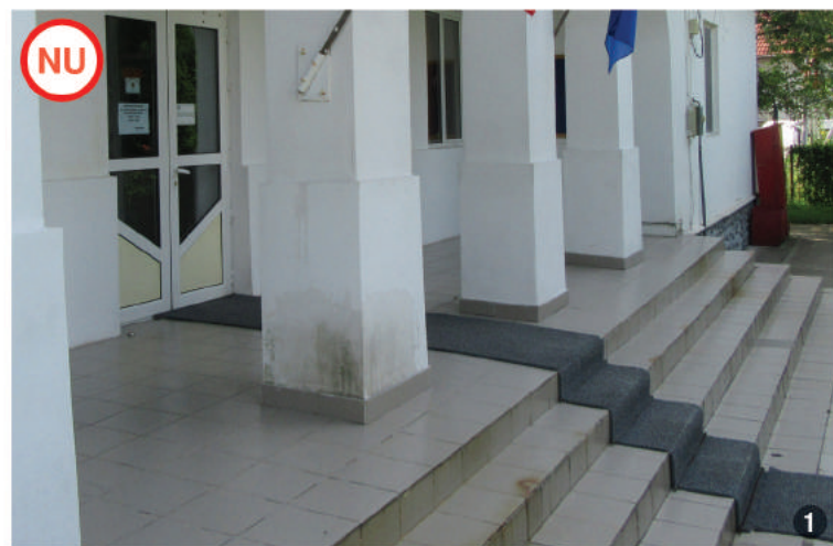
ASA NU: Intervenție la o clădire publică, la soclu și trepte, cu finisaj din gresie ce nu corespunde specificului local.
