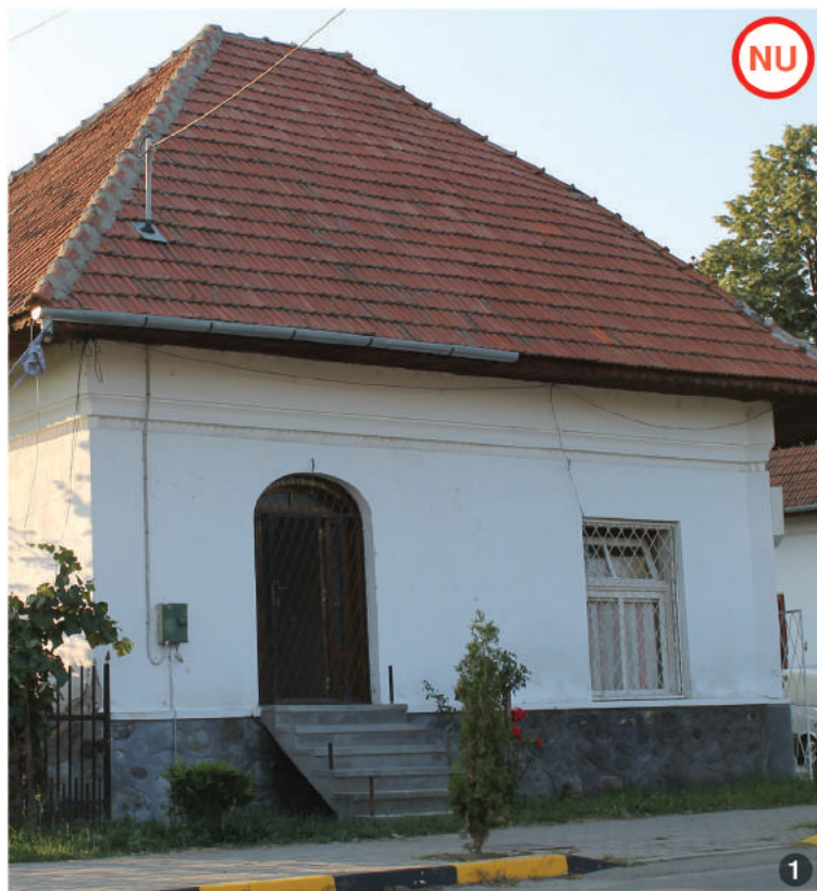
ASA NU: Alterarea fațadei prin realizarea unui nou acces cu trepte direct din stradă, soluție necorespunzătoare specificului local.
