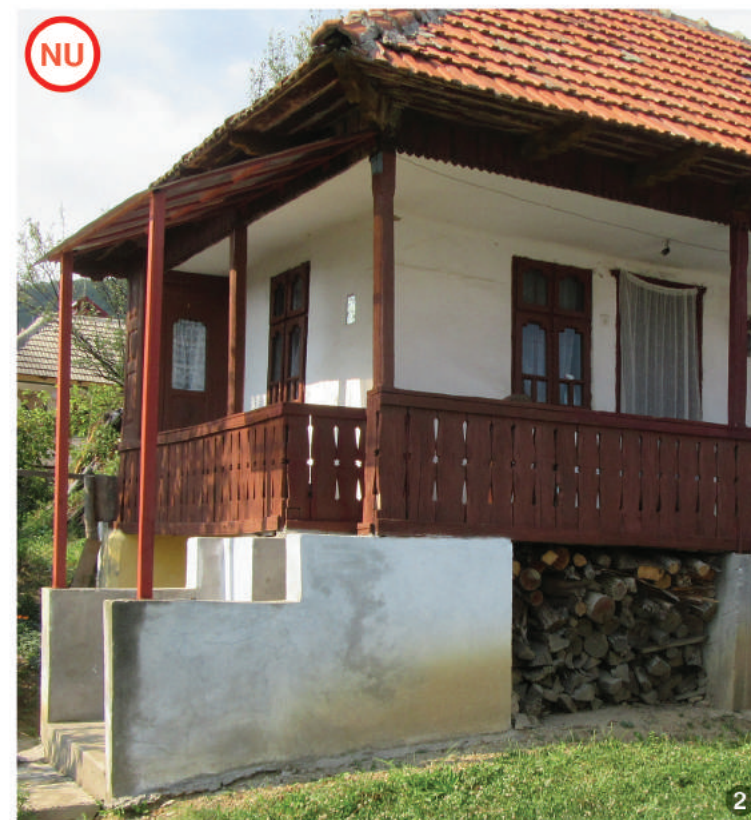
ASA NU: Alterarea prispei de lemn cu parapetul din beton și extinderea pentru acoperirea zonei de acces, cu o structură metalică, acoperită cu polycarbonat.
