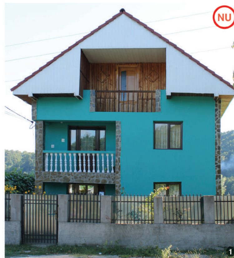
ASA NU: Decupațe foarte mari și inestetice în timpanul acoperișului; utilizarea unor culori și materiale neadecvate.
