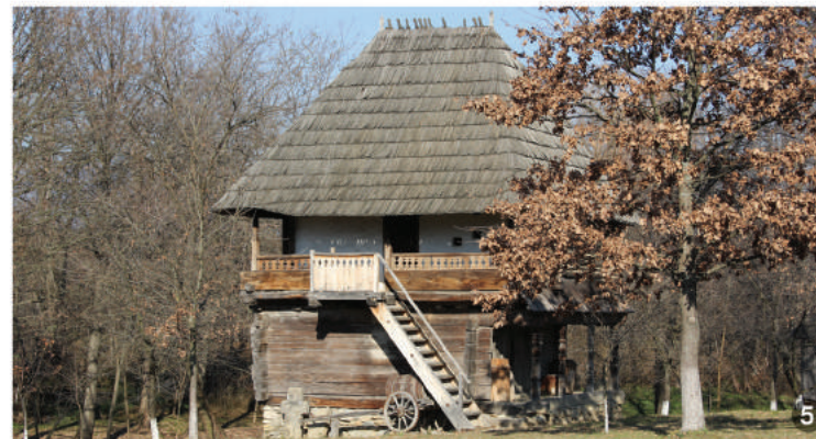
Locuință tradițională cu două niveluri, în „Muzeul arhitecturii gorjene Curtișoara”. Casa este ridicată pe temelie de piatră, având schelet din bârne de stejar cioplite pe patru laturi.
