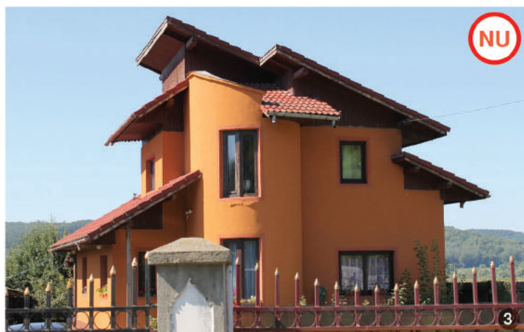
AȘA NU: Acoperiș cu forme atipice.
