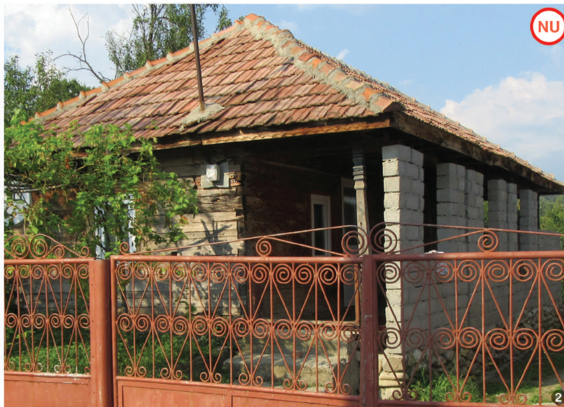
ASA NU: Intervenție cu pereți din BCA pe o construcție existentă din lemn.
