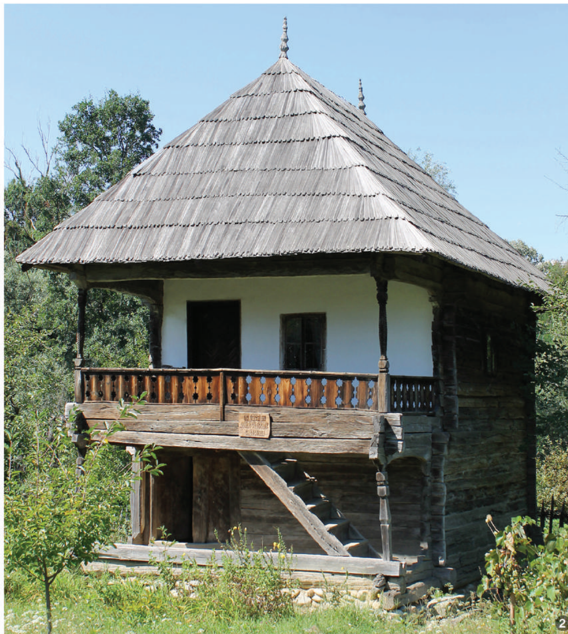
Locuință tradițională din „Muzeul arhitecturii gorjene Curtișoara”, având parter și etaj, cu prispă pe o latură. Sistemul constructiv este realizat din temelie de piatră pe care se ridică bârne de stejar netencuite la parter, iar la etaj tencuite numai pe latura din față a prispei, cu tencuială pe împletitură de nuiele. La stâlpii ambelor prispe se poate observa decorația sculptată, tradițională.
