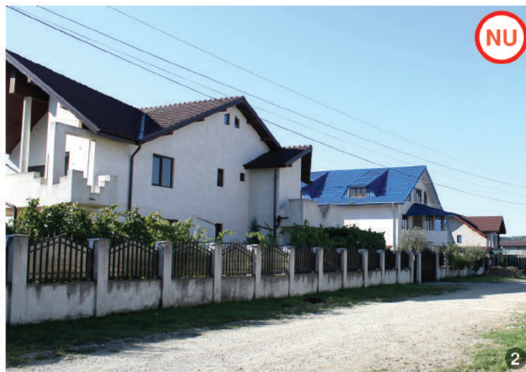
AȘA NU: Învelitori având materiale și culori necorespunzătoare specificului local.
