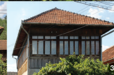
Exemple de fațade cu prispe din lemn, cu balustradă traforată, sau cu prispe închise, vitrate. Se remarcă în toate exemplele tâmplăria din lemn natural sau vopsit.
