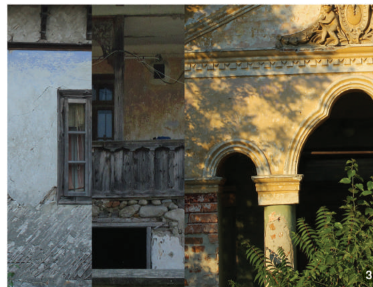
Exemple de alcătuirii de pereți, de la stânga la dreapta: pereți din bârne de stejar tencuite cu amestec vegetal pe nuiele cu și tencuială de var; pereți din piatră finisați cu tencuială de var albă; pereți de cărămidă, finisați cu tencuială de var de culoarea ocru.
