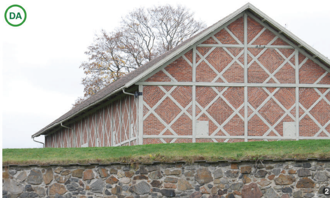
AȘA DA: Construcție cu gabarit mare tip monovolum cu pereți din cărămidă și acoperiș în două ape cu învelitoare din țiglă.
