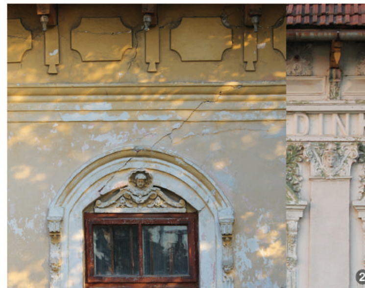
La clădiri cu funcțiune publică precum școli, primării, decorația este realizată din tencuială de var. Aceasta apare la ancadramentele ferestrelor sau ca element recurent pe fațadă precum coloane adosate cu capitel, sau model decorativ sub cornișă.
