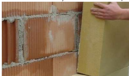
Montarea termoizolației din fibre de lemn
