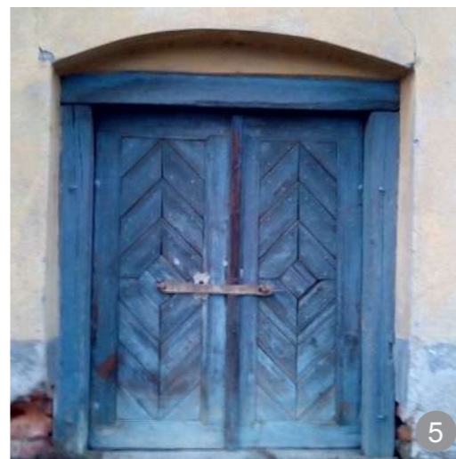
Tâmplărie din lemn a unei uși duble la o pivniță din Zăuan
