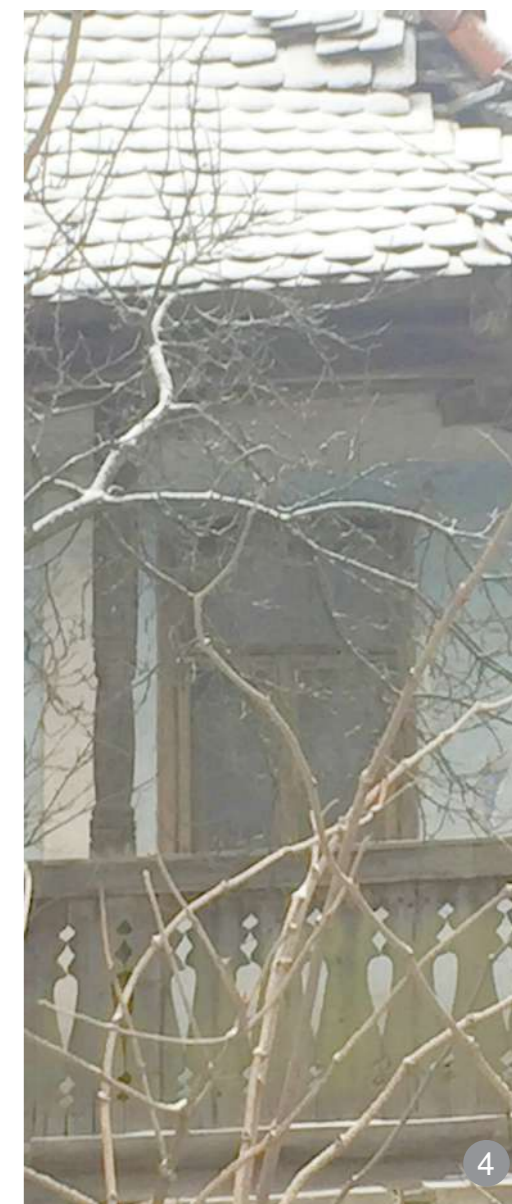
Travee la o locuință din satul Mirșid
