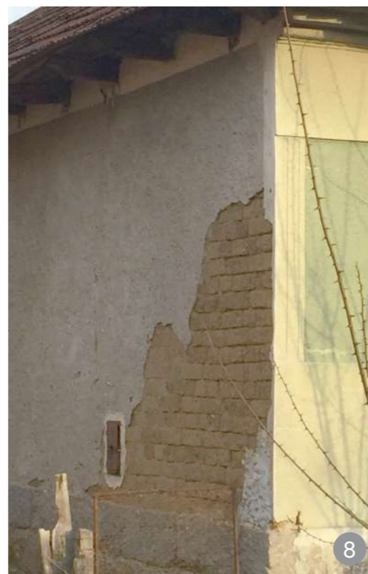
Perete din zidărie de cărămidă arsă
