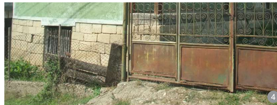
Fundație din blocuri de piatră
