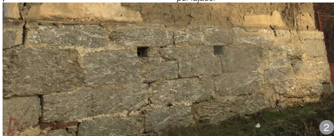
Fundație din blocuri de mică
