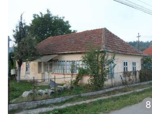
Închiderea târnațului elimină spațiul protejat dintre interior și exterior, fapt pentru care apar acoperiri suplimentare improvizate.
