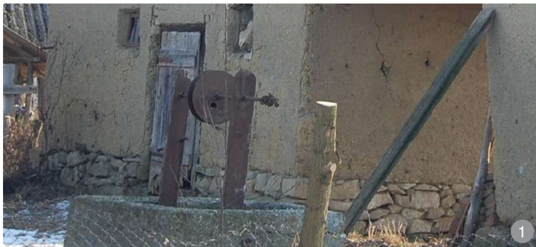
Fundație din piatră mare spartă prinsă cu mortare pe bază de pământ
