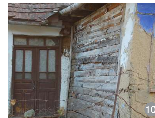
Perete din scânduri de lemn suprapuse tip caplama, întâlnit rar
