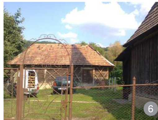
Grajd din lemn prins cu șoși și contravântuiri decorative la Mineu
