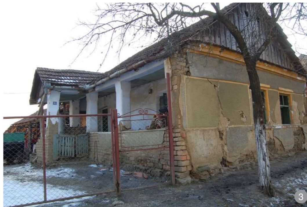
Târnaț cu coloane masive din zidărie și frigurie închis pe fațada dinspre drum
