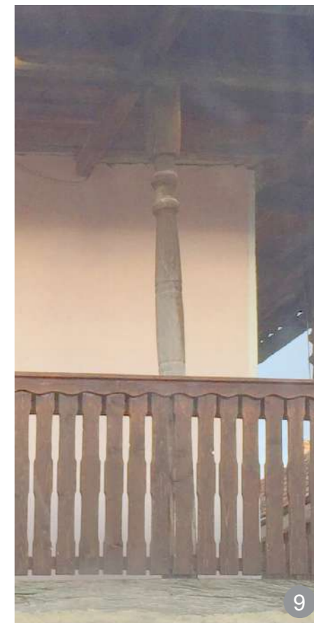
Stâlp din lemn strunjit cu secțiuni circulare compuse
