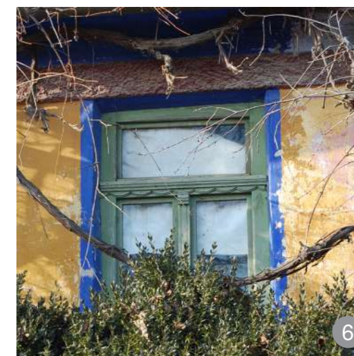
Fereastră tradițională cu traversă decorată cu motivul cocârlei încadrată cu mieriu
