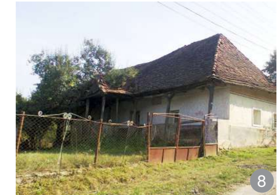
Acoperiș în patru ape înalt (cu unghi mai mare de 45 grade) acoperit cu țiglă solzi
