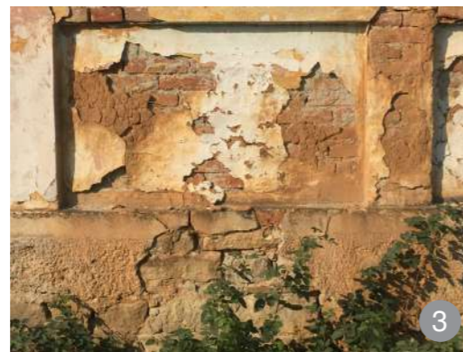
Parapeț din zidărie de cărămidă muruită cu mortar de lut la târnațul unei case sălăjene
