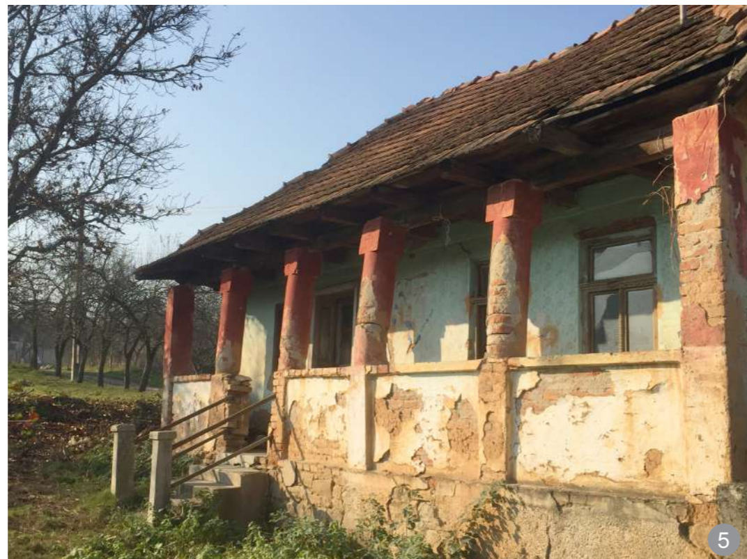
Târnaț cu stâlpi din zidărie
