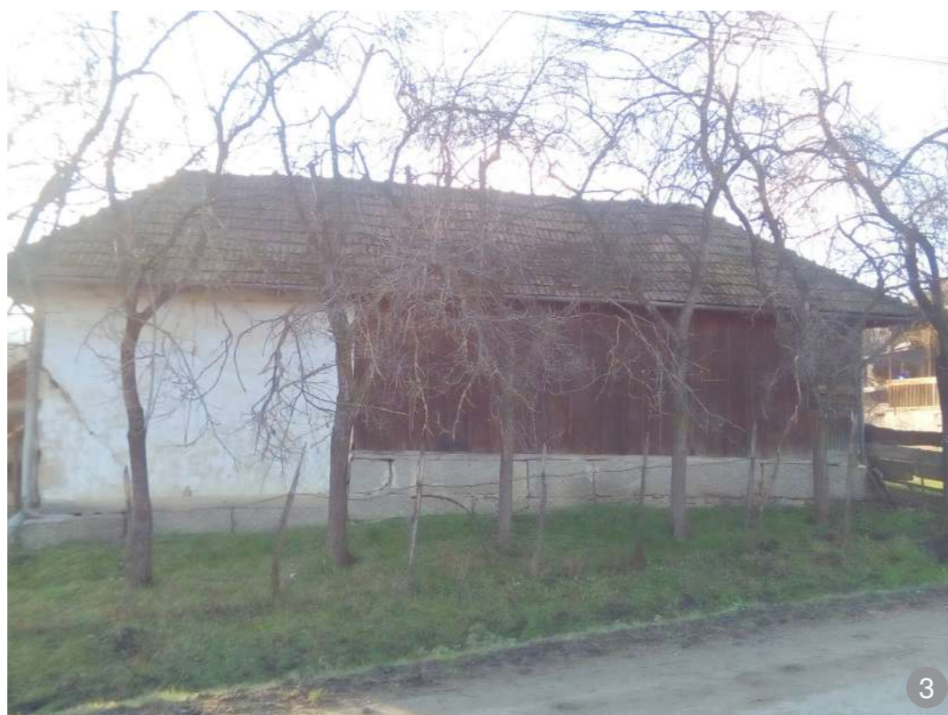
Fundație din blocuri mari de piatră
