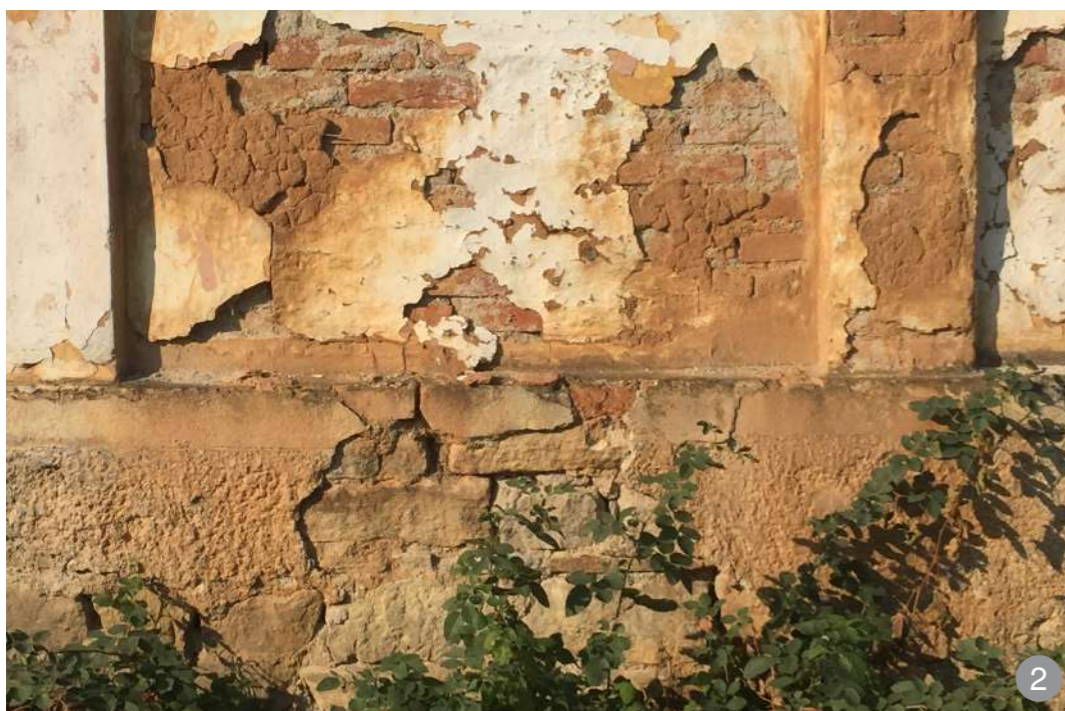
Fundație din lespezi sub pereți din cărămidă
