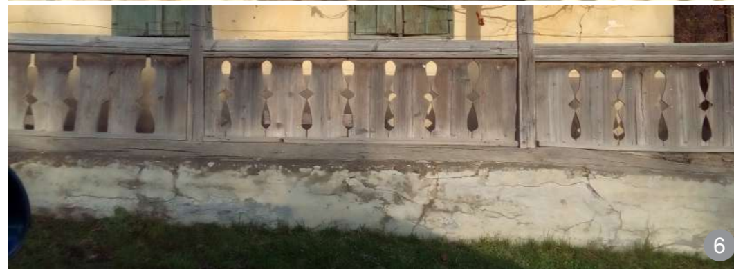
Parapete cu elemente geometrice decupate în lemn
