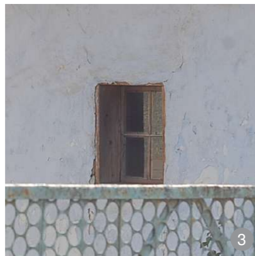
Ferestre pătrate cu canaturile împărțite în patru
