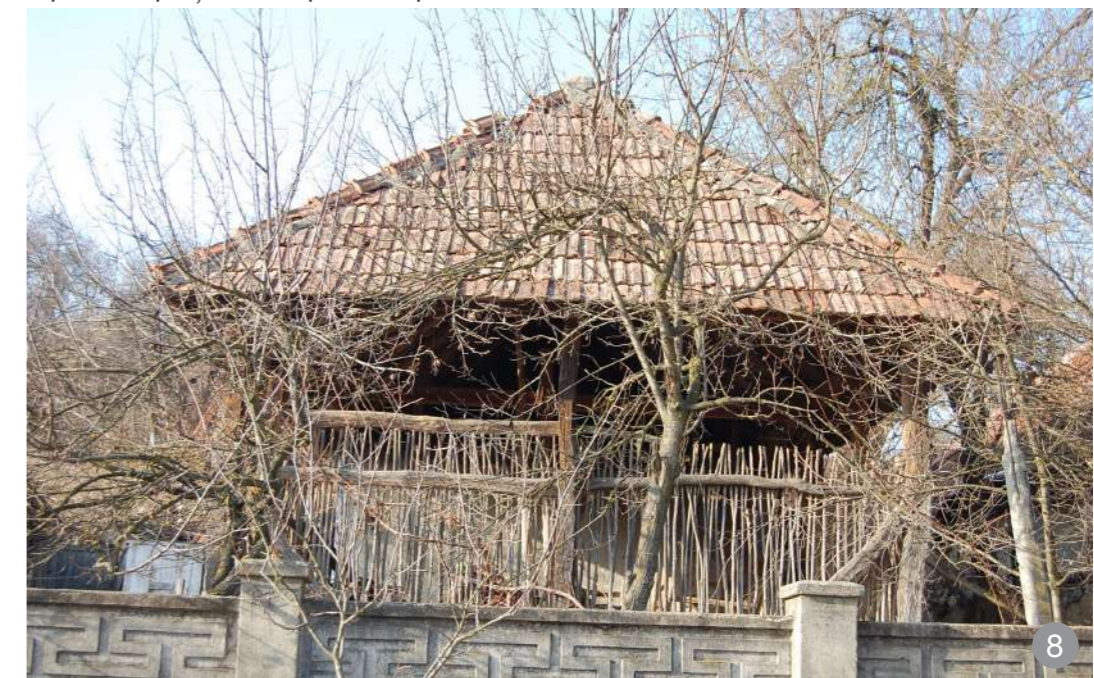
8 Închideri ușoare din nuiiele la o șură din Sălaj
