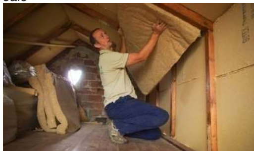
Montarea termoizolației din fibre de cânepă
