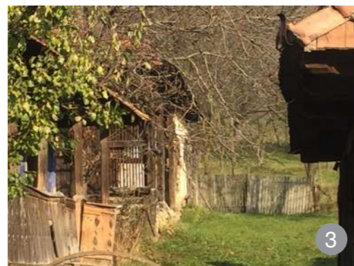
3 Împrejmuire care delimitează gospodăria de grădina din spate
