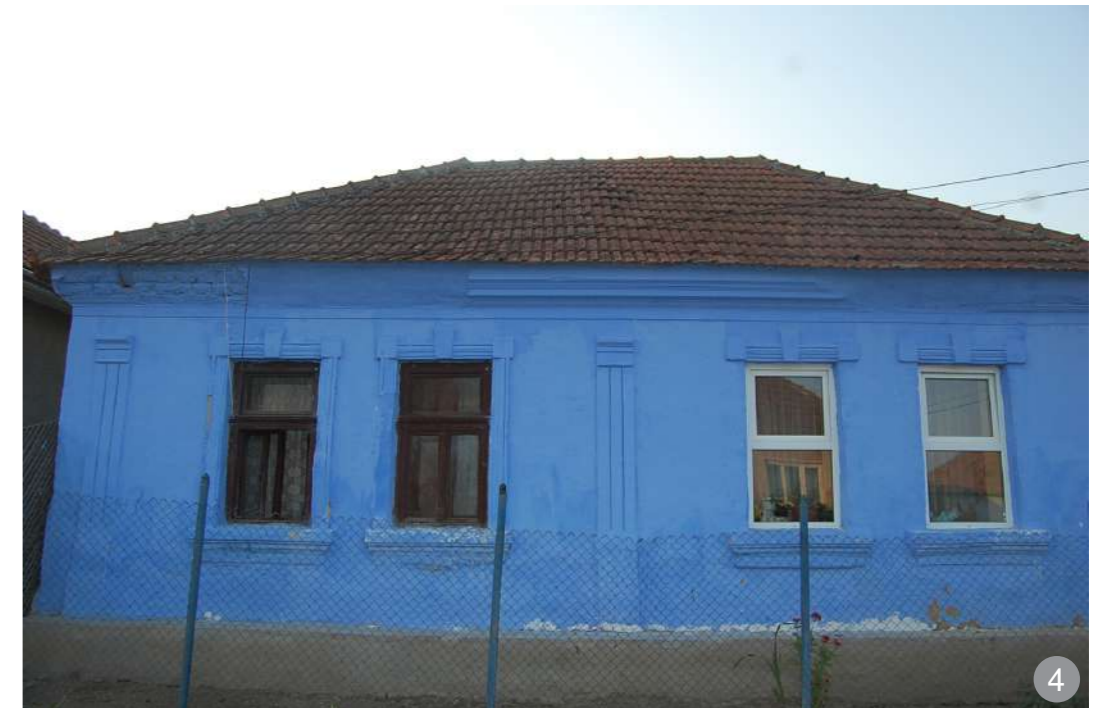
Nu recomandăm reabilitarea (stânga) cu ferestre ce nu păstrează proporția și subîmpărțirea în canaturi ale ferestrelor inițiale (dreapta) sau înlăturarea ancadramentelor decorative.
