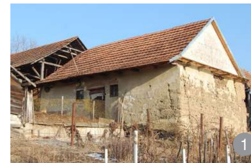
În lipsa lemnului de conifere, pereții erau confecționați din materiale locale precum văioagele lipite.
