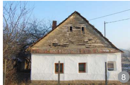
Fronton din „lobde” lipite cu pământ – de remarcat aruncătorul de ploaie de peste peretele de pământ
