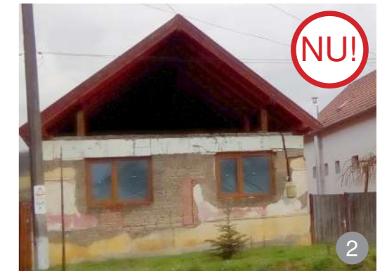
AȘA NU: Nu recomandăm înlocuirea ferestrelor vechi cu ferestre cu canaturi nespecifice zonei.
