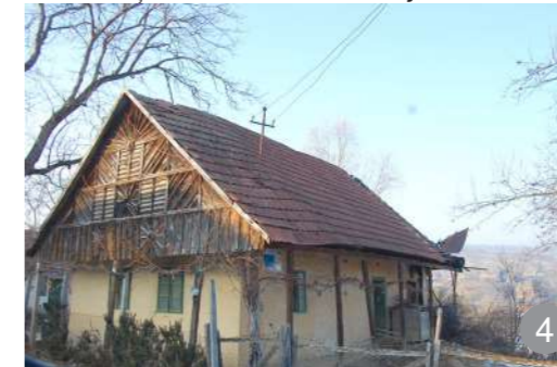
Acoperiș în două ape – întâlnit în partea de vest a zonei Sălaj înspre județul Bihor
