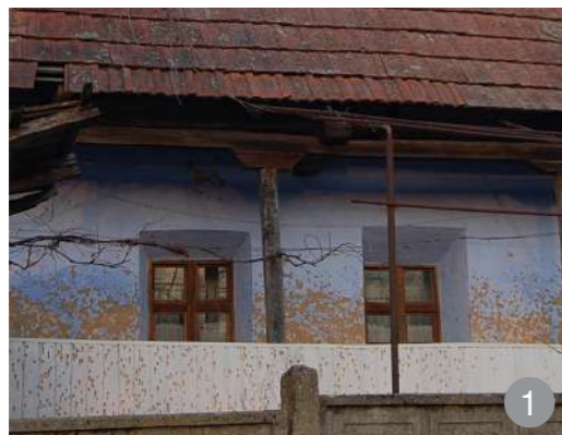
Ferestre cu șpaleți teșiți pentru a intra mai multă lumină în zidurile groase din pământ
