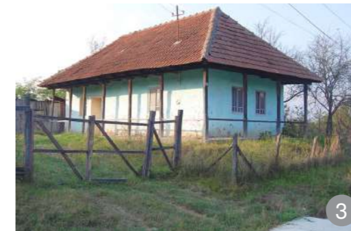
Acoperiș în patru ape – întâlnit în partea centrală și de est a zonei Sălaj
