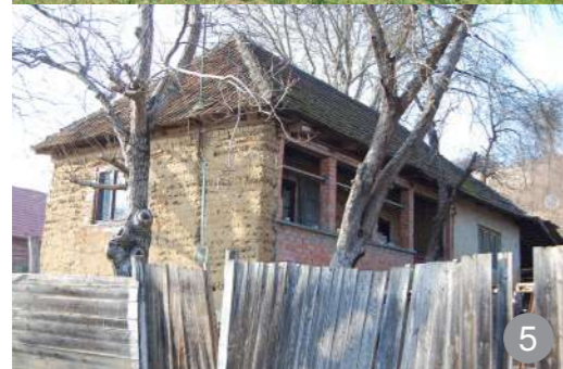
Perete din cărămidă nearsă
