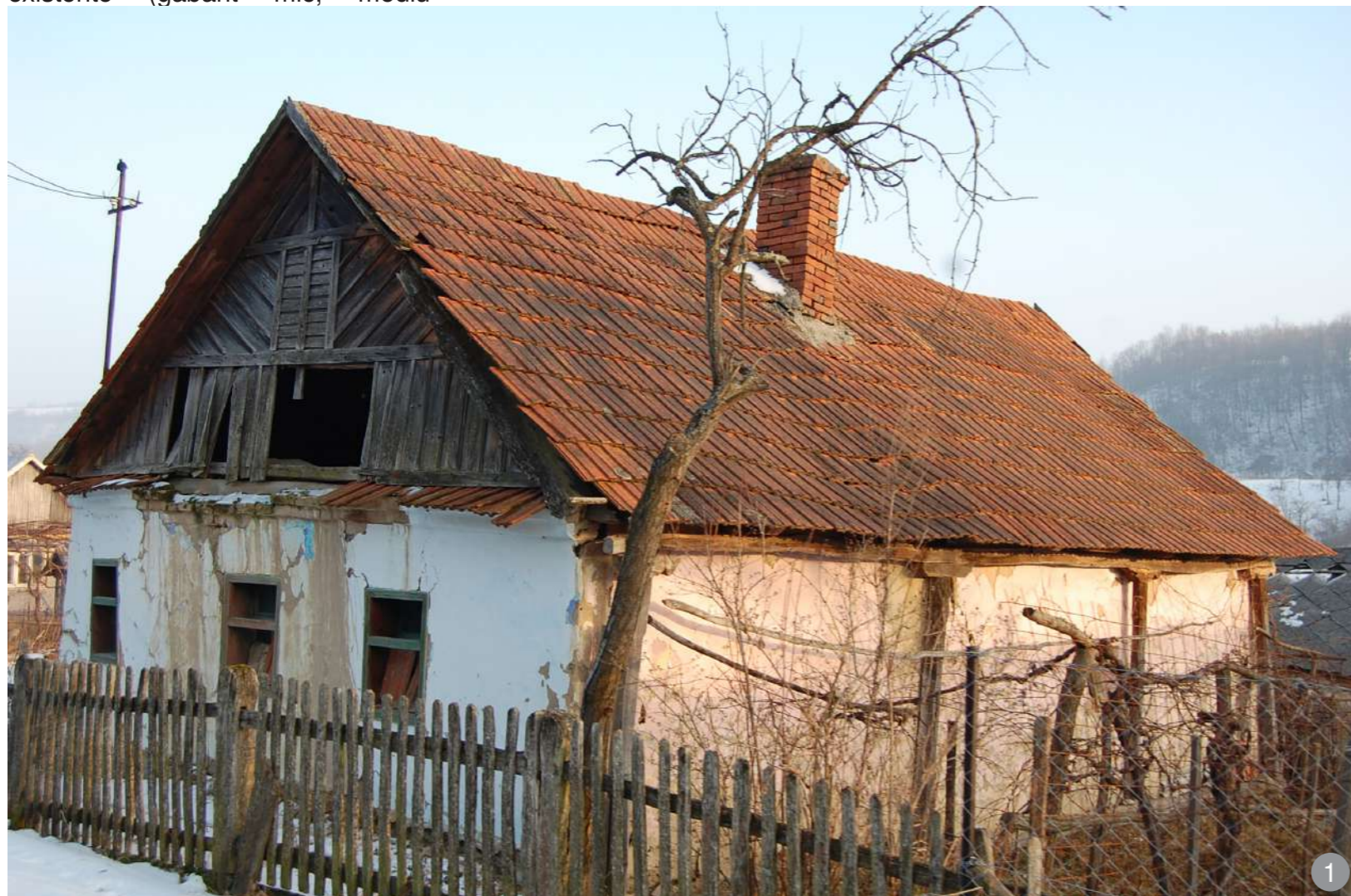
Pereții din pământ sunt uneori dublați de o structură din lemn pentru a ajuta la preluarea eforturilor din acoperiș. Totodată, la acoperișurile în două ape pe fațada cu fronton se adaugă o „aruncătoare” din țiglă pentru protejarea peretelui de acțiunea directă a precipitațiilor.
