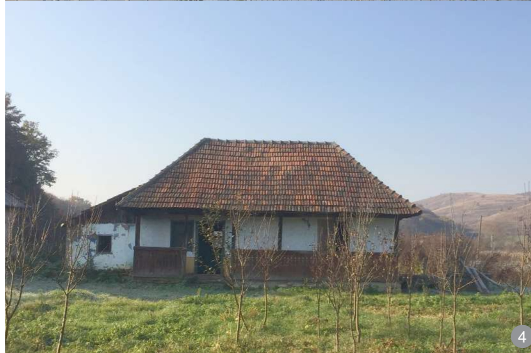
Extinderea casei înspre curtea din spate cu un volum de mici dimensiuni tip polată este discretă, nu deranjează aspectul de la stradă și păstrează specificul local.
