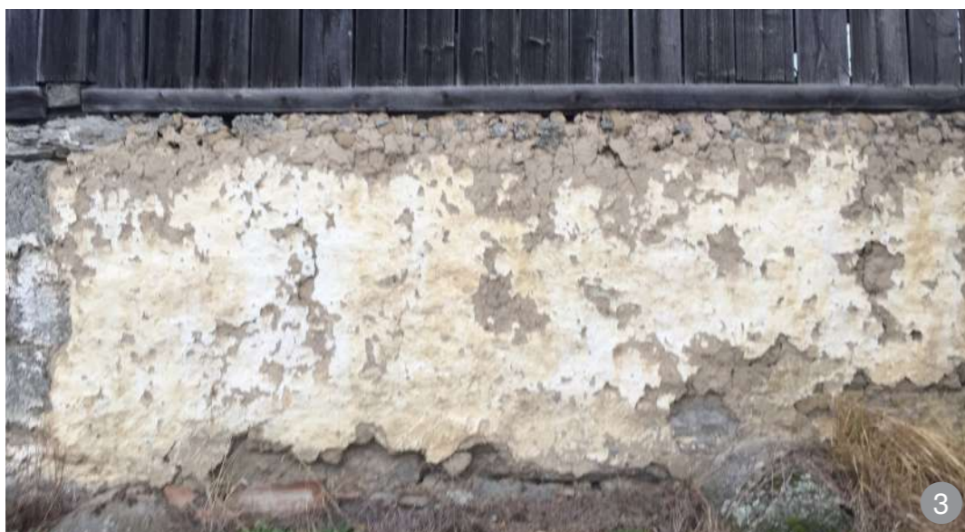
Fundație din piatră tencuită cu pământ
