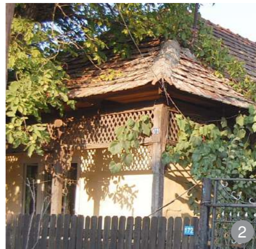
Detalii superioare între stâlpi sub streășină
