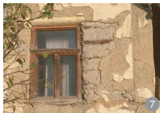
Perete cu pământ lipit între „lobde” („lețuri”)
