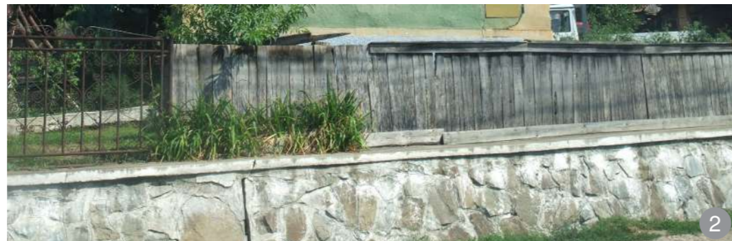
Împrejmuire înălțată pe un perete de susținere a terenului din blocuri mari de piatră și gard din scânduri de lemn dispuse vertical protejate la partea superioară de intemperii
