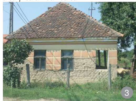
Perete din straturi alternante de cărămidă arsă și cărămidă nearsă
