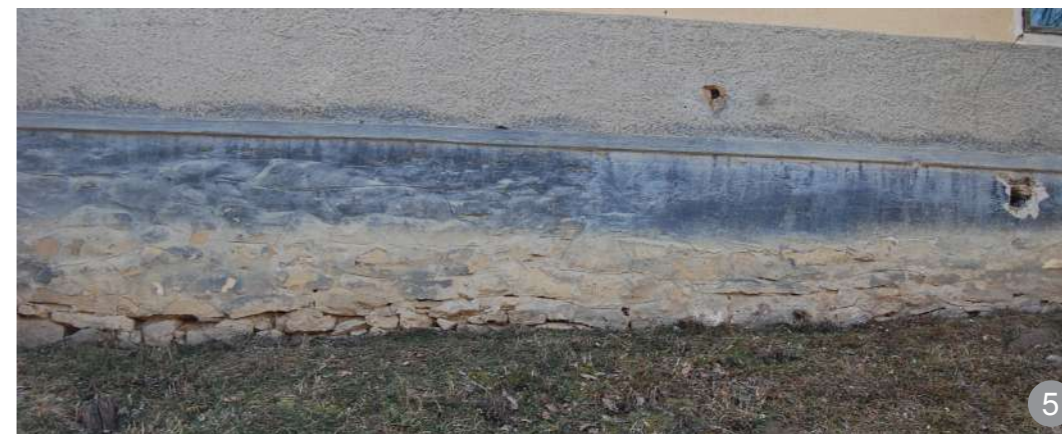
Fundație din lespezi de piatră tencuite
