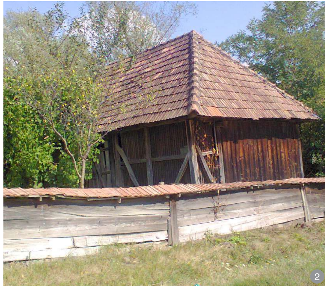
2 Împrejmuire specifică local din scânduri late din lemn dispuse orizontal
