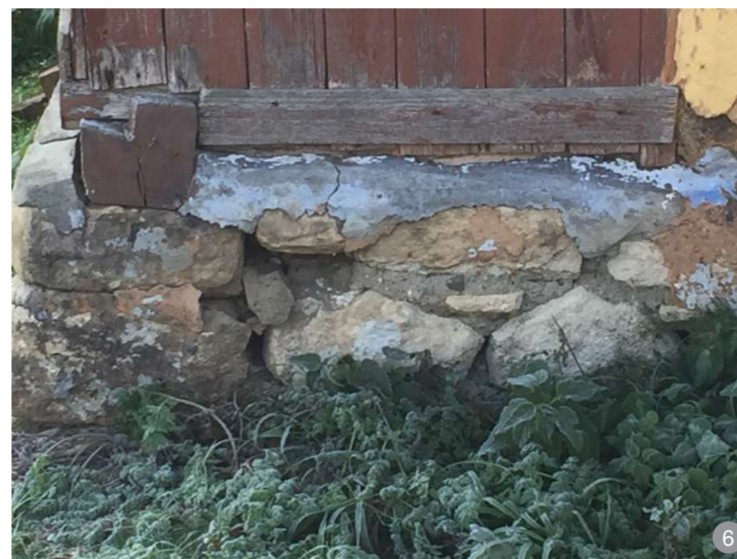
Fundație din piatră zidită
