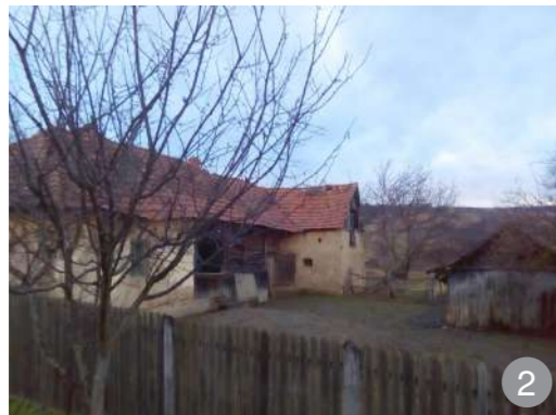
Practica tradițională prin care șura este conectată cu casa poate oferi un spațiu interior adaptat locuirii unei familii extinse prin refuncționalizarea șurii în spațiu de locuit.
