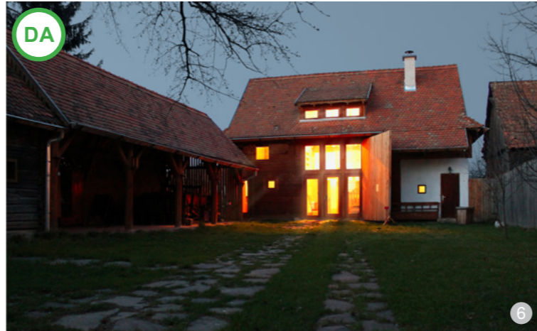
ASA DA: Șura veche a fost reconstruită din materiale noi, păstrându-se forma șurii vechi. La interior s-au păstrat organizarea spațială și structura originală de lemn. Pentru iluminarea spațiului din mansardă, deasupra porții s-a construit un rând de lucarne.
