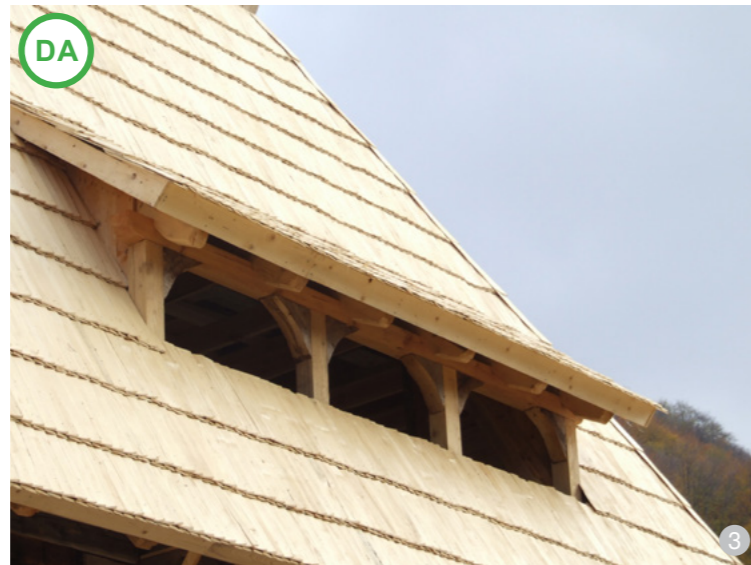
AȘA DA: Lucarna prelungită într-o singură apă precum cea din imagine e o soluție viabilă de iluminare a mansardei.
