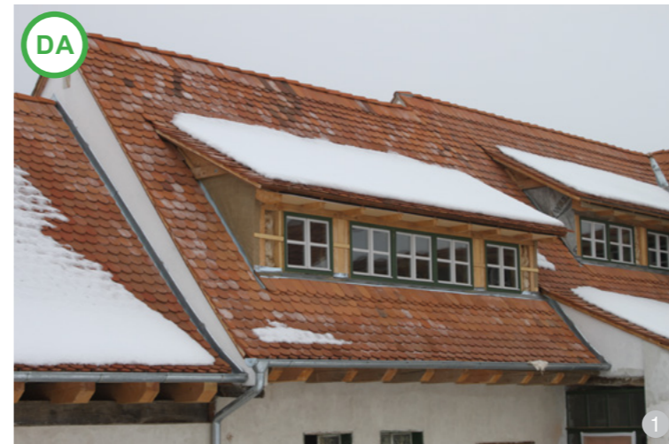
AȘA DA: Amenajarea unor lucarne de lungimi mai mari permite iluminarea și ventilația mai eficientă a spațiilor locuibile amenajate în mansardă, precum și o atmosferă mai plăcută în interior.
