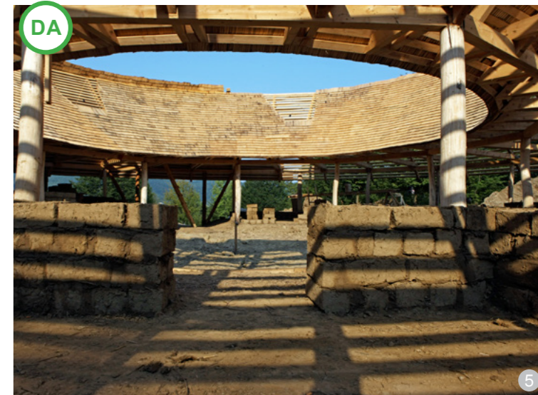
Folosirea pietrei pentru zidurile și fundațiile construcțiilor noi este optimă în zonele cu umiditate mare.
