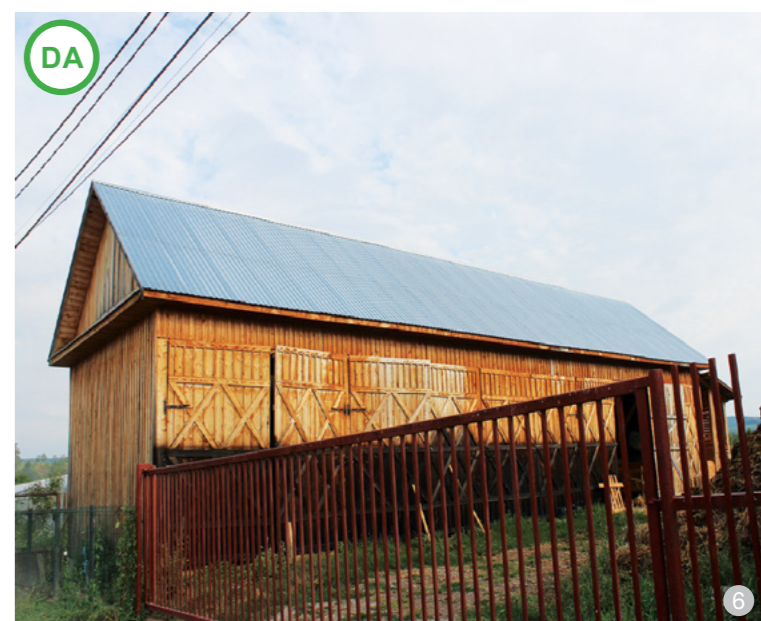
AȘA DA: Acoperirea în două ape și păstrarea unei forme simple a volumului se recomandă, pentru păstrarea specificului local. Exemplul nu se referă la materialul din care este compusă învelitoarea (imagine din satul Piatra).
