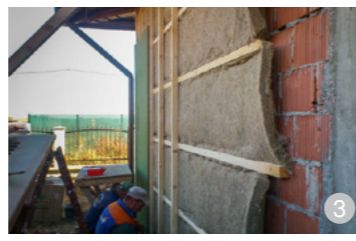
AȘA DA: Termoizolația din lână este deosebit de recomandată. Folosirea unei izolații din lână sprijină o industrie a prelucrării produselor locale: în mod frecvent, lâna se aruncă, în loc să fie utilizată. Această măsură este încă la început în țara noastră, dar se folosește cu succes și pe scară largă în majoritatea țărilor europene.
