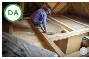
AȘA DA: Termoizolația din lână este deosebit de recomandată. Folosirea unei izolații din lână sprijină o industrie a prelucrării produselor locale: în mod frecvent, lâna se aruncă, în loc să fie utilizată. Această măsură este încă la început în țara noastră, dar se folosește cu succes și pe scară largă în majoritatea țărilor europene.
