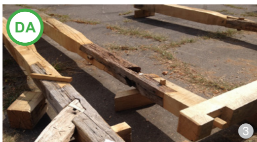
AȘA DA: Cadre tradiționale din lemn în timpul restaurării: un element afectat de degradare nu trebuie înlocuit cu totul.
