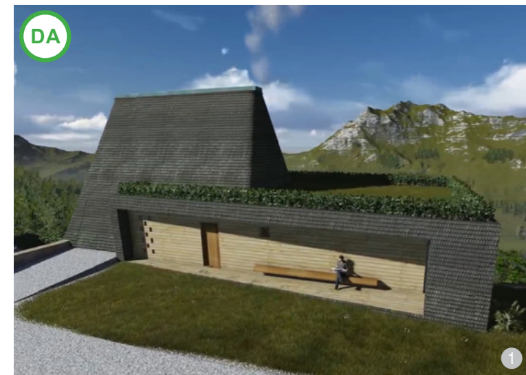
AȘA DA: Exemplu de utilizare a unor materiale compatibile la învelitoare: alăturarea unui acoperiș vegetal/verde la cel acoperit cu șindrila
