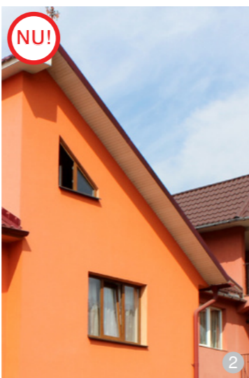
AȘA NU: Nu este recomandată utilizarea ferestrelor din PVC și a celor cu forme geometrice, cum ar fi cercul sau triunghiul (imagine din satul Coșbuc).
