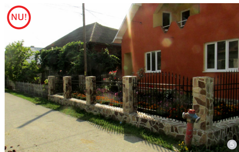
ASA NU: Nu se recomandă realizarea împrejmuirilor din beton sau a stâlpilor, nici placarea lor cu piatră (imagine din satul Rusu Bârgăului).
