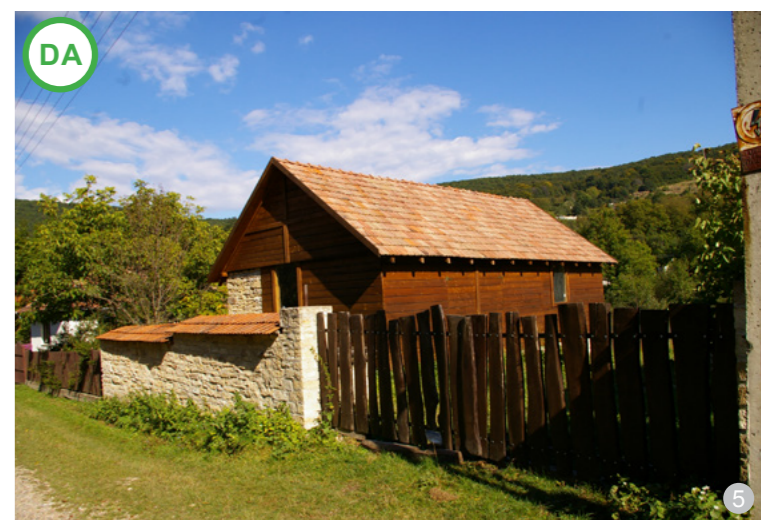
AȘA DA: În interiorul unei șuri tradiționale reabilitate, ale cărei formă și dimensiuni au rămas neschimbate, s-a amenajat un spațiu locuibil. Se recomandă reconversia fondului construit existent, mai ales în cazul construcțiilor realizate din piatră naturală, și doar în cazul în care acest lucru nu este posibil, să se construiască altele noi.
