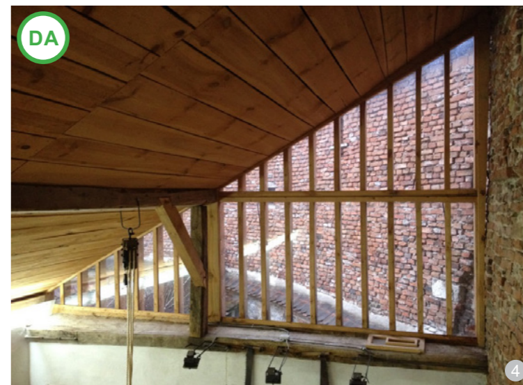
AȘA DA: Exemplul vitrării unui fronton, intervenție ingenioasă care este cu greu vizibilă din exterior, datorită lamelor late, care sugerează imaginea unui fronton din lemn.
