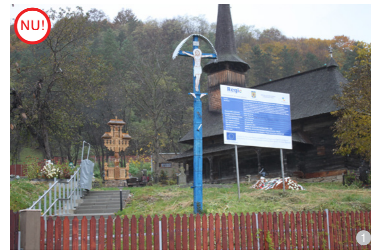
AȘA NU: A se evita montarea defectuoasă a panourilor obligatorii de identificare a investiției. Ele blochează vizual investiția realizată, degradând imaginea obiectului investiției.
