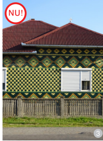
AȘA NU: Folosirea învelitorilor din materiale sintetice este contraindicată, din cauza rezistenței scăzute în timp și a aspectului neplăcut (imagini din Prundul Bărgăului).
