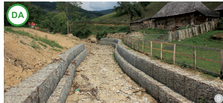
AȘA DA: Este recomandată folosirea produselor locale pentru amenajări de albie de râu, poduri (imagine din zona Fiad).
