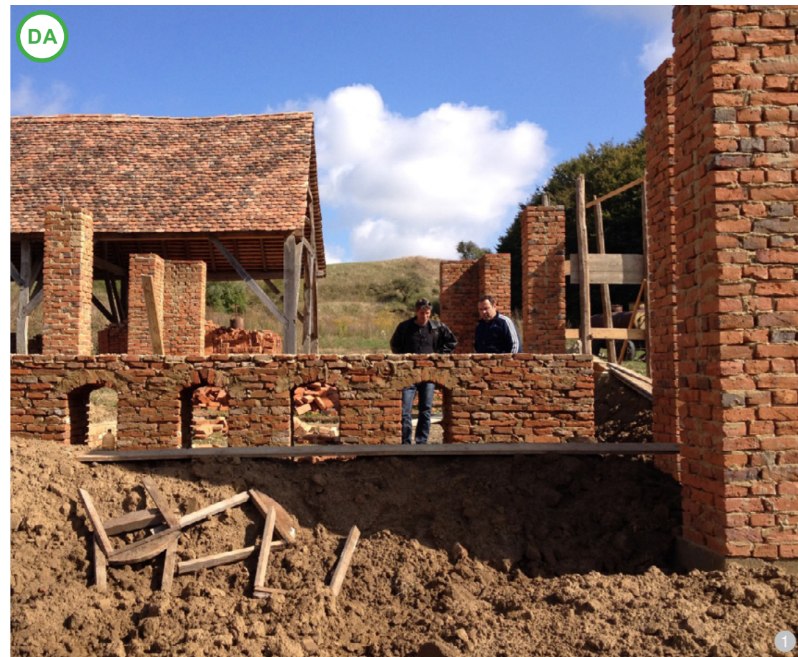
AȘA DA: Construcție nouă cu pereți și stâlpi din cărămidă și beton: cărămidă tradițională, prin dimensiunile ei mici, se adaptează ușor la orice configurație planimetrică, chiar și în detalii.
