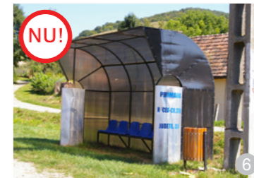
AȘA NU: Exemplu negativ de stație de autobuz, confecționată din materiale nespecifice unei zone rurale
