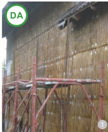
AȘA DA: Exemple de pereți placați cu panouri termoizolante de stuf
