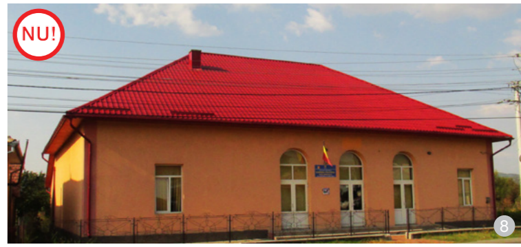
AȘA NU: Motivele pentru a evita amplasarea tablei pe acoperiș sunt evidente și în acest caz (vezi la capitolul despre învelitorile pentru clădirile noi). Imagine din zona Bărgău.
