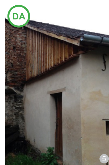
AȘA DA: Exemplul vitrării unui fronton, intervenție ingenioasă care este cu greu vizibilă din exterior, datorită lamelor late, care sugerează imaginea unui fronton din lemn.
