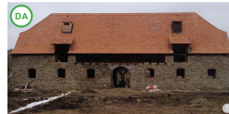
AȘA DA: Zid mixt din piatră de gresie, cărămidă și elemente din beton, care combină tehnica tradițională cu cea contemporană, pentru a corespunde cerințelor de stabilitate etc. – proiect realizat cu finanțare europeană
