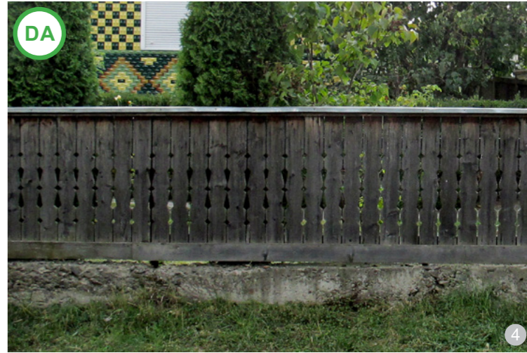
ASA DA: Restaurarea și întreținerea porții vechi reprezintă cea mai indicată metodă. Exemplul nu se referă la soclul gardului din beton armat, care poate fi evitat în mediul rural (imagine din satul Rusu Bârgăului).
