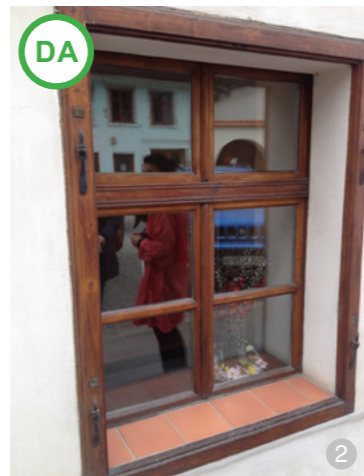
AȘA DA: Fereastră nouă cu două rânduri de geamuri, primul fiind multistrat
