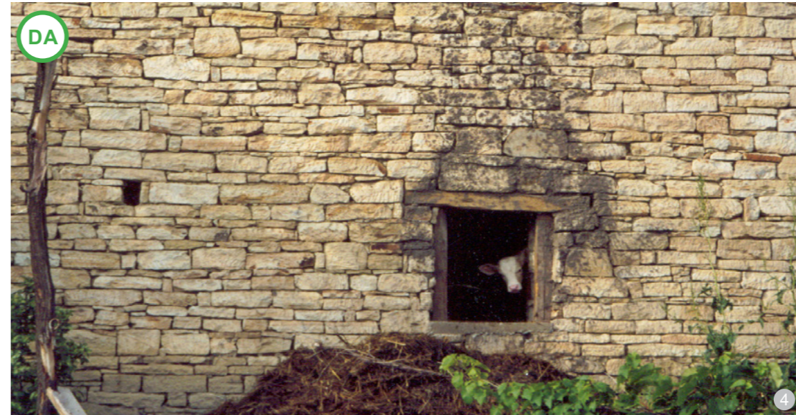
AȘA DA: Exemplul prezintă o structură de piatră portantă netencuită (imagine din Piatra).
