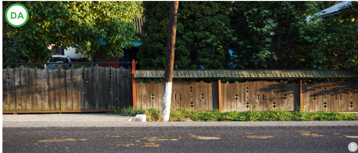
ASA DA: Este recomandată realizarea porților noi opace din lemn, inspirate din modelul tradițional local. În cazul în care nu mai există modelul tradițional, se va realiza o îngrădire simplă din bărne verticale (imagine din zona Bârgău).
