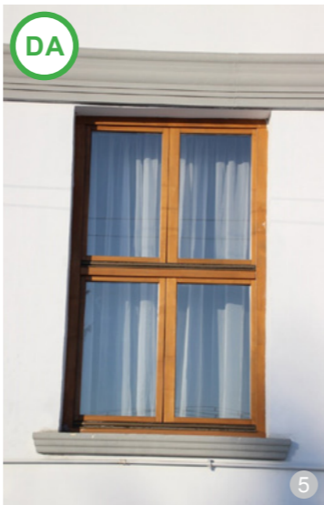
AȘA DA: Fereastră nouă din lemn care păstrează proporțiile, materialul și culoarea ferestrelor tradiționale
