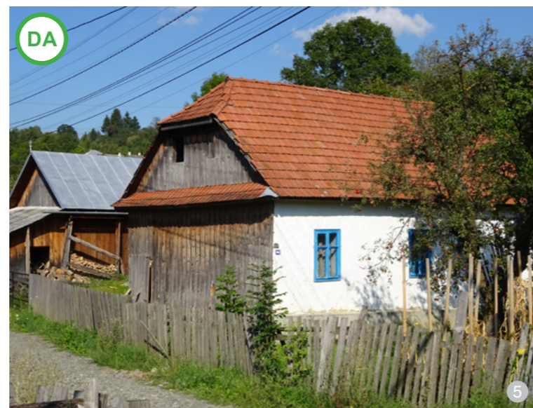
AȘA DA: Acoperiș cu pinionul țesit, cu influențe din zona săsească. Tipul acesta de rezolvare se întâlnește punctual, în unele sate (imagine din zona Fiad, zona Bârgău).
