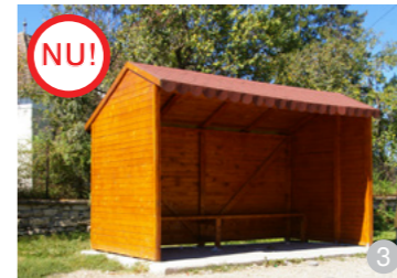
AȘA NU: Exemplu negativ de stație de autobuz, din lemn bățuit cu o culoare stridentă și acoperită cu o învelitoare nespecifică zonei rurale
