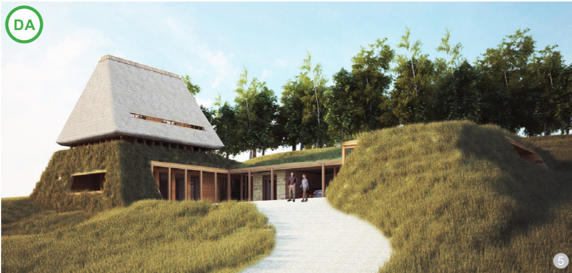
AȘA DA: Exemplu de utilizare a unor materiale compatibile la învelitoare: alăturarea unui acoperiș vegetal/verde la cel acoperit cu stuf/paie
