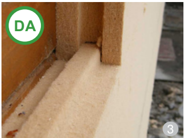
AȘA DA: Termoizolație fibrolemnoasă. Produs fabricat din materii prime naturale, utilizând tehnologii moderne și prietenoase cu mediul. Fiind permeabilă la vaporii de apă, păstrează structura casei în stare uscată în mod permanent. Poate fi utilizată pentru fațadă, pardoseli și mansarde.
