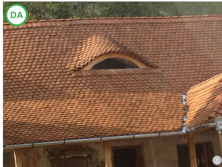
AȘA DA: Lucarnele de tip „ochi de pisică” sunt cele mai folosite pentru a ilumina un pod mansardat. Acestea modifică nesubstanțial volumul acoperișului.
