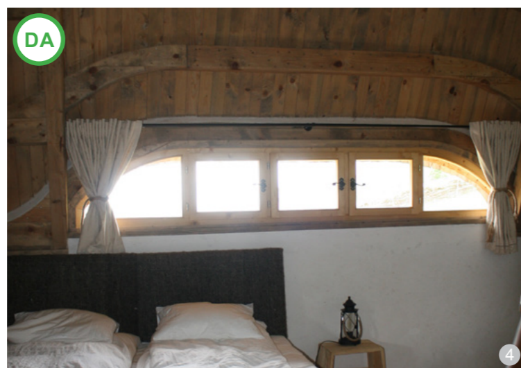
AȘA DA: Utilizarea unor învelitori ca șindrila, stuful sau țigla solzi permite realizarea unor lucarne foarte discret inserate în volumul acoperișului, care asigură necesarul de lumină și ventilație în spațiul mansardei.
