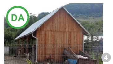
AȘA DA: Cu toate că este o construcție nouă, forma acoperișului se inspiră din soluțiile tradiționale locale folosite la anexe. Exemplul nu se referă la materialul din care este alcătuit învelitoarea, care nu este recomandat (imagine din satul Zagra).
