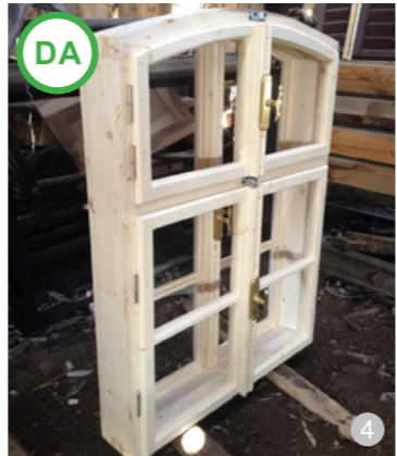
AȘA DA: Atunci când fereastra nu mai poate fi salvată, se poate recurge la serviciile unui atelier local de tâmplărie, pentru a reproduce fereastra după croiul original.
