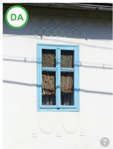
AȘA DA: Se recomandă repararea ferestrelor originale și nu înlocuirea lor cu altele noi, cu tâmplăria de PVC, cele din lemn fiind mult mai frumoase și adaptate la nevoile construcțiilor vechi.
