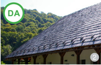
AȘA DA: Șița și șindrila sunt materiale tradiționale care și-au demonstrat în timp trănicia și versatilitatea.
