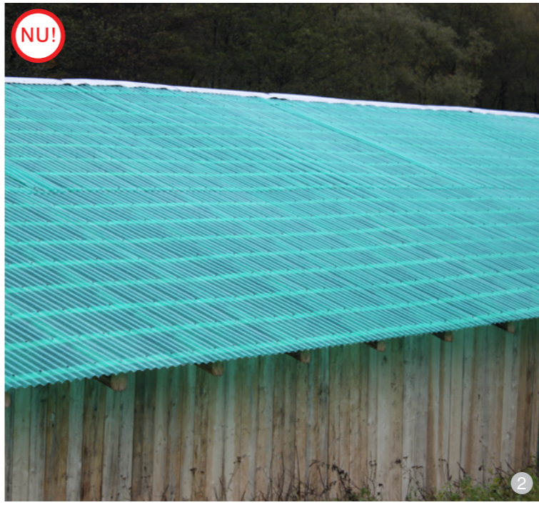
AȘA NU: Se va evita utilizarea plăcilor de policarbonat sau alte materiale de tipul plasticului. Acestea au o durată de viață scurtă, sunt inestetice, iar când se încălzesc de la soare emană un miros neplăcut.
