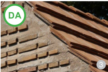
AȘA DA: Țigla nouă, produsă manual după rețete tradiționale, este soluția recomandată atunci când vorbim despre înlocuirea învelitorilor istorice degradate.
