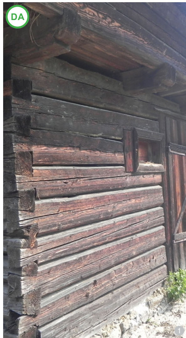
AȘA DA: Îmbinare „coadă de rândunică” (imagine din zona Ilva).
