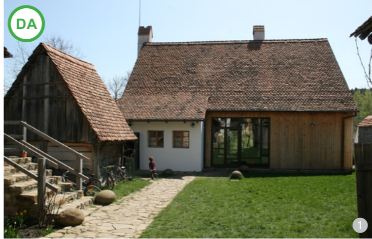
AȘA DA: Refolosirea țiglei vechi este o soluție foarte bună pentru intervenția pe clădiri tradiționale, în contextul în care majoritatea pieselor au rezistat mai bine de o jumătate de secol. Aceasta trebuie însă foarte bine selectată în cazul acoperișurilor în care se amenajează o mansardă.
