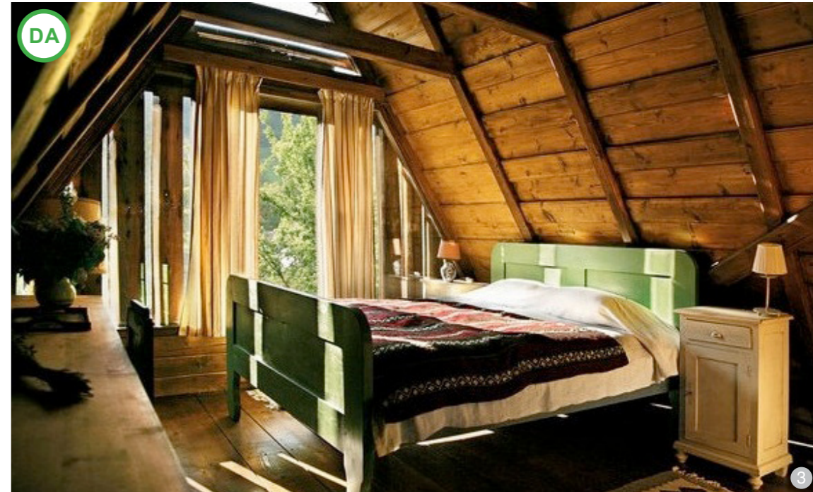
AȘA DA: Pentru construcțiile anexe în care se amenajează spații de locuit mansardate se pot utiliza procedee precum cel din imagine privind vitrarea întregului fronton, mai ales dacă acesta a fost inițial din lemn.
