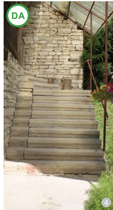
ASA DA: Scări exterioare realizate din blocuri de piatră.
