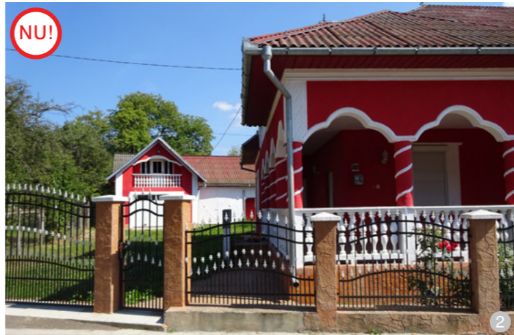
ASA NU: Se va evita placarea stâlpilor porții cu plăci ceramice care imită piatra și decorarea lor cu statuete din beton (imagine din Josenii Bârgăului).
