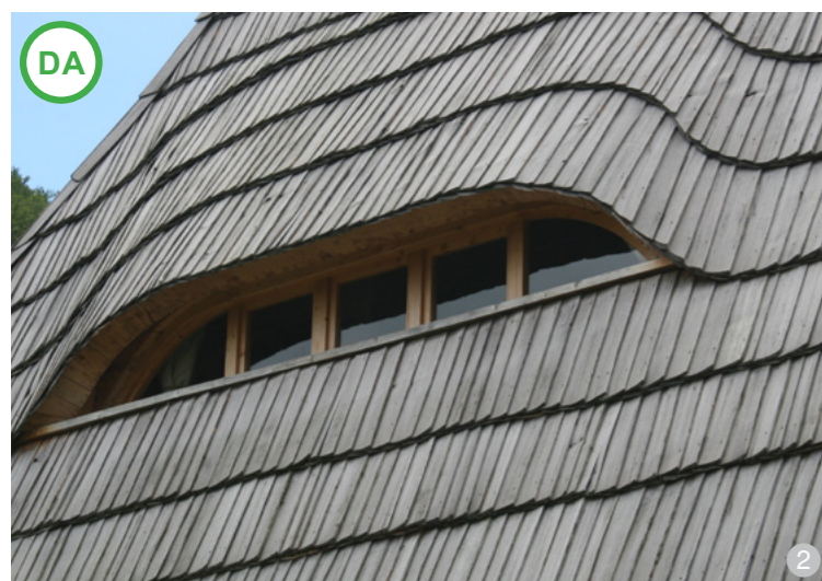
AȘA DA: Utilizarea unor învelitori ca șindrila, stuful sau țigla solzi permite realizarea unor lucarne foarte discret inserate în volumul acoperișului, care asigură necesarul de lumină și ventilație în spațiul mansardei.
