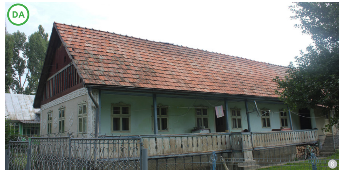
AȘA DA: Acoperire în patru ape cu țiglă (imagine din satul Zagra)
