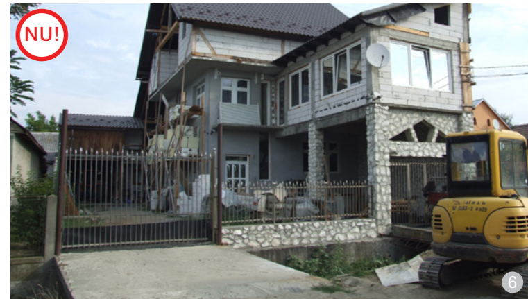
ASA NU: Nu se recomandă placarea soclului cu piatră sau alte materiale și realizarea gardului din fier forjat (imagine din satul Nimigea).
