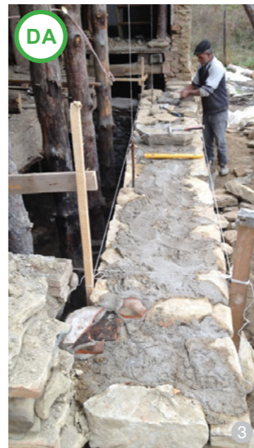
Folosirea pietrei pentru zidurile și fundațiile construcțiilor noi este optimă în zonele cu umiditate mare.
