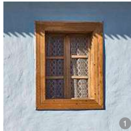
Ferestre simple cu canaturile mobile, împărțite în trei, mai ales la case vechi de secol XIX.
