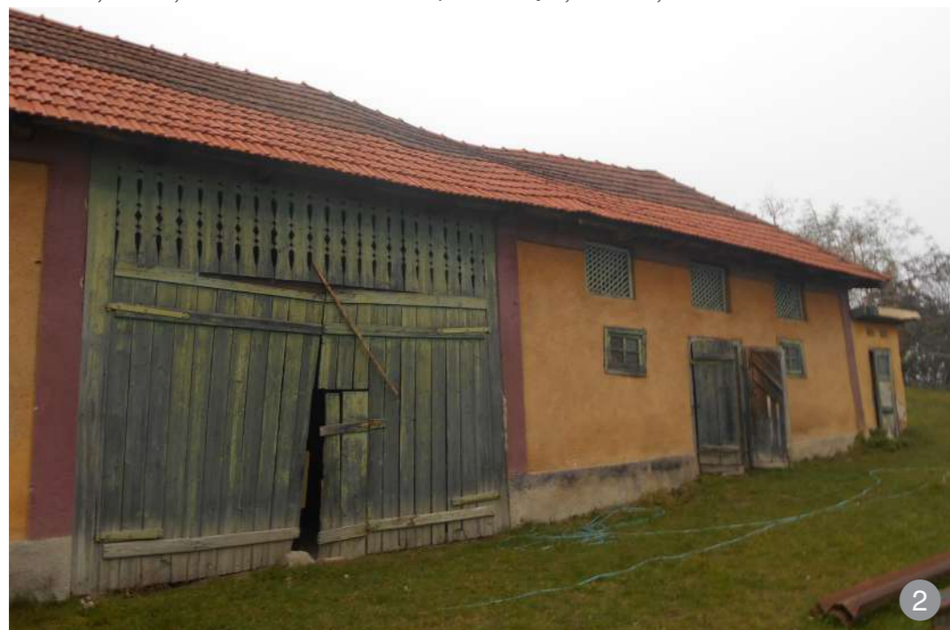
Poartă de șură din lemn cu decupaje între scânduri și aerisiri la ladă din șipci suprapuse prinse în ramă.
