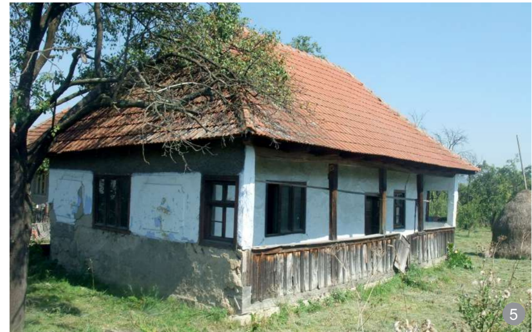
Târnaț din lemn pe o latură. Se remarcă în zona Meseș că odată cu alinierea caselor la drum se închide laterala târnațului cu zid și fereastră sau cu o arcadă deschisă.
