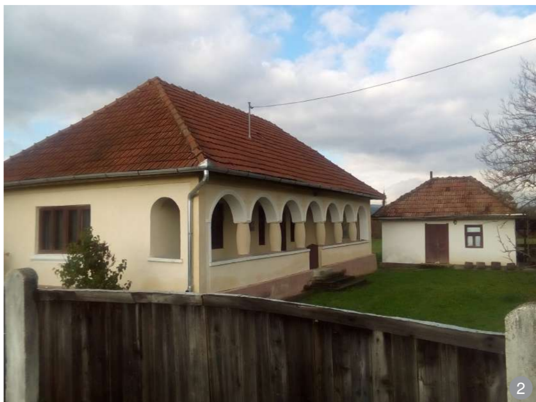
Târnaț din zidărie sau turnate din beton cu arcade întâlnite până în zona Dealurile Clujului. Se remarcă colonetele joase și galbate.
