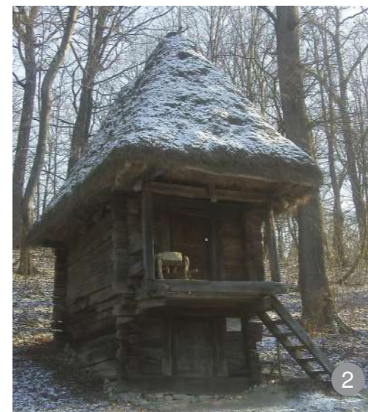
Grajd cu pemniță realizat din lemn și acoperiș din paie.
