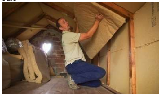
Montarea termoizolației din fibre de cânepă
