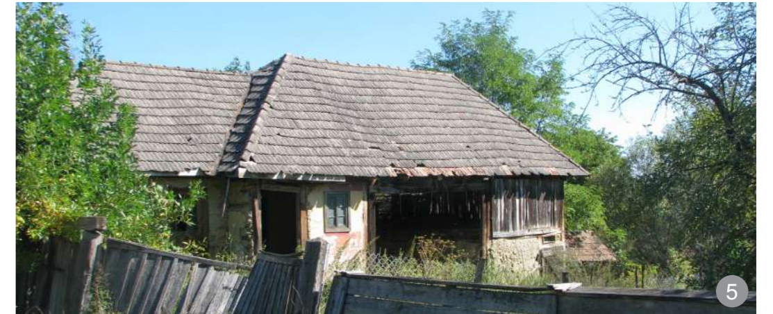
Șură cu construcții anexă încorporate sub același acoperiș în satul Miluani
