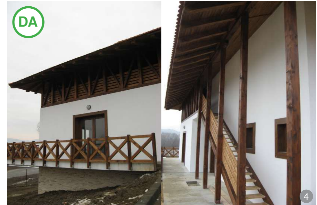
AȘA DA: Reinterpretarea anexelor și refuncționalizarea lor poate păstra specificul și la clădirile cu gabarit mare prin folosirea caracteristicilor tradiționale – lada, târnațul, golurile pătrate, materialele specifice.
