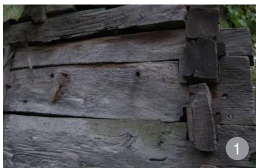
Șură cu perete din lemn realizat cu cheutorilor drepte.
