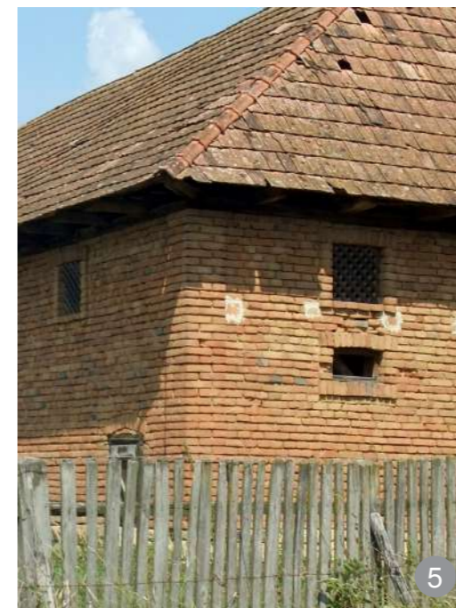
Perete din zidărie de cărămidă arsă.
