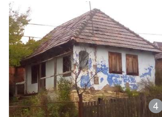
Inchiderea târnațului înspre stradă cu arcadă.
