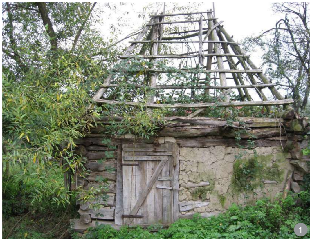
Poiată cu pereți din lobde cu pământ lipit și cu șarpantă specifică destinată învelitorilor din paie.
