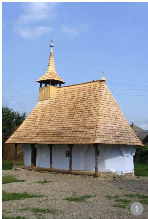
Biserică din Bălan cu pereți din lemn lipiți cu pământ.
