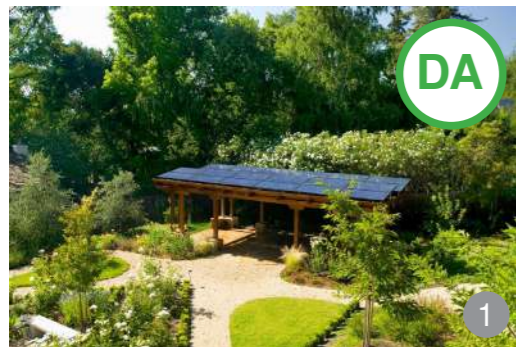
AȘA DA: Decât să se umple suprafețe mari de acoperiș vizibile din locurile publice, recomandăm structuri separate pentru panouri solare în spatele curții.
