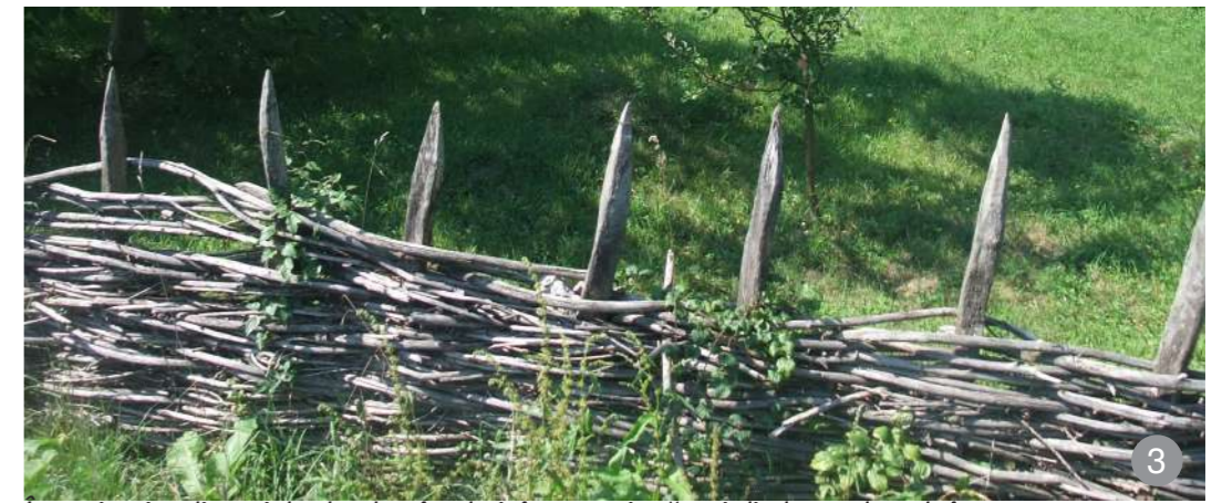
Împrejmuire din nuiete de alun împletite între pari crăpați din lemn de salcâm.
