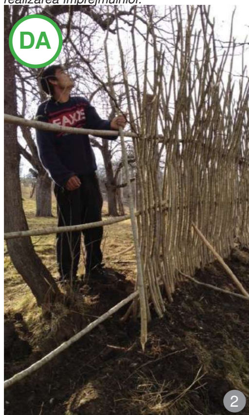
AȘA DA: Realizarea unui gard nou din nuiele în tehnici tradiționale.
