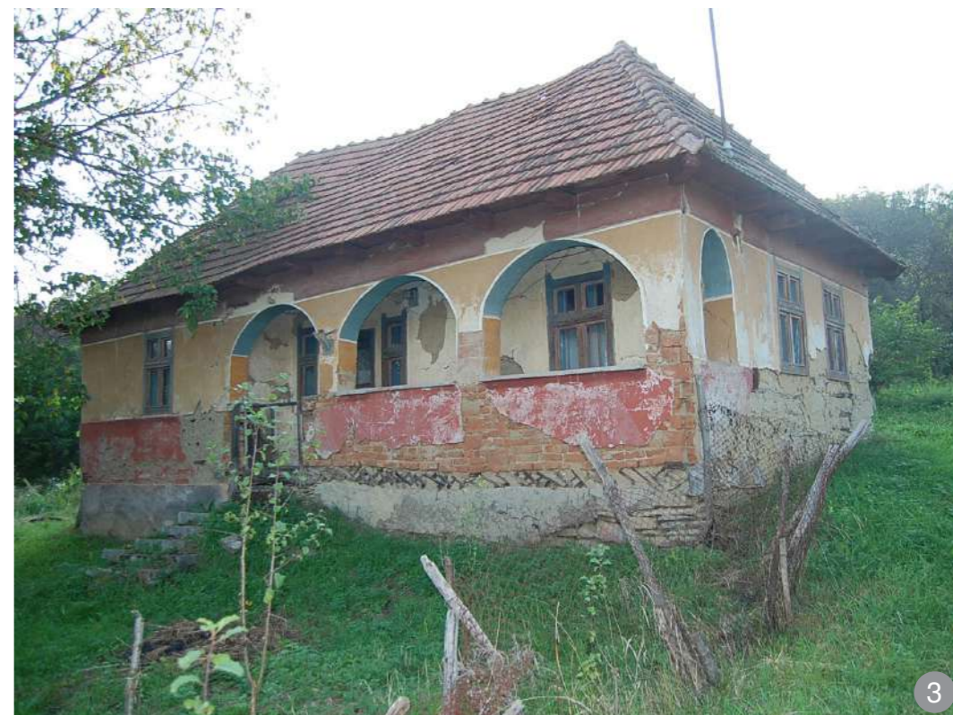
Târnaț cu arcade din zidărie la casă cu planimetria în „L”, cu pereți cu schelet de lemn.
