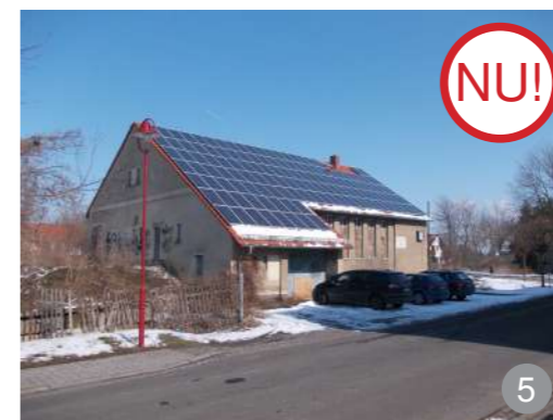
AȘA NU: Acoperirea totală a învelitorii cu panouri fotovoltaice face ca acestea să se substituie ele însele învelitorii și să influențeze într-un mod neplăcut imaginea de ansamblu a clădirii.
