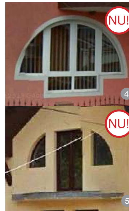
ASA NU: Nu este recomandată utilizarea ferestrelor din PVC și a celor cu forme geometrice nespecifice, cum ar fi cerc, sferă de cerc, triunghi etc. Fotografii din satele Bălan și Peceiu.
