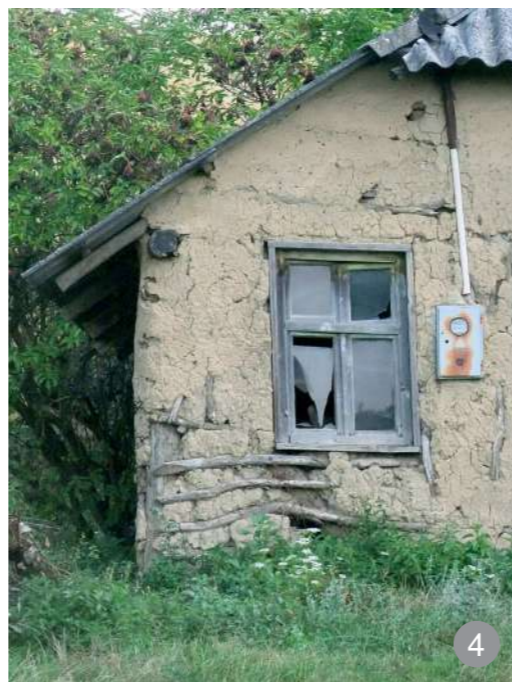
Perete cu pământ lipit între lobde (lețuri)
