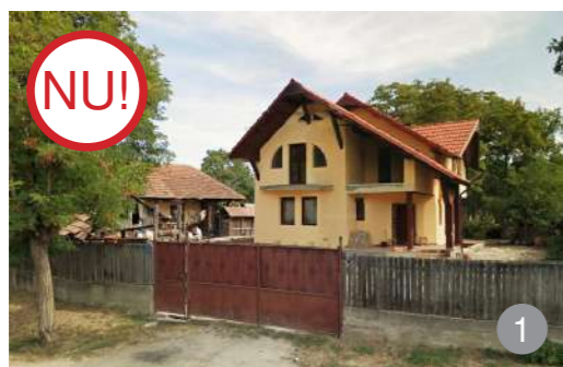
AȘA NU: Învelitoare nespecifică zonei, din țigle de beton, în satul Peceiu.
