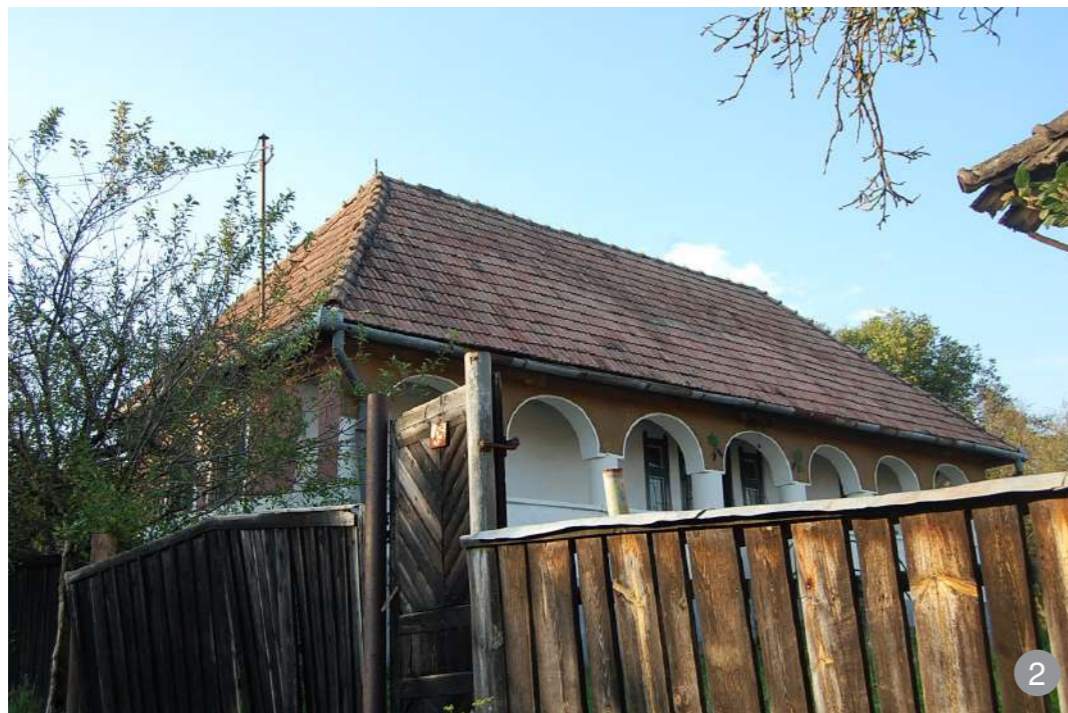
Peretele dinspre târnaț al casei este zugrăvit altfel decât fațada principală, definindu-se astfel „camera exterioară” a casei
