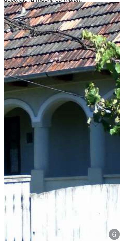
6 Stâlpi din zidărie de cărămidă sau turnat din beton la târnaț cu arcade.
