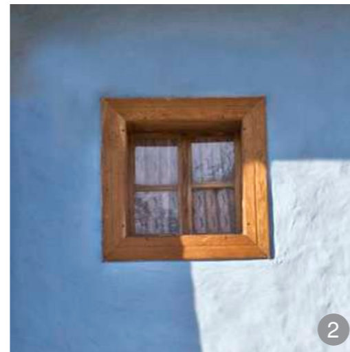
Ferestre simple cu canaturile mobile, împărțite în două, mai ales la case vechi de secol XIX.
