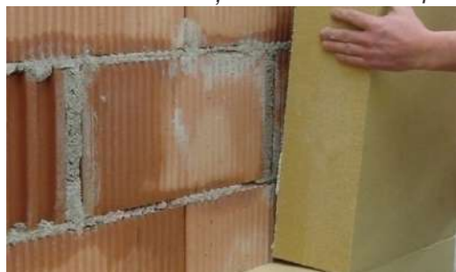
Montarea termoizolației din fibre de lemn
