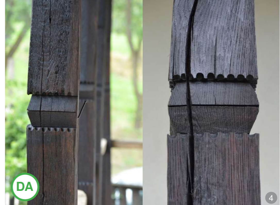
AȘA DA: Intervenție de reabilitare a unui târnaț tradițional în satul Moigrad.
