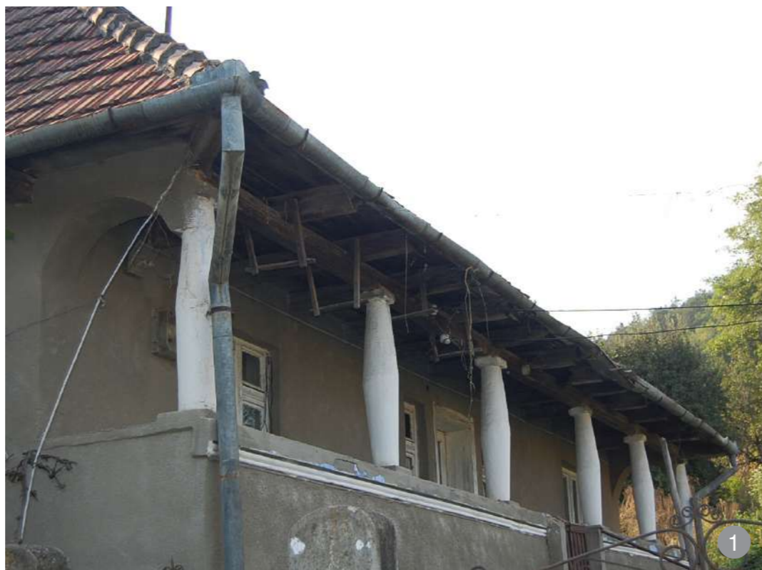
Târnaț cu șoși de lemn gablați prin tehnici de murlă. La partea superioară, de cunună, putem avea un suport pentru vie sau pentru agățat la uscat diverse lucruri și alimente.
