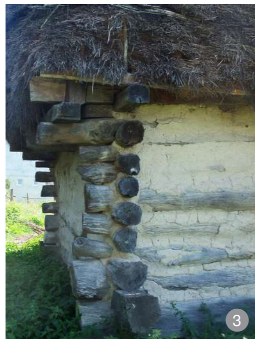
Perete din lemn rotund prins în cheutori și acoperit cu pământ
