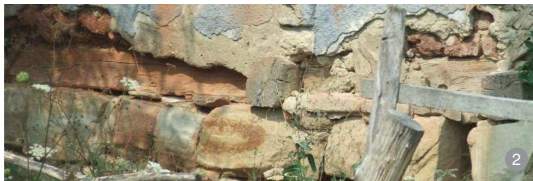
Fundație din blocuri de piatră masive așezate fără mortar
