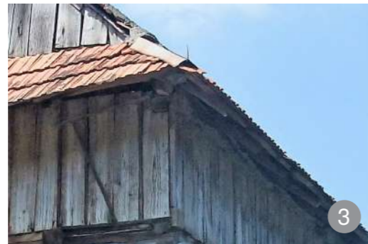
Specificul local la streșinile acoperișurilor din țiglă la o șură în estul zonei Meseș
