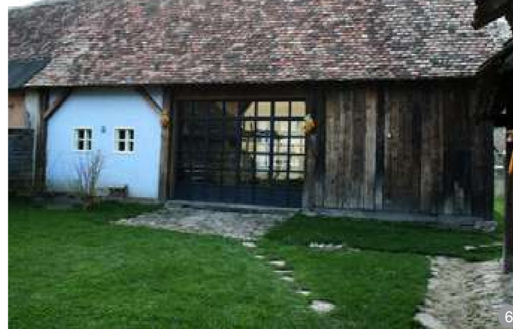
ASA DA: Alternarea unor ferestre cu o arhitectură inspirată din cultura locală cu pereți vitrați cu suprafața mare este o soluție recomandată ce ține cont atât de specificul local, cât și de nevoia de iluminare sporită a spațiilor. Acest tip de soluție poate fi utilizată în cazul reconversiei de șuri.
