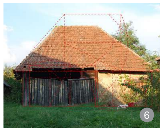
Model de șură din zona Meseș – înălțimea acoperișului este în proporție de aur față de înălțimea pereților.
