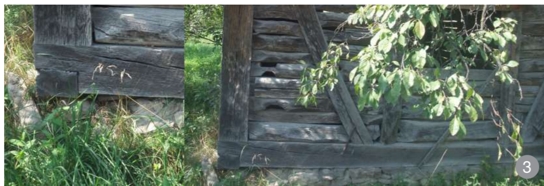
Fundație din piatră mare spartă prinsă cu mortare pe bază de pământ
