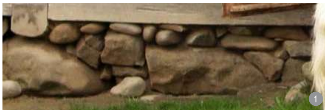
Fundație din bolovani mari de râu așezați fără mortar
