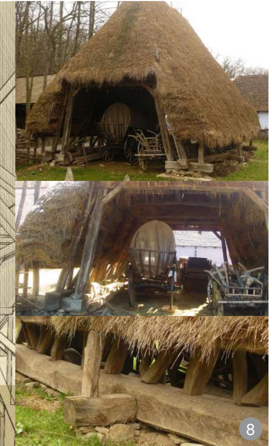
AȘA DA: Model de șarpantă pentru o construcție monovolum inspirată din șarpanta șurii tradiționale din satul Dragu, aflată acum în Complexul Național Muzeal „ASTRA”, Sibiu
