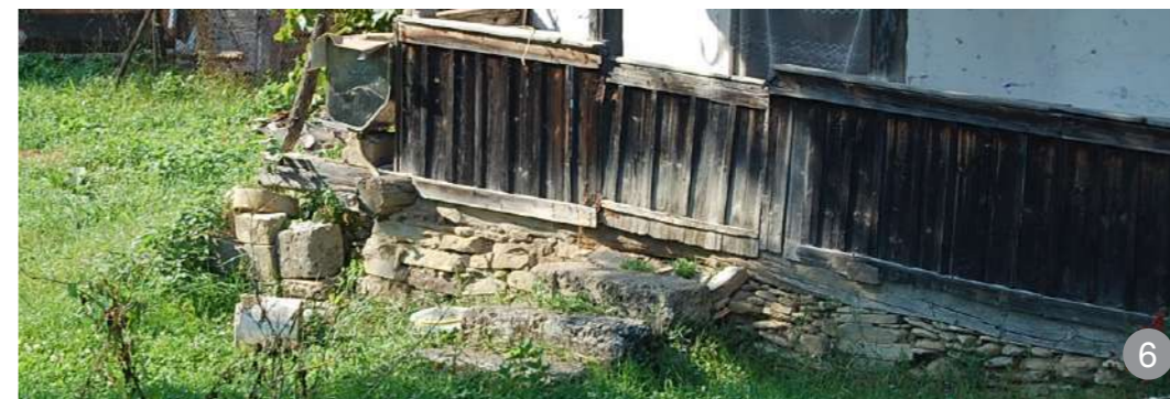
Fundație din lespezi de piatră așezate sub tălpile pereților și scări din piatră masivă
