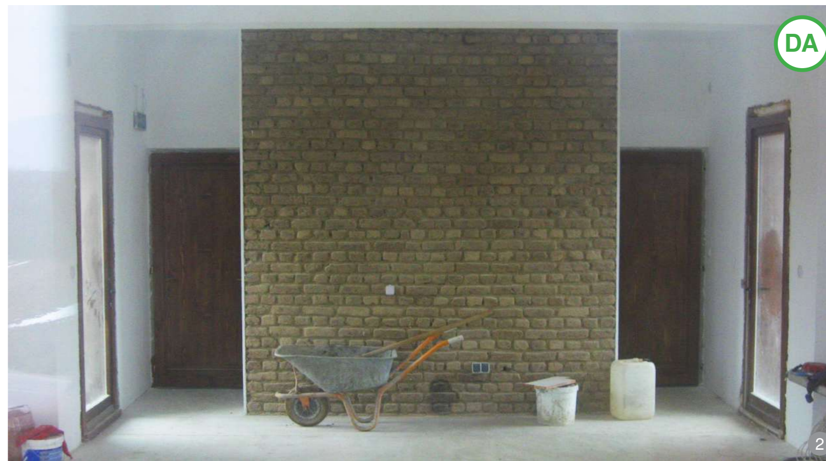
AȘA DA: Pereții din cărămidă nearsă pot înlocui cu succes alte soluții industriale de pereți și arată respect față de specificul local.
