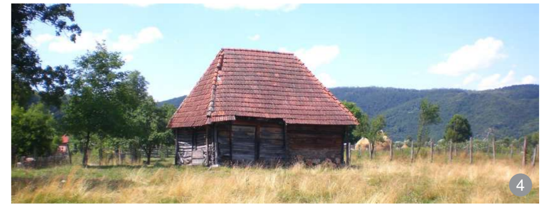
Construcții tip șură în câmp care s-au permanentizat
