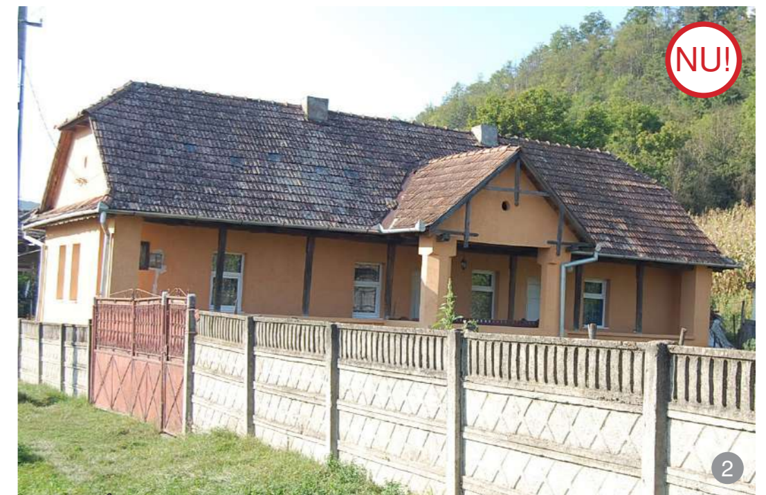
AȘA NU: În reabilitarea unei construcții tradiționale sunt interzise: tencuirea și acoperirea detaliilor prin termoizolare, folosirea unei culori nespecifice și înlocuirea ferestrelor tradiționale cu ferestre de tip termopan care nu respectă canaturile ferestrelor inițiale.
