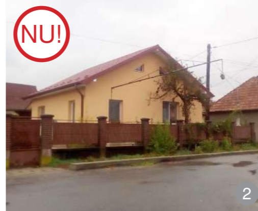
AȘA NU: Casa aceasta are o pantă prea mică a acoperișului. Intervalul recomandat este de 40°-60°.
