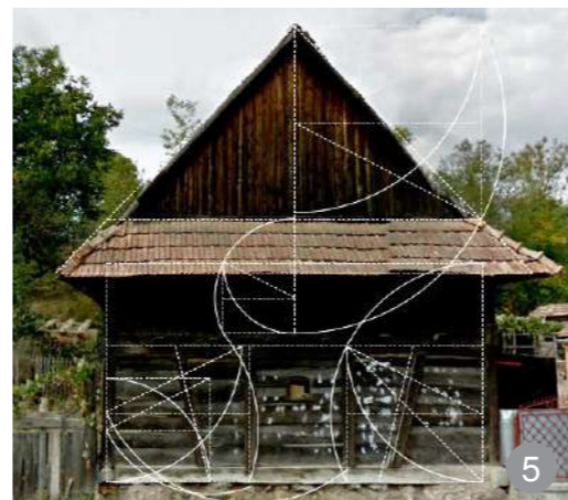
Șură din satul Zimbor – înălțimea acoperișului este egală cu înălțimea pereților.
