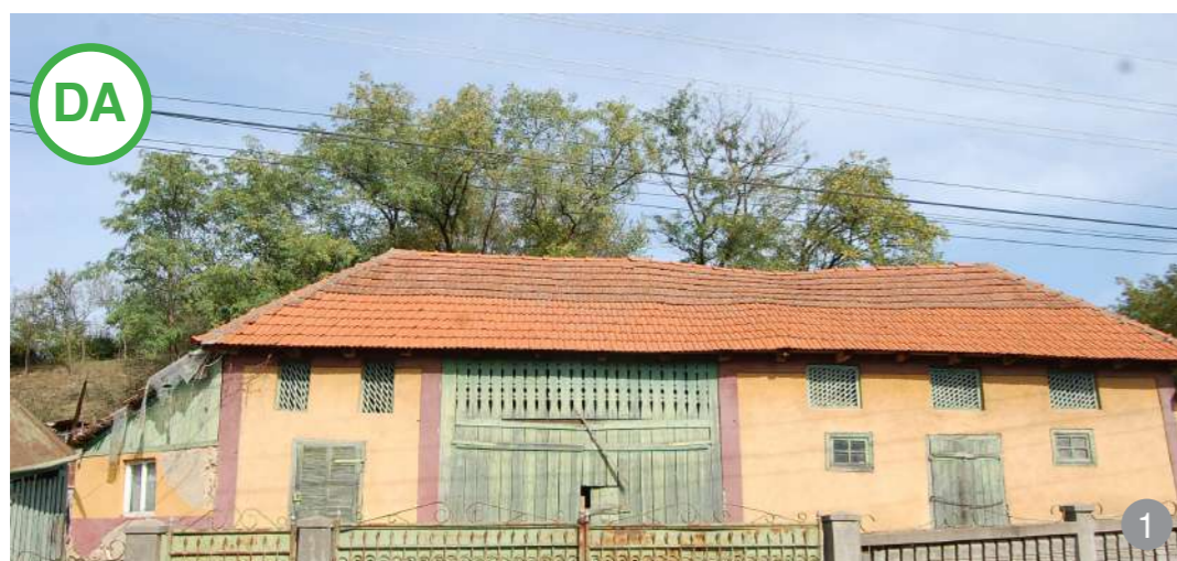
AȘA DA: Completarea țiglei deteriorate cu țiglă nouă.
