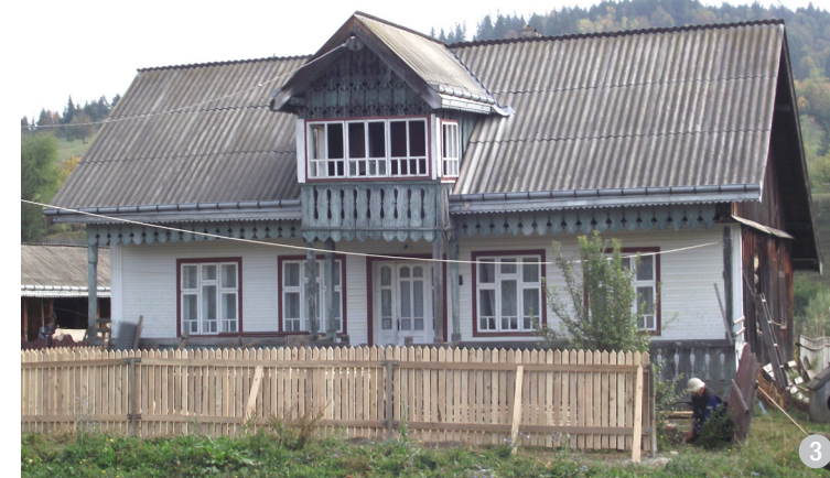
Tratarea unitară a tâmplăriei, pe fațada principală a unei case, compusă din: glasvand în dreptul accesului, cu ușă în două canaturi; ferestre în șase canaturi; închiderea cu ferestre pe întreg conturul foisorului de la nivelul podului.
