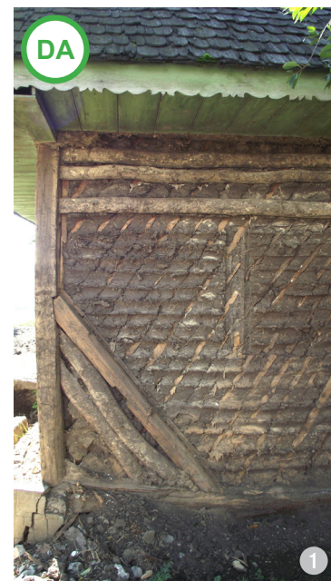
ASA DA: Perete din bârne de lemn în amnari, la o veche construcție în curs de renovare. Se observă urmele lăsate de șipcele din lemn (care vor fi înlocuite) pe care se aplica tencuiala din lut (lutuiala).
