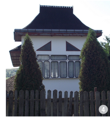
AȘA NU: Este interzisă folosirea vitrajelor de tipul „geamuri de autobuz”, obișnuite în mediul urban din zonă, la închiderea balcoanelor, precum și a ferestrelor triunghiulare dispuse pe fațadă ca în imaginea prezentată. Ferestrele triunghiulare, simetrice, sunt premise numai la lucarnele triunghiulare.
