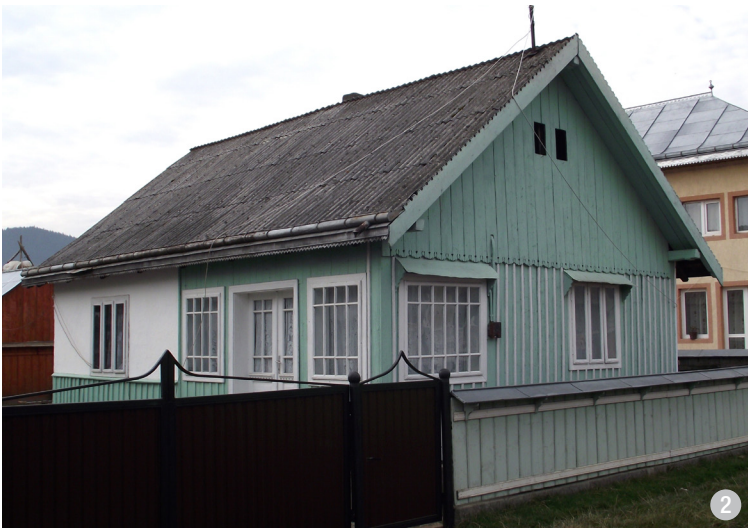
Casă fără spațiu semideschis, cu ferestre în trei canaturi și verandă închisă cu tâmplărie și geam, cu ușă în două canaturi și ferestre cu canaturi detașabile. Spațiul interior cunoscut în zonă sub denumirea de verandă derivă din tinda amplasată pe colț la vechile case și a devenit o încăpere obișnuită la multe din casele construite în secolul al XX-lea.
