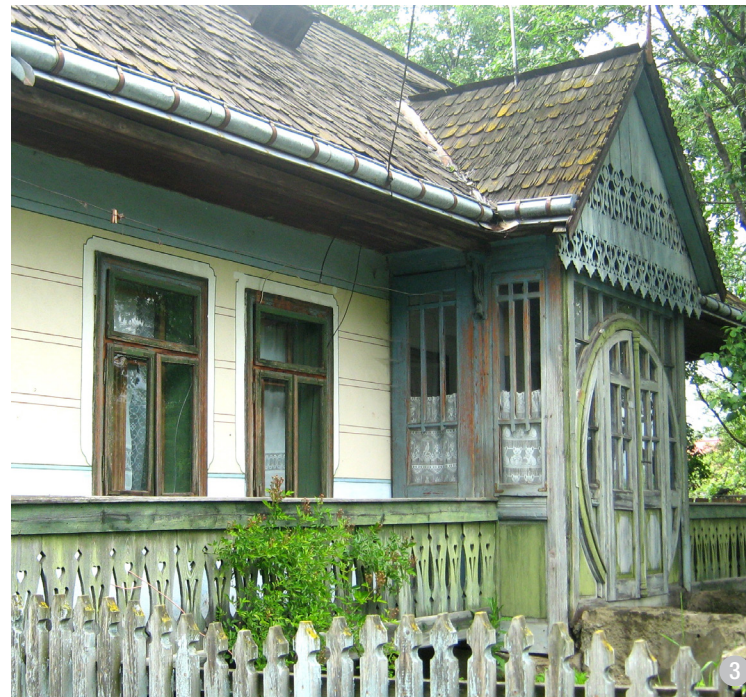
Ferestre în trei canaturi, fără ornamente, dispuse în pereche și foisor închis cu tâmplărie (denumit în zonă verănduță sau chioșc) bogat ornamentată, cu motivul dominant al cercului.
