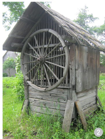
Fântână cu roată, din lemn, cu acoperiș în două ape, învelit cu draniță.
