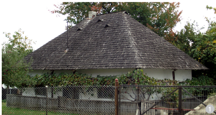
Acoperiș în patru ape la o locuință.
