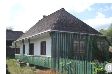
Cerdac ornamentat, dispus pe fațada principală a casei. Peretele fațadei principale este tencuit și văruiț iar cel al fațadei laterale din dreapta este placat cu scânduri de lemn, fiind expus vântului dominant.
