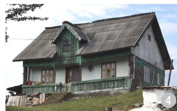
Prispă dispusă pe fațada principală a casei, cu fronton în dreptul intrării. Stâlpii sunt ornamentați prin crestare iar balustradele și frontonul sunt ornamentate prin traforare. Peretele fațadei principale este tencuit și văruiț iar cel al fațadei laterale din dreapta este placat cu șindrilă, fiind expus vântului dominant.
