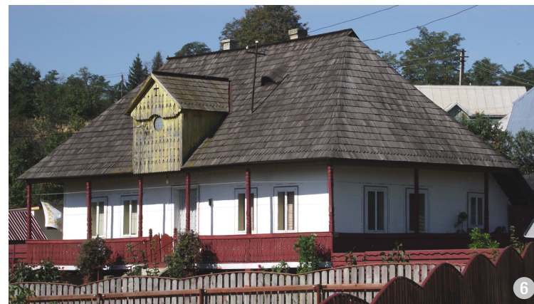
Acoperiș în patru ape, la o locuință, cu extensie în două ape peste cerdac, în dreptul intrării.
