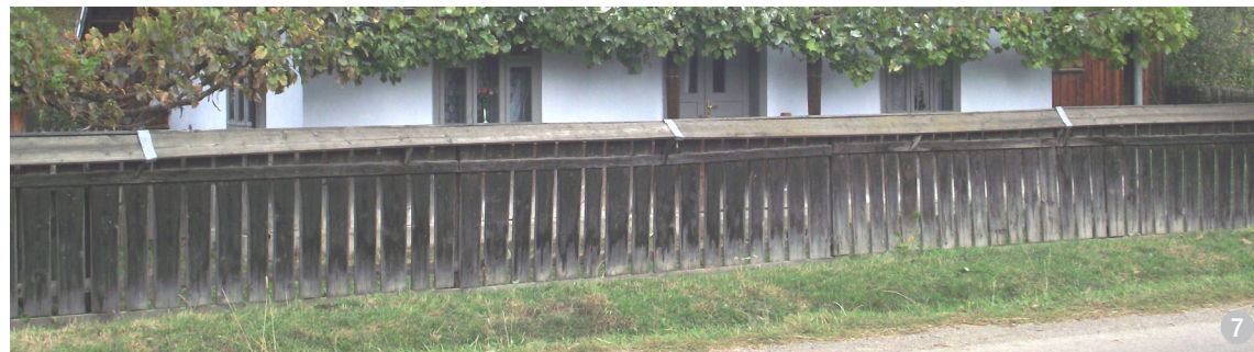
Gard semitransparent din scânduri montate vertical, ușor distanțate și acoperit tot cu scânduri.
