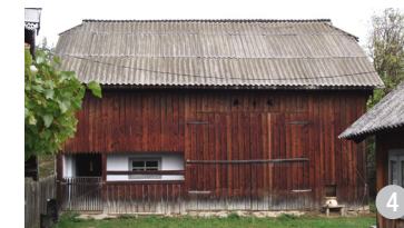
Șură din zona montană, cu prispă.
