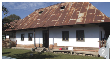
Prispă cu stâlpi doar în dreptul intrării casei, acoperită cu streșini largi. Pereții sunt tencuiți și văruiți.
