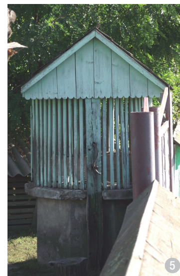
Fântânile din interiorul gospodăriilor sunt amplasate de cele mai multe ori adjacent gardului dinspre stradă. Fântâna cu roată din imagine, are ghizdul din beton, închidere cu grilaj din lemn și acoperiș în două ape.
