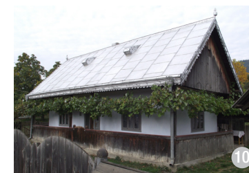
Prispă care înconjoară casa pe trei laturi, cu stâlpi și balustrade, fără ornamente. În spatele casei, la dreapta, prispa se termină cu o lărgire asemănătoare unei terase, utilizată în sezonul cald. Pereții sunt tencuiți și văruiți.
