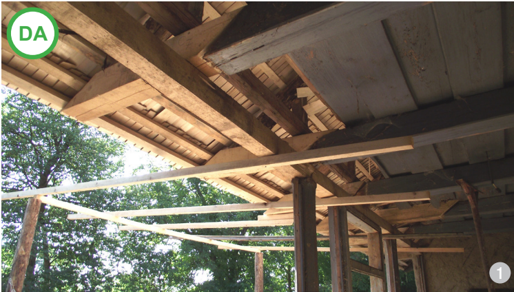
AȘA DA: Înlocuirea elementelor deteriorate la o șarpantă din lemn a unei vechi case, în curs de restaurare.
