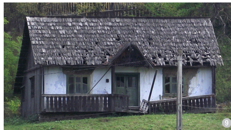
Acoperiș în două ape, la o locuință, cu extensie în două ape peste cerdac, în dreptul intrării.
