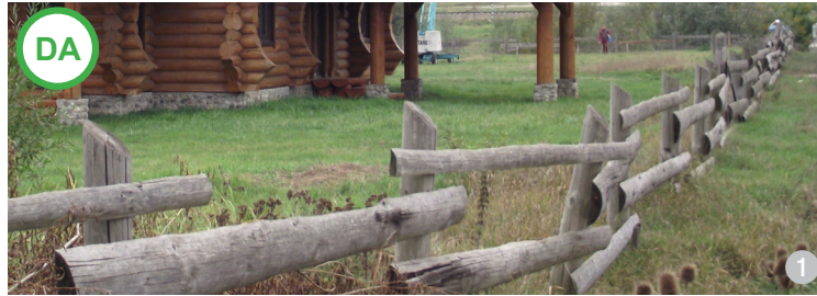
AȘA DA: Gard nou, având rol doar de delimitare, cu stâlpi din lemn rotund și leașuri din lemn semirotund, realizat în manieră tradițională.
