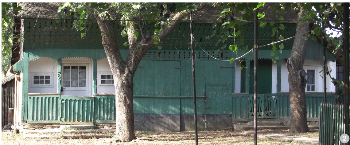
Fațada unei șuri cu sân, multifuncționale (în acest caz șura conține și o cameră de locuit), cu: ușă într-un canat, cu geam și ferestre într-un canat, orizontale (stânga); ușă într-un canat, plină și fereastră în două canaturi, verticală (dreapta); poartă de acces la grajd, în două canaturi, cu porțiță amplasată într-unul din canaturi (centru).
