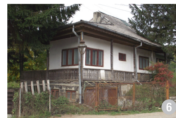
Prispă ornamentată, cu stâlpi și balustrade, ridicată de la sol deasupra unei pivnițe și care este dispusă pe trei laturi ale casei. Pereții sunt tencuiți și zugrăviți.
