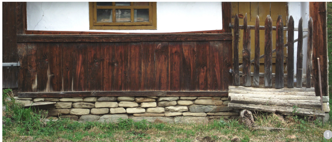
Soclul – elevația unei fundații din zidărie de piatră, fără mortar, la o șură.
