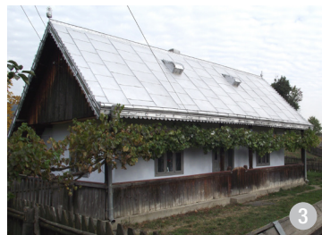
Acoperiș în două ape la o locuință.
