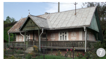
Acoperiș în două ape, la o locuință, cu extensie în două ape peste foisor.
