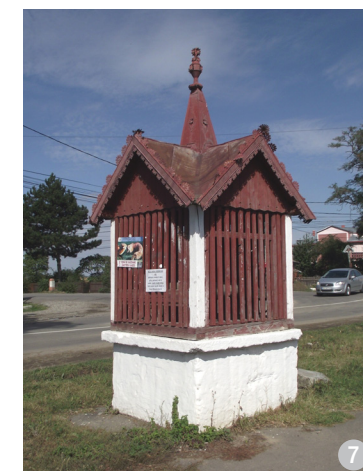
Fântână cu roată, în spațiul public, cu ghizdul din beton, văruiț și închiderea semitransparentă împreună cu acoperișul, din lemn, vopsite.
