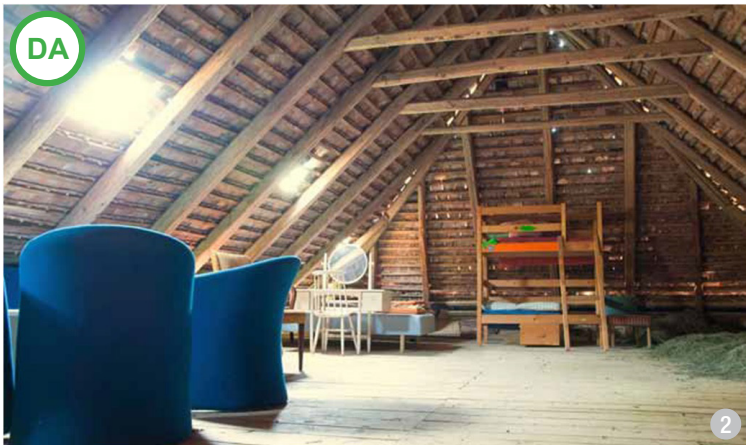
AȘA DA: Șarpanta originală rămasă vizibilă la o dotare comunitară amenajată într-o șură.
