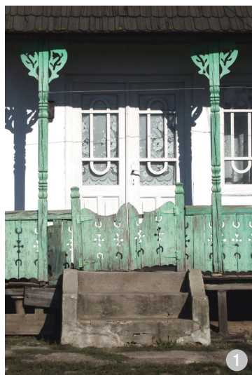
Scară exterioră de acces, din beton.
