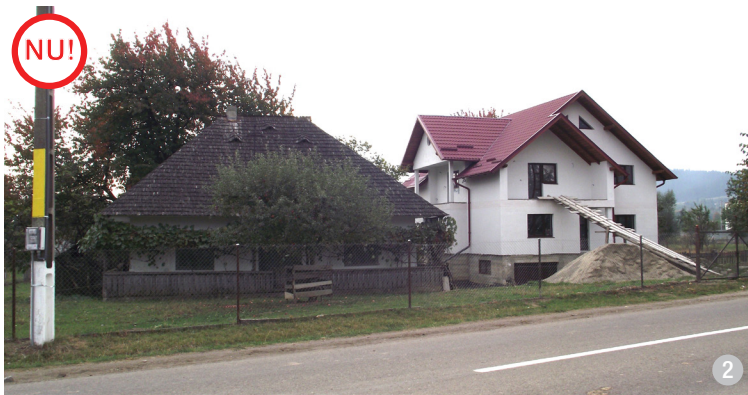
AȘA NU: Amplasarea unei clădiri noi, masivă și complicată, foarte aproape de o casă țărănească de certă valoare arhitecturală locală, dăunează imaginii de ansamblu a gospodăriei dar și a satului.
