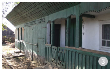
Șură cu sân, multifuncțională, cu prispe ornamentate. Pereții corespunzători prispelor sunt lutuți și văruiți.
