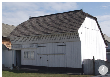
Acoperiș în două ape, cu capetele coamei teșite, la o șură „cu sân”.
