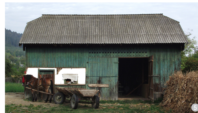
Șură simplă, în zona montană. Grajdul se evidențiază prin pereții din paiantă, văruiți.
