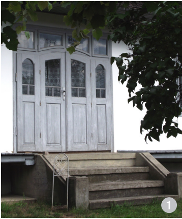
Ușă de acces în patru canaturi pliante două câte două și supralumină, cu un desen elaborat.
