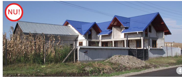
AȘA NU: Exemple care ilustrează tendința, frecventă în zonă, de întemeiere a noilor gospodării. Dacă șura respectă specificul arhitecturii locale, locuința este total ruptă de caracteristicile așezării, prin volumetria complicată, materiale și culori.
