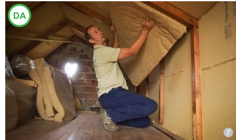
ASA DA: Termoizolația din cânepă - montare rapidă și simplă. Nu este necesar un costum de protecție deoarece produsul nu irită pielea și nu conține substanțe periculoase mediului sau sănătății.
