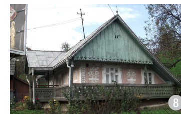
Cerdac amplu, cu foișor. Terminația inferioară a placajului din scânduri al timpanului podului și balustradele sunt ornamentate prin traforare. Ornamentele pereților sunt din stucatură.
