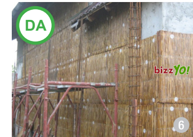
ASA DA: Perete placat cu panouri termoizolante din stuf.
