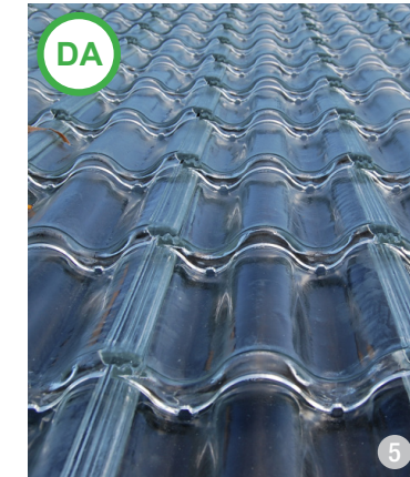
AȘA DA: O tehnologie actuală, care e în curs de răspândire în zonele rurale este cea a țiglelor solare. Acestea pot fi un bun înlocuitor al acoperișurilor clasice, pentru că vor avea pe lângă calitatea pe care orice acoperiș trebuie să o aibă și pe cea de a produce energie. Pe de altă parte, nu fac notă discordanta ca și culoare cu vecinătățile prin stratul suport care este de culoarea țiglelor naturale și textura mată obligatorie.
