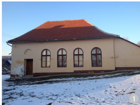
ASA NU: Reabilitarea unui cămin cultural prin izolarea cu polistiren. Folosirea polistirenului atrage după sine probleme legate de condens, igrasie, apariția mușgaiului și este un material ușor de vandalizat de către copii, animale, persoane agresive etc.
