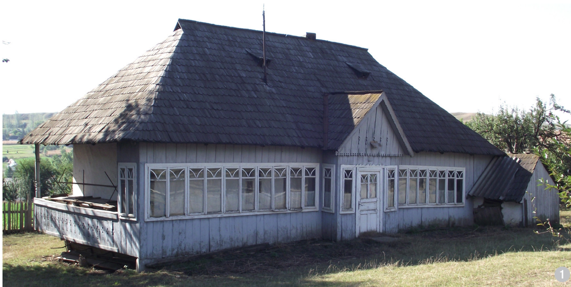
Prispă și foisor închise cu tâmplărie și geam pe toată lungimea fațadei principale. Motivul decorativ al șprosurilor de la partea superioară a tâmplăriei are o răspândire relativ mare în zonă.
