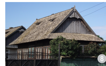
Acoperiș în două ape la o locuință, cu prelungirea streșinii sub timpane.
