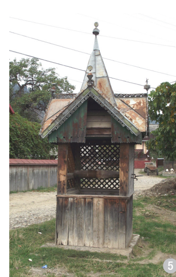
Fântână cu roată, în spațiul public, cu ghizdul, închiderea semitransparentă și acoperișul (cu formă elaborată, de inspirație gotică) din lemn. Învelitoarea din tablă este recentă.
