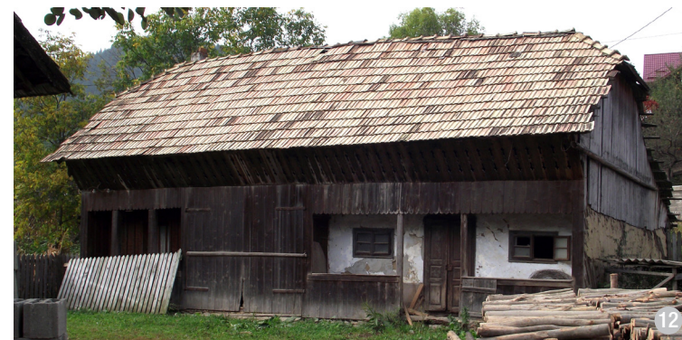
Învelitoare de țiglă ceramică profilată trasă.
