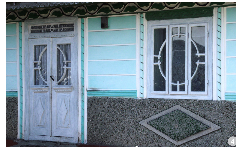
Ușă de acces în două canaturi, cu supralumină și fereastră în trei canaturi, ambele ornamentate, cu motivul cercului la suprafețele vitrate și cu motivul rombului la tablă.
