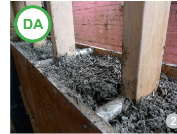
ASA DA: Casă cu structură de lemn și pereți din amestec de cânepă cu var - denumirea materialului este Hempcrete (Hemp-Lime).
