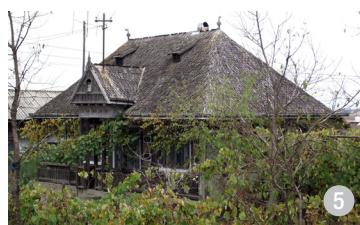
Acoperiș în patru ape, la o locuință, cu extensie în două ape peste foisor.
