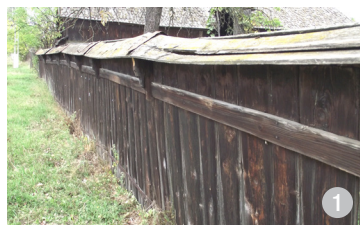
Gard vechi, opac, din scânduri montate vertical și acoperit tot cu scânduri.
