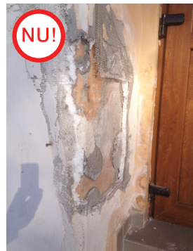
ASA NU: Reabilitarea unui cămin cultural prin izolarea cu polistiren. Folosirea polistirenului atrage după sine probleme legate de condens, igrasie, apariția mușgaiului și este un material ușor de vandalizat de către copii, animale, persoane agresive etc.
