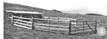
Împrejmuire din leațuri, cu contravântuiri, la o strung de oi.
