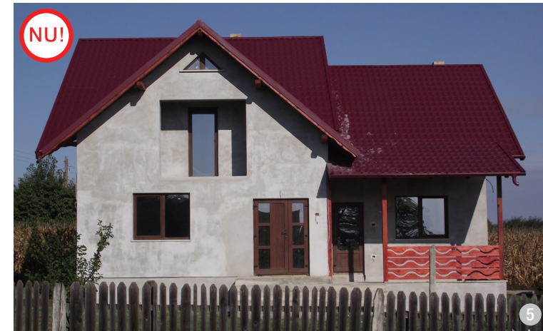
AȘA NU: Exemplu de clădire nouă cu caracteristici neconforme tradiției locale: dispunerea dezordonată, întâmplătoare, a golurilor în fațadă; ușa principală de acces cu canaturi inegale și dispunerea nepotrivită a ochiurilor de geam în canaturi; folosirea tâmplăriei de PVC cu aspect de lemn (imitație de lemn).
