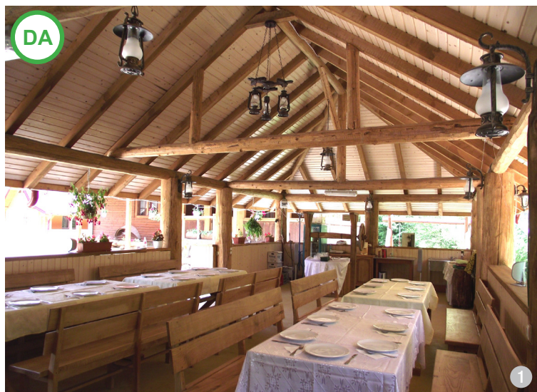
AȘA DA: Șarpantă din lemn rotund, la o terasă nouă acoperită.
