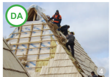
AȘA DA: Șindrila și șita, tradiționale, pot fi folosite la construcțiile noi atât pentru învelitoare, cât și ca placaj vertical.
