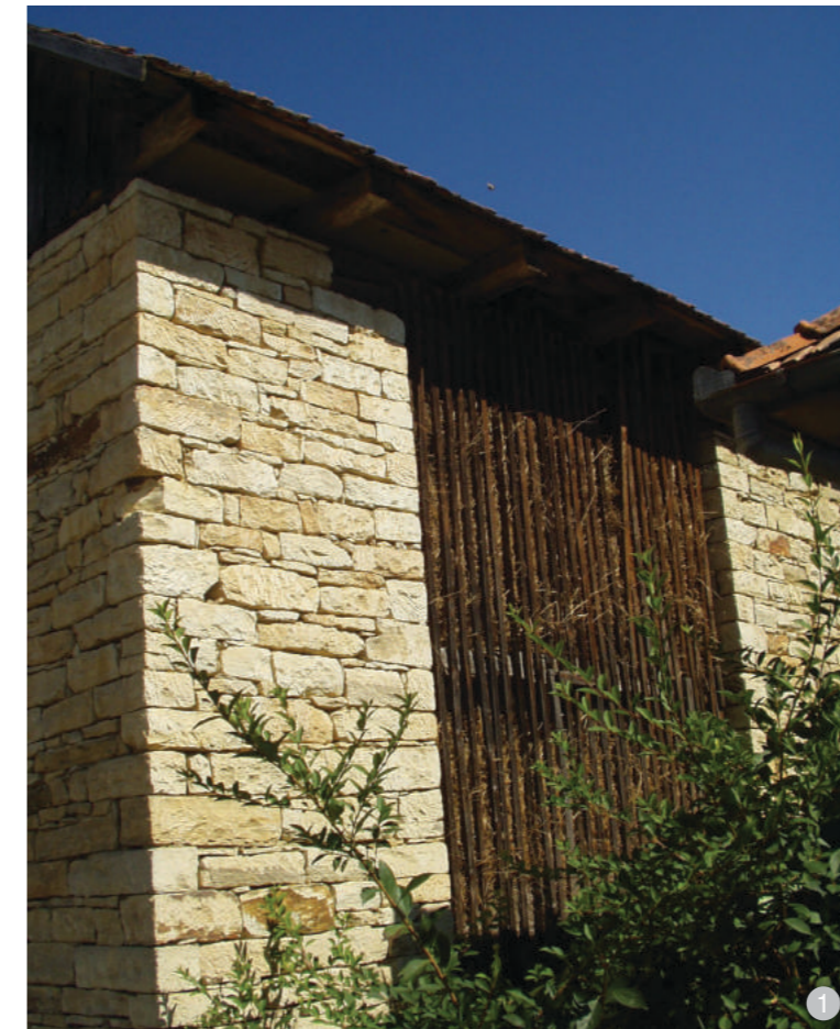
Detaliu de compunere a peretelui: zidărie de piatră cioplită, blocuri dreptunghiulare de diferite dimensiuni, cu o față prelucrată
