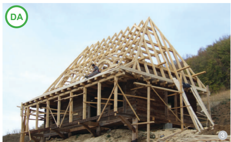
AȘA DA: Refacerea șarpantei vechi este uneori necesară, atunci când elementele vechi din lemn au fost afectate de infiltrații sau de alte tipuri de degradări. Cu această ocazie, poate fi schimbată panta acoperișului, în vederea refuncționalizării (adăugarea unor spații de locuit în mansardă), cât și pentru o mai bună adaptare la condițiile climatice locale.
