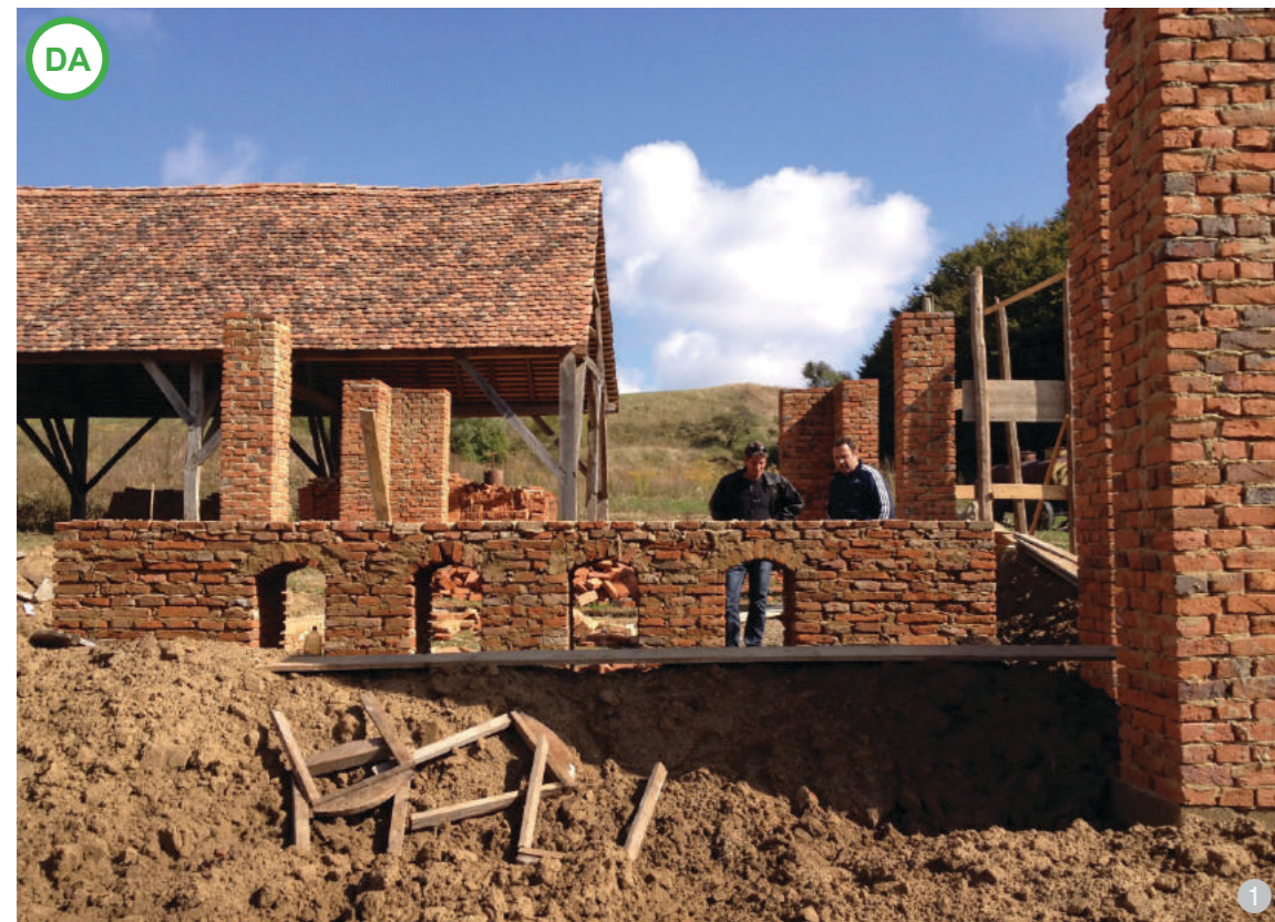
AȘA DA: Construcție nouă cu pereți și stâlpi din cărămidă și beton: cărămida tradițională, prin dimensiunile ei mici, se adaptează ușor la orice configurație planimetrică, chiar și în detalii.
