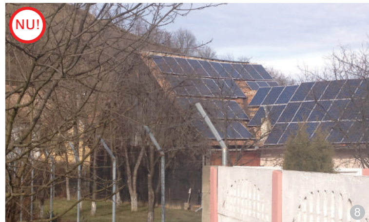
AȘA NU: Nu se recomandă acoperirea a mai mult de 25 % din suprafața unui versant al acoperișului cu panouri fotovoltaice, deoarece acest lucru ar afecta într-un mod neplăcut imaginea de ansamblu a clădirii și a vecinătăților, așa cum se poate observa în exemplul din imaginea 8.
