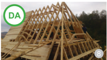
AȘA DA: Șarpantă nouă cu lucarne
