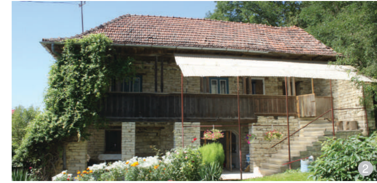
Pereți masivi din piatră, atât la nivelul demisolului, cât și al parterului
