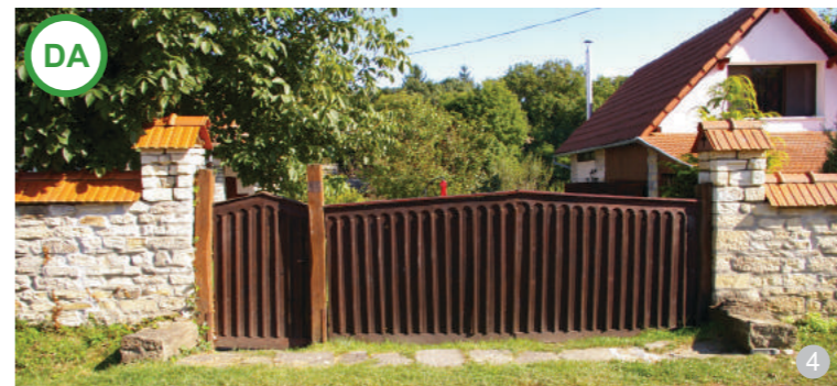
AȘA DA: Restaurarea și întreținerea porții vechi reprezintă cea mai indicată soluție în cazul în care degradările nu sunt majore.
