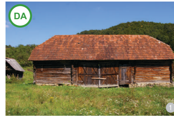
ASA DA: Șură realizată din bărne de lemn, cu acoperiș în două ape și fronton țeșit
