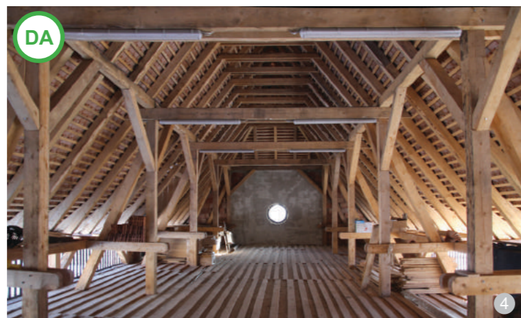
AȘA DA: Interiorul unui pod: structura spectaculoasă a șarpantei poate face parte din compoziția arhitecturală a amenajării spațiului.
