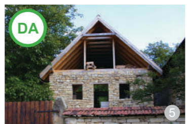
AȘA DA: Intervenția păstrează dimensiunile și înclinația tradițională a acoperișurilor din zonă. Se recomandă totuși păstrarea unei perechi de căpriori-martori din structura existentă.
