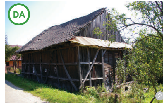
ASA DA: Șură pe două niveluri: șură și grajd din piatră sub nivelul străzii și fânar din lemn la nivelul străzii, în satul Panticeu
