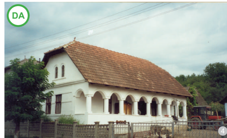
Acoperiș în două ape cu învelitoare din țiglă ceramică, cu fronton teșit de influență barocă. Acest tip de acoperiș se găsește pe tot cuprinsul zonei studiate, preponderent în cazul locuințelor.
