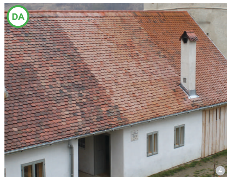
AȘA DA: Țigla nouă care respectă dimensiunile și forma celei tradiționale este recomandată la reabilitarea unei construcții existente.
