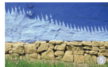
Detaliu de parament al unei case din lemn: tencuială din lut cu armătură din nuiele
