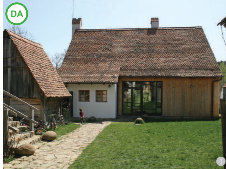
AȘA DA: Amenajarea unor încăperi cu funcțiuni noi în interiorul construcțiilor existente
