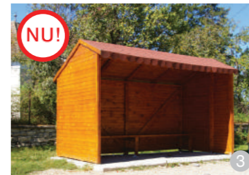
AȘA NU: Exemplu negativ de stație de autobuz, din lemn bălăuit cu o culoare stridentă și acoperită cu o învelitoare nespecifică zonei rurale
