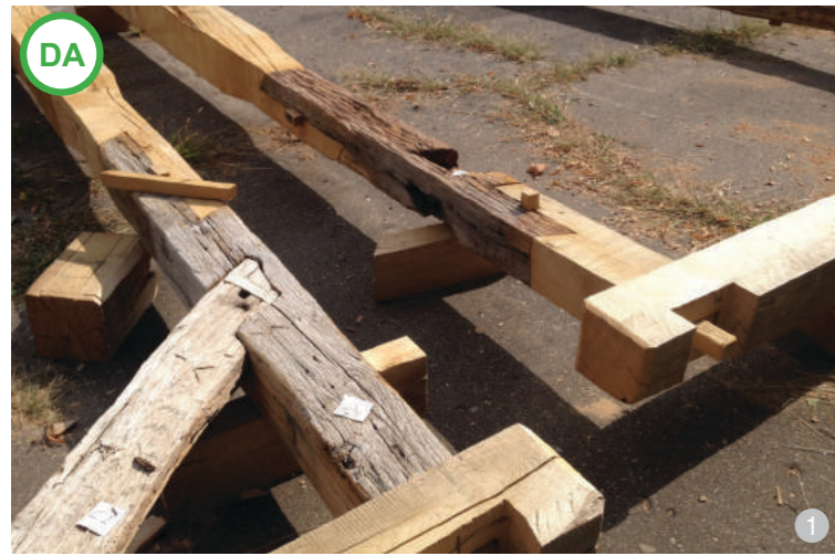
AȘA DA: Cadre tradiționale din lemn în timpul restaurării: un element parțial degradat poate fi reparat și refolosit.
