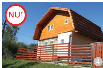
AȘA NU: Nu se recomandă adoptarea unor forme de acoperiș nespecifice.
