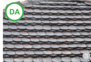
AȘA DA: Șarpantă nouă cu lucarne
