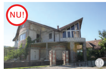
AȘA NU: Volumetria agresivă a acoperișului clădirii noi contrastează puternic cu clădirile din vecinătate.
