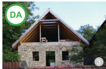
AȘA DA: Exemplu de șarpantă nouă rezolvată corect peste o șură existentă din satul Chidea
