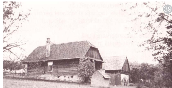
Fig. 38, 39: Gospodărie pe trei laturi, alcătuită din casă (fără crosnie, cu foisor), șură și polatră; sat Predeluț, comuna Bran.
