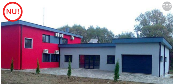
AȘA NU: Folosirea acoperirii generale de tip terasă este interzisă, motivul fiind neîncadrarea în specificul local, atât prin formă, cât și prin aspectul învelitorii. Suplimentar, soluția de terasă poate aduce cu sine probleme de infiltrație a apei, dacă nu este pusă în operă corect.
