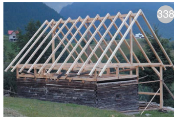
fig. 338: Reparare la o casă veche din bărne din satul Peștera.
