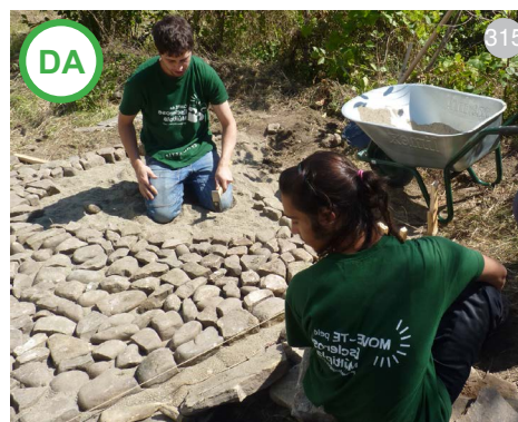
AȘA DA: Pavaj din piatră de râu așezată pe un strat suport din nisip. Lucrarea a fost executată de voluntari în cadrul unui atelier de învățare a tehnicilor de construire tradiționale.
