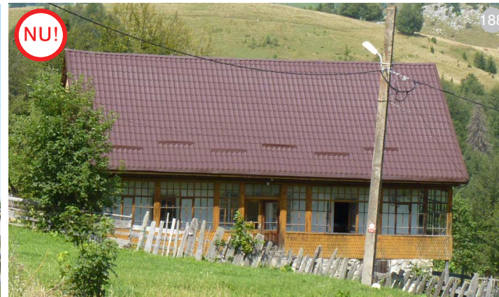
AȘA NU: Învelitoare din tablă la o casă tradițională; Aspectul artificial al învelitorii contrastează puternic cu peisajul dominat de elementul natural.
