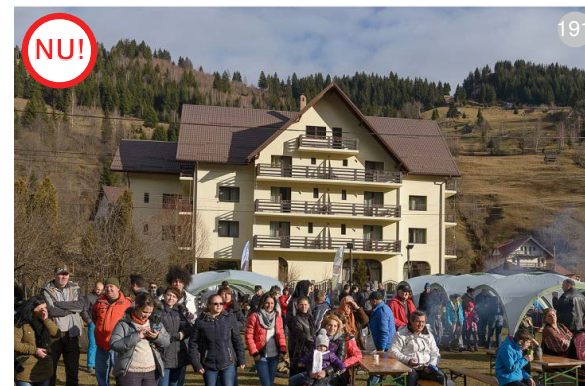
AȘA NU: Chiar dacă se prevăd balustrade din lemn, balcoanele nu sunt elemente specifice zonei și conferă clădirii un aspect de locuință colectivă din mediul urban. Clădirea deranjează prin masivitate, proporții, repetitivitatea anostă a elementelor de fațadă.
