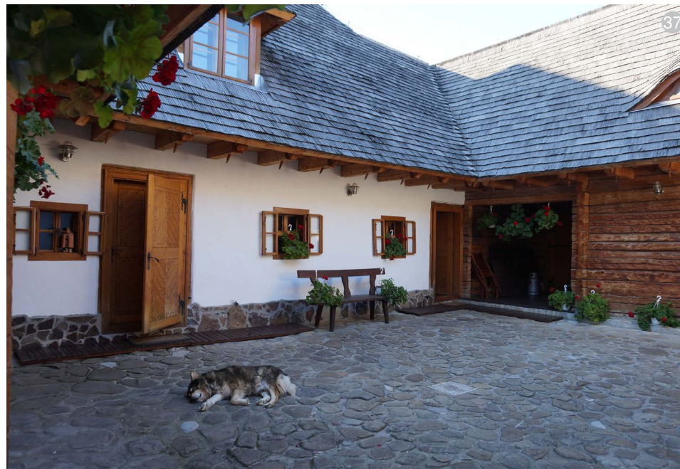
Fig. 37: Conacul Balaban - vedere de la interiorul curții.
