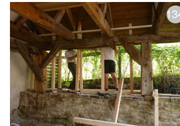
AȘA DA: Casă cu structură din lemn și pereți din baloți de paie.
