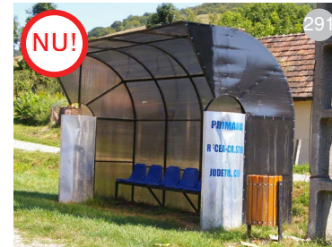
AȘA NU: Prin forma și materialele nespecifice (plastic și metal), această stație de autobuz este un element deranjant în imaginea străzii.
