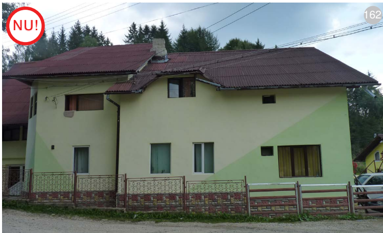
AȘA NU: Clădire cu aspect incoerent, cu tencuieli și cromatică ce trimit către arhitectura suburbană.
