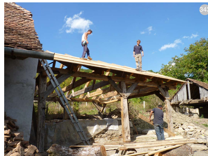
fig. 339-343: Imagini de pe șantiere ce implică utilizarea tehnicilor și materialelor de construcție tradiționale.
