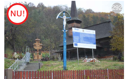
AȘA NU: Se va evita montarea defectuoasă a panourilor obligatorii de identificare a investiției. Ele blochează vizual clădirea, degradându-i imaginea.
