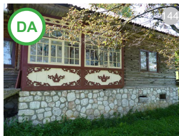
Fig. 144: Soclu din piatră fățuită, cu mortar de var hidraulic;
