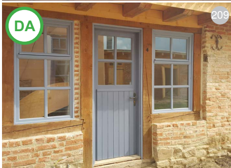
AȘA DA: Tâmplărie nouă executată pentru o extindere la o casă tradițională.
