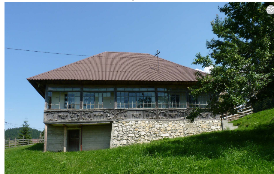
Fig. 52: Gospodărie cu curte deschisă; casă pe două nivele, cu sală (prispă) cu decor traforat, închisă cu geamlâc, având pivniță la primul nivel; sat Fundata, comuna Fundata.
