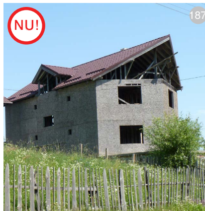
AȘA NU: Imaginea clădirii este străină de context. Forma acoperișului și învelitoarea de tablă ce imită țigla contribuie la aspectul disonant.
