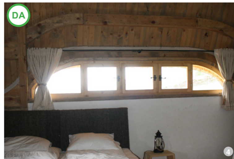
AȘA DA: Soluția de lucarnă realizată foarte estetic și discret, asigură necesarul de lumină și ventilare a spațiului mansardei.
