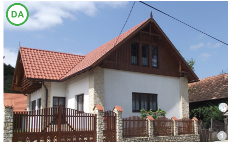
AȘA DA: Amplasarea ferestrelor în găurile de aerisire a podului nu modifică cu nimic aspectul general al locuinței. (imagine din satul Tetișu)
