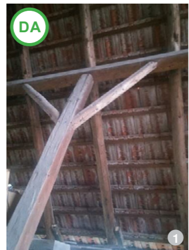
AȘA DA: Pentru construcții cu funcțiuni industriale cu deschideri mari, se pot folosi sisteme structurale combinate, atât metal, cât și lemn, pentru a permite utilizarea unor materiale locale pentru finisaje și învelitori, precum țigla și lambriul.
