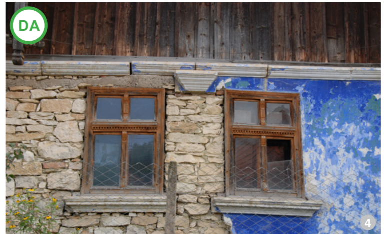
AȘA DA: Zidurile din piatră tencuite cu mortare pe bază de var reprezintă două tipuri de materiale compatibile.
