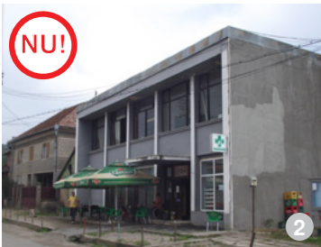
ASA NU: Folosirea acoperirii generale de tip terasă este interzisă în satele tradiționale, motivul fiind neîncadrarea în specificul local, atât prin formă, cât și prin aspectul învelitorii pe care o presupune utilizarea acestui tip de acoperire. Suplimentar, soluția de terasă poate aduce cu sine probleme de infiltrație a apei dacă nu este pusă în operă foarte bine, evenimentele multiple de acest gen confirmând afirmația noastră (imagine din satul Mera).
