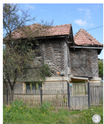
Casă cu pereți din blănuri, stâlpi din lemn, peste care s-au așezat scânduri, pentru o priză mai bună a tencuiei (imagine din satul Leghia).
