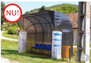
NU! Exemplu negativ de stație de autobuz din lemn băuit cu o culoare stridentă și acoperită cu o învelitoare nespecifică zonei rurale
