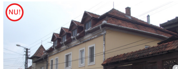
AȘA NU: Lucarnele așezate spre stradă sunt agresive și nu oglindesc specificul zonei, panta acoperișului este prea mică (imagine din satul Mera).
