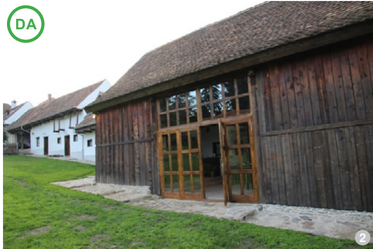
AȘA DA: Inexistența în trecut a unor ferestre pentru funcțiuni precum baie, mansardă, restaurant etc. poate lăsa loc liber unei abordări creative în acest domeniu – imaginea este dintr-un proiect realizat cu finanțare europeană.
