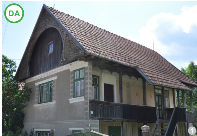
AȘA DA: Timpan realizat din lemn, cu decoruri tradiționale și specifice zonei. Pe latura cu târnațul, învelitoarea este prelungită pentru a oferi protecție zonei de acces.
