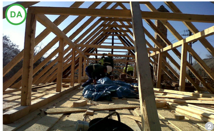
AȘA DA: Șarpantă realizată cu „scaun” specific construcțiilor cu deschidere mare (imagine din satul Roșia Montană)
