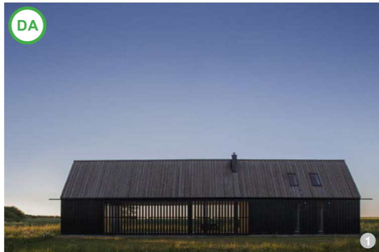
ASA DA: Necesitatea de lumină poate constitui un factor decisiv în arhitectura fațadei. Pereții vitrați pot fi dublați de un element de umbrire din lemn, care trimite la detaliile de închidere a construcțiilor tradiționale.
