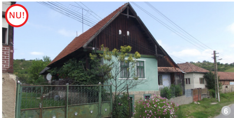
AȘA NU: Zugrăvelile moderne sunt incompatibile cu materialele de construcție tradiționale (lemn, piatră, cărămidă), deoarece împiedică transferul de vapori de apă dinspre interior spre exterior. Acest lucru va duce, în timp, la deteriorarea peretelui și a finisajului exterior (imagine din satul Bicălatu).
