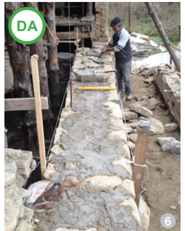
Folosirea pietrei pentru zidurile și fundațiile construcțiilor noi este optimă în zonele cu umiditate mare.
