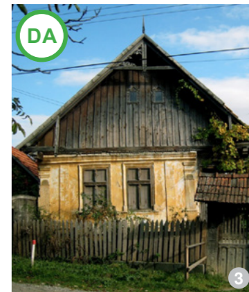
Înălțimea pereților este egală sau mai mică decât înălțimea acoperișului (imagine din satul Alunișu).
