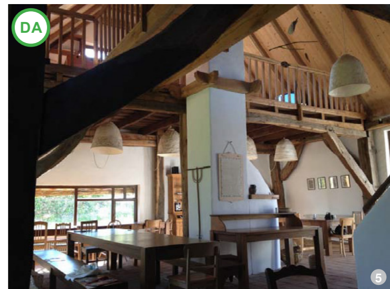
ASA DA: Dublarea căpriorilor este uneori necesară, dar nu obligatorie, atunci când este necesară termoizolarea spațiilor.
