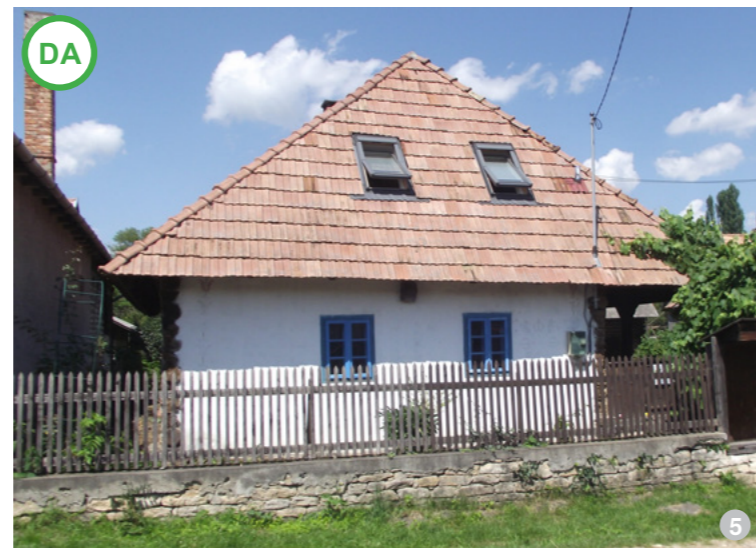
AȘA DA: Construirea unui acoperiș nou peste o clădire aflată în ruină propune un concept interesant privind intervenția contemporană vizibilă asupra unei clădiri tradiționale. În mod normal, modificarea unui acoperiș existent în acest fel ar fi contraindicată pentru clădirile tradiționale (imagine din satul Mănăstireni).
