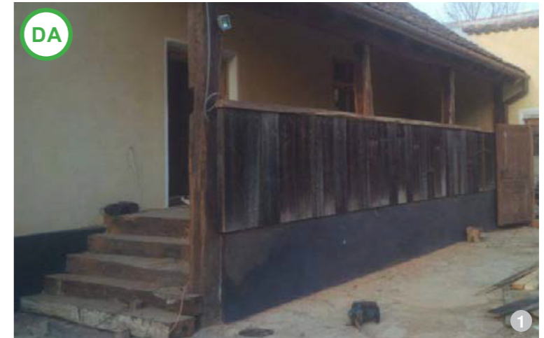
AȘA DA: Realizarea unei prispe la o clădire nouă s-a făcut fără preluarea ornamentației locale.
