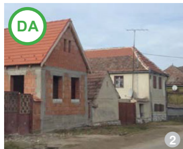
AȘA DA: Ritmul golurilor construcției noi respectă ritmul impus de clădirile vecine.
