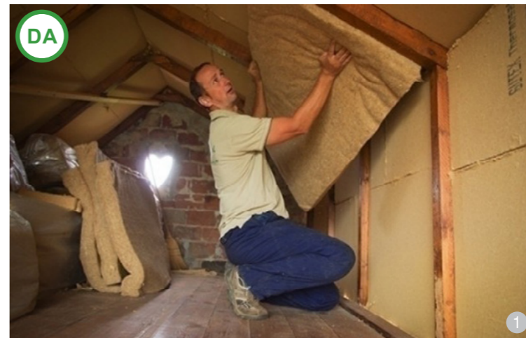
DA AȘA DA: Termoizolația din cânepă: montare rapidă și simplă. Nu este necesar un costum de protecție, deoarece produsul nu irită pielea și nu conține substanțe periculoase pentru mediu sau sănătate.
