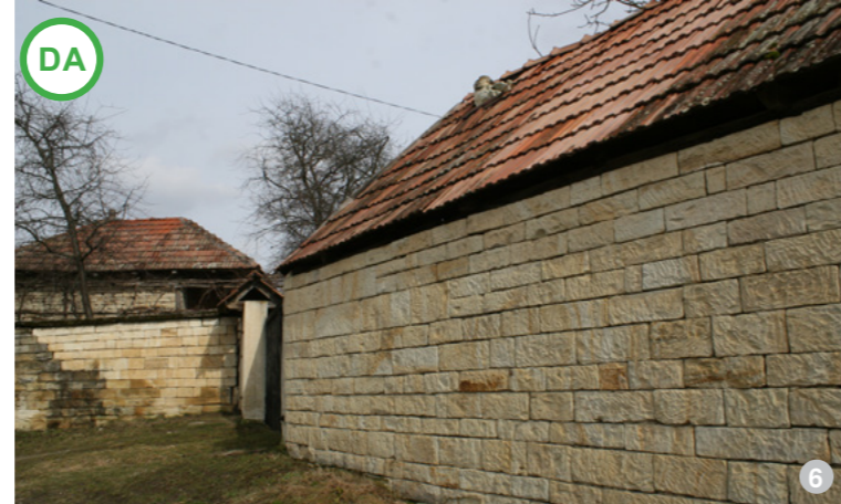
ASA DA: Țigla industrială trasă, cu formă și dispunere specific locale, poate constitui o variantă pentru acoperirea construcțiilor noi de gabarit mare.
