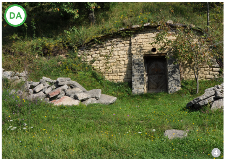
AȘA DA: Anexă gospodărească realizată sub teren. Aceasta dă un aspect plăcut, nefiind o intervenție agresivă, și este executată din materiale naturale (imagine din satul Leghia).
