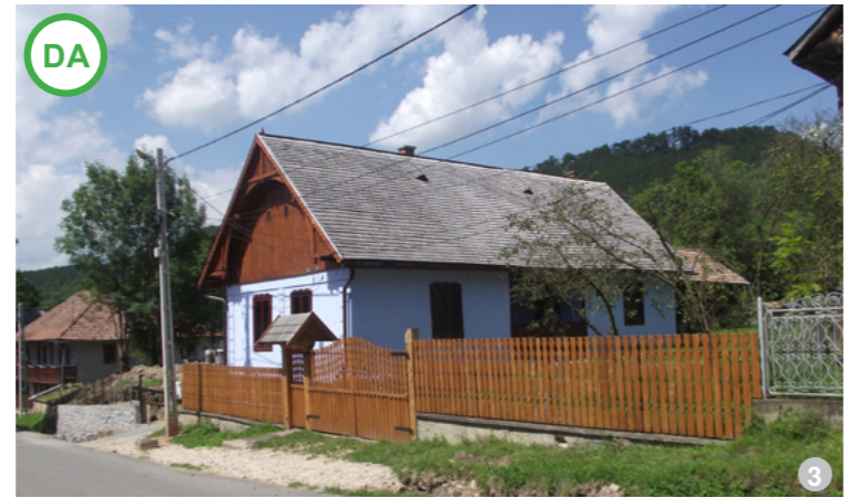
AȘA DA: Casă de locuit tradițională după restaurare
