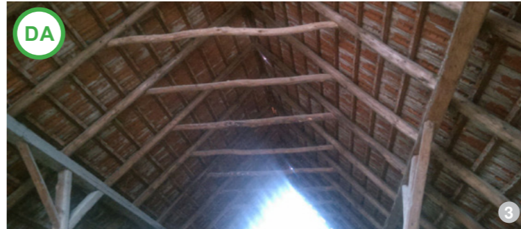
AȘA DA: Șarpanta unei șure. (sat Băgara)
