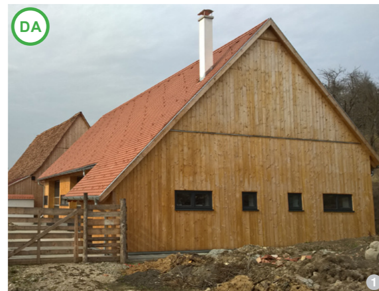
ASA DA: Exemplul se referă la dispunerea pavilionară a construcțiilor care se pretează la funcțiuni precum: școli, grădinițe, afterschooluri, centre de producție etc.
