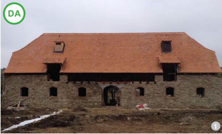
AȘA DA: Zid mixt din piatră de gresie, cărămidă și elemente din beton, care combină tehnica tradițională cu cea contemporană, pentru a corespunde cerințelor de stabilitate etc. – proiect realizat cu finanțare europeană.
