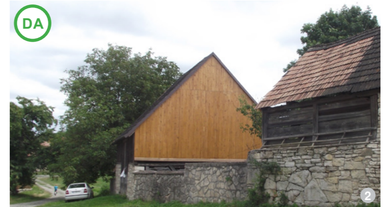
AȘA DA: Finisajul cu lambriu de lemn după dimensiunile locale este varianta optimă pentru clădirile de orice dimensiune (imagine din satul Stana).
