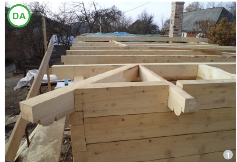
AȘA DA: Cadre tradiționale din lemn în timpul restaurării: un element afectat de degradare nu trebuie înlocuit cu totul (imagine din satul Roșia Montană).
