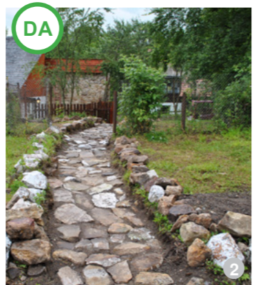
ASA DA: Amenajarea cu piatră a rigolei de scurgere a apelor pluviale (imagine din satul Roșia Montană)
