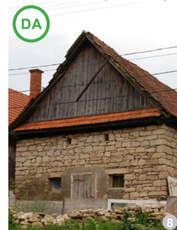
AȘA DA: Șură cu acoperiș în patru ape, cu aruncător de apă (Nădășel)
