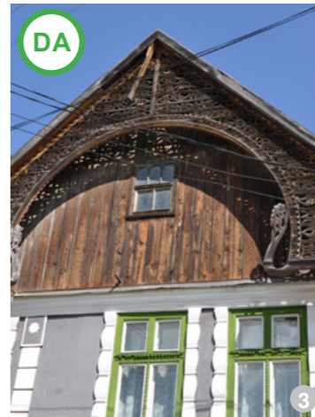
AȘA DA: Atunci când nu se distruge vreo evidență istorică, se pot amplasa goluri în elementele geometrice ale fațadelor, întărindu-le efectul (imagine din satul Inucu).
