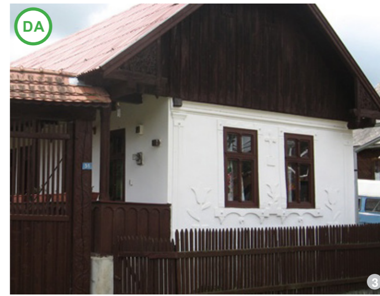
ASA DA: Proporția și ritmul golurilor construcției noi respectă specificul local – proiect realizat cu finanțare europeană (imagine din satul Văleni).
