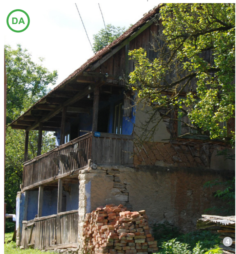
Fundație de piatră și pereți din lemn
