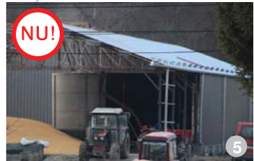
AȘA NU: Se interzice pentru orice tip de construcție folosirea unor finisaje metalice exterioare pe suprafețe mari, precum tabla industrială. Se acceptă finisarea metalică pe suprafețe foarte mici, atunci când fluxul tehnologic sau condițiile obiective de altă natură o impun.
