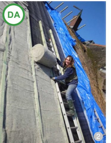
DA AȘA DA: Termoizolația din lână este deosebit de recomandată. Folosirea unei izolații din lână sprijină o industrie a prelucrării produselor locale: în mod frecvent, lână se aruncă, în loc să fie utilizată. Această măsură este încă la început în țara noastră, dar se folosește cu succes și pe scară largă în majoritatea țărilor europene.
