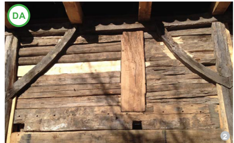
AȘA DA: Intervenție de reabilitare a unui perete din lemn în care s-au păstrat majoritatea elementelor originare.
