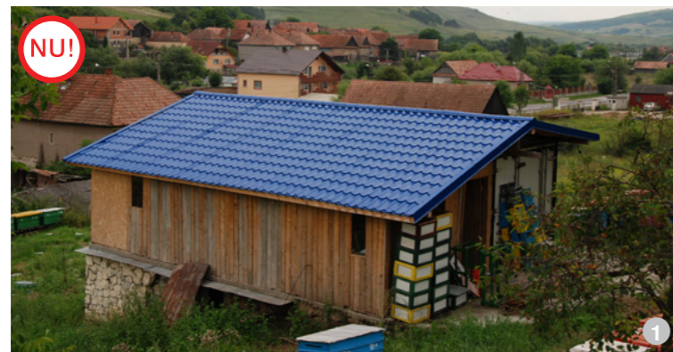
AȘA NU: Se va evita schimbarea culorilor originare a clădirilor anexe și înlocuirea acestora cu zugrăveli acrilice impermeabile, adesea în culori stridente, care se vor decolora neuniform, invelșitori de culori și materiale nespecifice.
