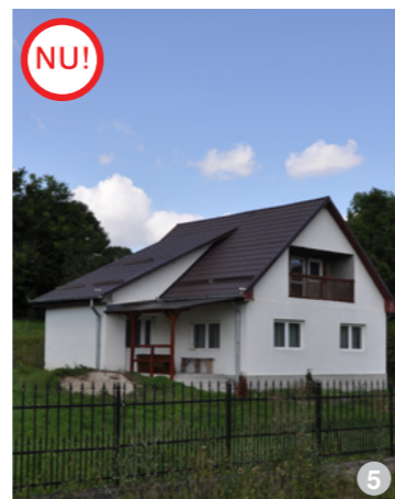
AȘA NU: Forma acoperișului este una complicată, nu este specifică zonei (imagine din satul Turea).
