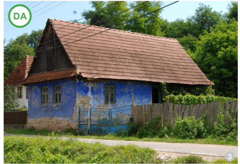
AȘA DA: Zidurile din piatră tencuite cu mortare pe bază de var reprezintă două tipuri de materiale compatibile.
