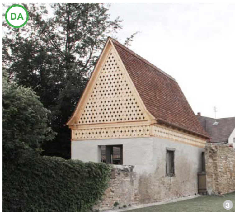
AȘA DA: Intervenție de reconstruire a unui acoperiș și de înălțare a construcției. Intervenția contemporană este vizibilă prin folosirea unui model de traforaj aparte, iar forma tradițională a acoperișului este respectată.
