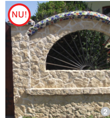
AȘA NU: A se evita placarea stâlpilor porții cu materiale neadecvate (imagine din satul Vlaha).
