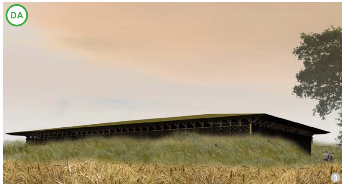
AȘA DA: Acoperirea parțială și protejarea fațadelor de dimensiuni mari ale halelor cu taluzuri de pământ vegetat, rezultat în urma escavărilor din timpul construirii obiectivului.
