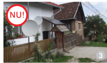
ASA NU: Exemplu din localitatea Bicâlatu: betonarea nu este permisă.
