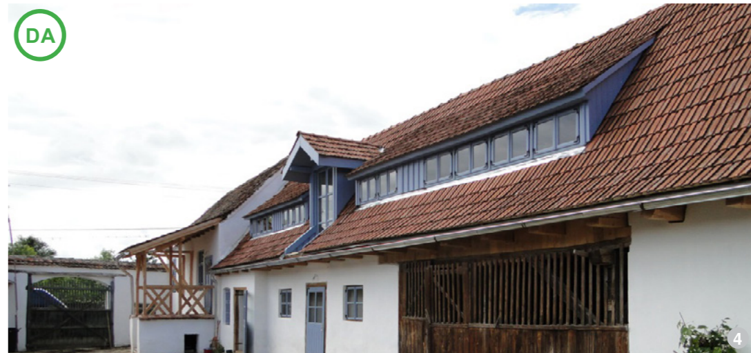
AȘA DA: Lucarna prelungită într-o singură apă precum cea din imagine e o soluție viabilă de iluminare a mansardei.
