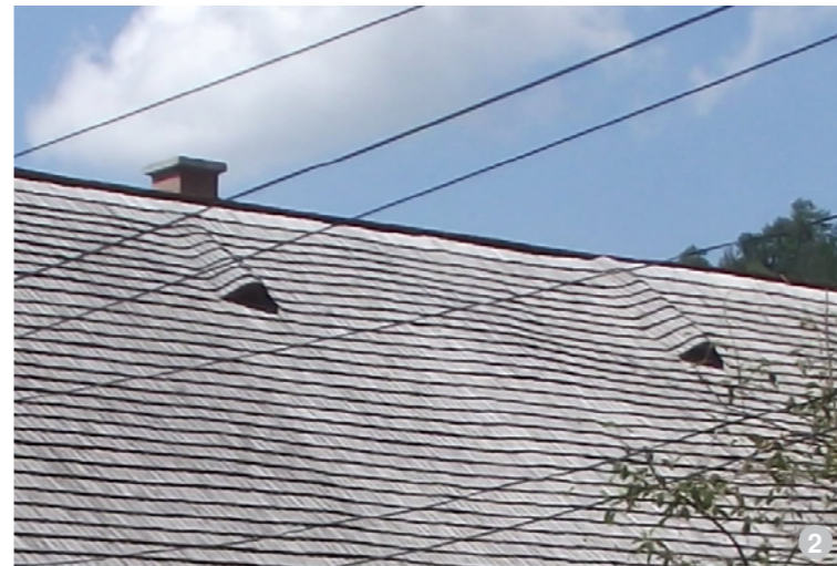
AȘA DA: Lucarnele de tip ochi de pisică sunt cele mai folosite pentru a ilumina un pod mansardat. Acestea modifică nesubstanțial volumul acoperișului (imagine din satul Văleni).
