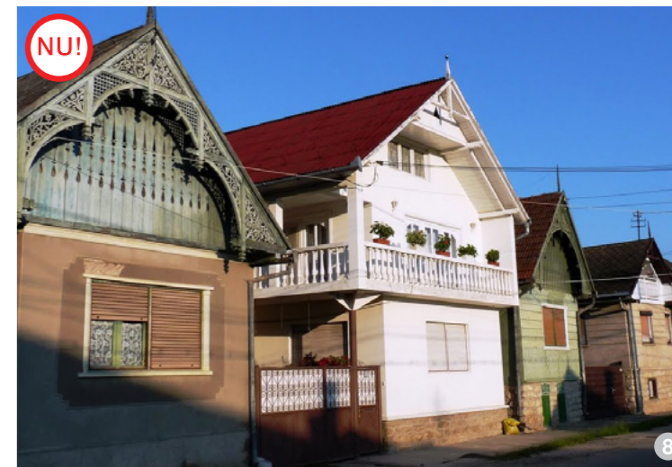
AȘA NU: Nu se acceptă amplasarea logiei și a balconului către stradă și cu atât mai puțin distrugerea frontonului și a decorațiilor pentru realizarea intervenției.
