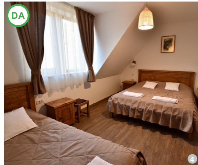
AȘA DA: Prin realizarea unui acoperiș cu pantă mai mare, se creează condiții optime pentru amenajarea unor spații locuibile, dormitoare, băi etc.
