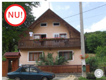
AȘA NU: Zugrăvirea pereților unei construcții noi în culori pastelate, nespacifico, este strict nerecomandată (imagine din satul Jebucu).
