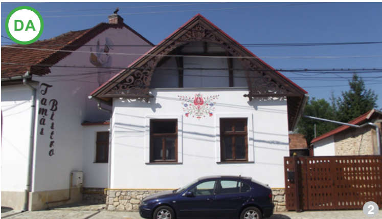
AȘA DA: Clădirea nouă, realizată din cărămidă cu goluri mari și beton, arată că anumite materiale noi pot fi puse în operă, în logica lor, într-un mod care să țină cont de volumetria specific locală.
