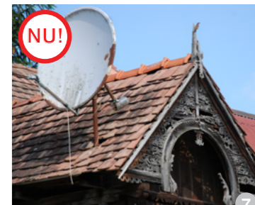
AȘA NU: Instalațiile nu își au locul pe învelitoare, deoarece permit infiltrațiile.
