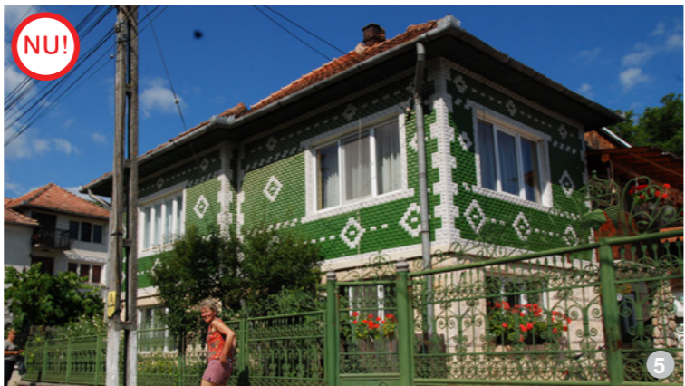
AȘA NU: Se interzice placarea cu piatră și cu materiale ceramice a soclului și a pereților. Aceste materiale trebuie puse în operă în logica lor constructivă (imagine din satul Inucu).
