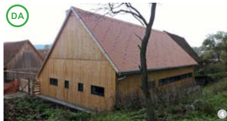
AȘA DA: Pentru construcții cu funcțiuni industriale cu deschideri mari, se pot folosi sisteme structurale combinate, atât metal, cât și lemn, pentru a permite utilizarea unor materiale locale pentru finisaje și învelitori, precum țigla și lambriul.
