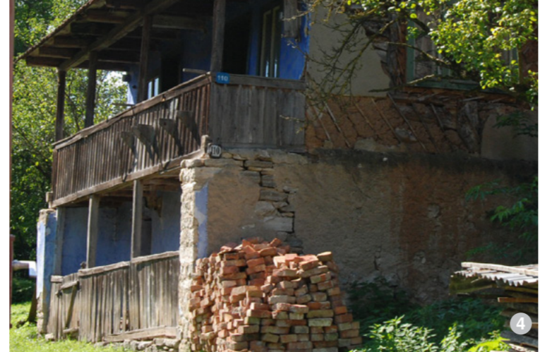
Fundație de piatră și pereți din lemn
