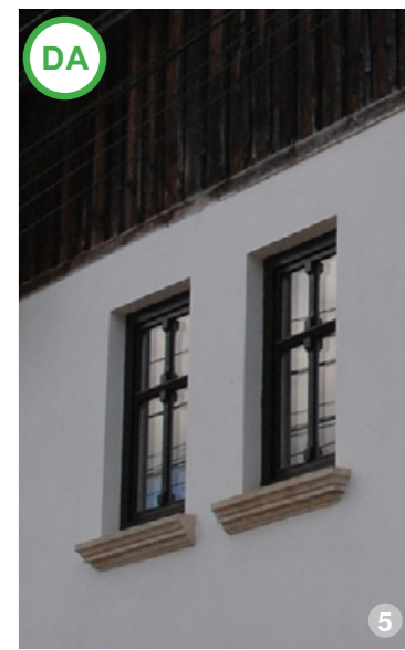
ASA DA: Fereastră nouă din lemn, inspirată din specificul local și care este prevăzută cu accesorii de impermeabilizare și înlăturare a apei. Confectionarea acestor ferestre se poate face într-un atelier local, sprijinind astfel economia locală.
