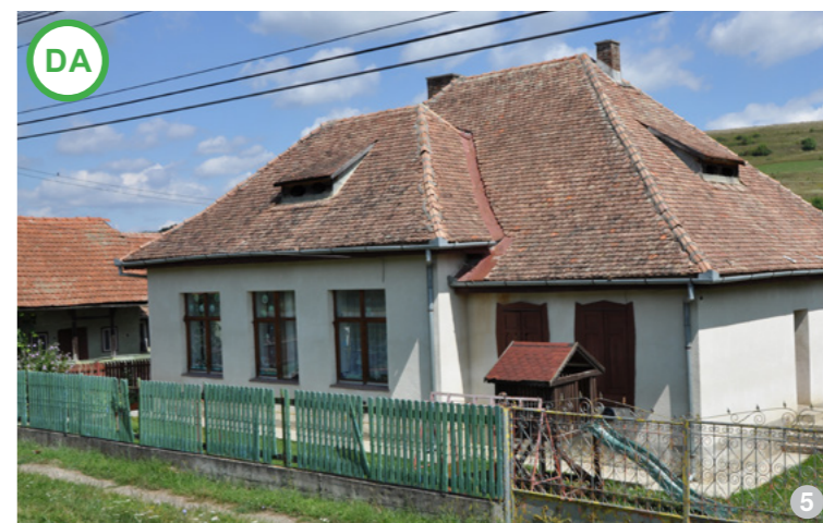
AȘA DA: Proporția și ritmul golurilor construcției noi respectă specificul local – proiect realizat cu finanțare europeană.
