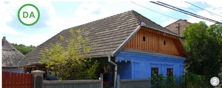
AȘA DA: Restaurarea elementelor decorative este deosebit de importantă pentru imaginea de ansamblu, pitorească, a clădirii.
