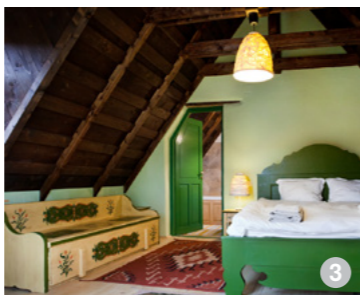
AȘA DA: Structura acoperișurilor reprezintă un element important pentru evidența istorică și dau un farmec aparte spațiilor mansardate atunci când rămân aparente; de aceea, nu se recomandă schimbarea lor integrală, ci înlocuirea pieselor degradate.
