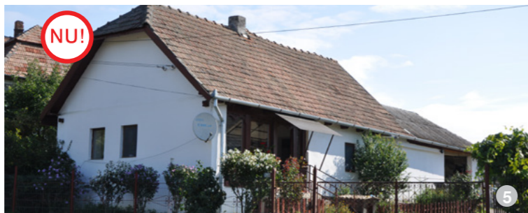
AȘA NU: Clădire tradițională după intervenție: s-au îndepărtat elementele caracteristice ale fațadei, precum sunt decorațiile, tâmplăriile, țiglele, cornișa, în locul cărora s-a montat o tâmplărie din PVC, material necaracteristic zonei, s-au distrus decorațiile istorice, montându-se, probabil, în schimb o termoizolație din polistiren.
