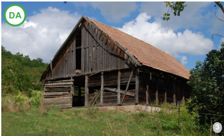
AȘA DA: Exemplu de clădire cu gabarit mare care se integrează în peisaj prin materialele folosite pentru structură și spațiile de trecere, prin menținerea unei înălțimi moderate.
