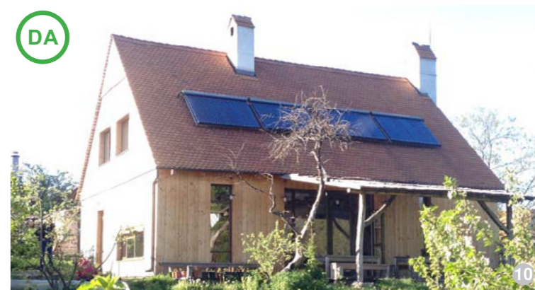
AȘA DA: Amplasarea panourilor generatoare de energie nu va depăși 15 % din suprafața învelitorii.
