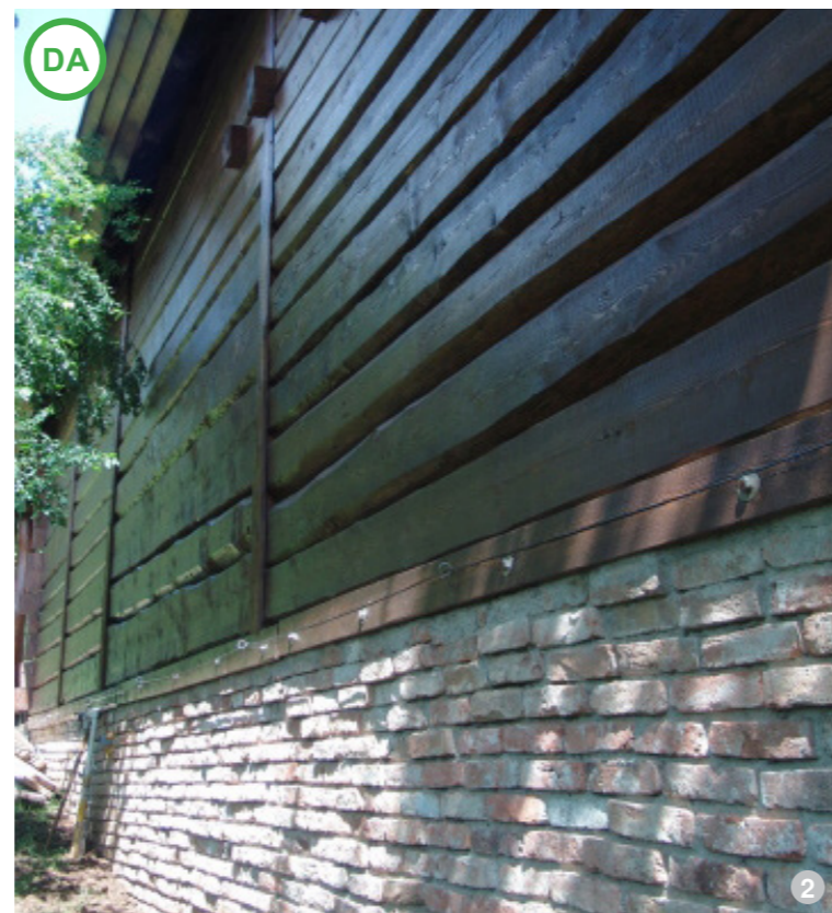
ASA DA: Materialele de construcție tradiționale, precum cărămida și lemnul, pot fi puse în operă într-o modalitate contemporană, corespunzând standardului de confort actual.
