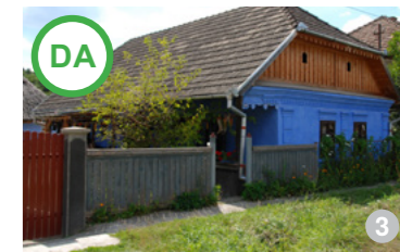
Acoperiș în două ape cu țeșitură pe timpan (imagine din Sic)
