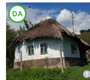
Acoperiș în patru ape din stuf (imagine din Tăușeni)
