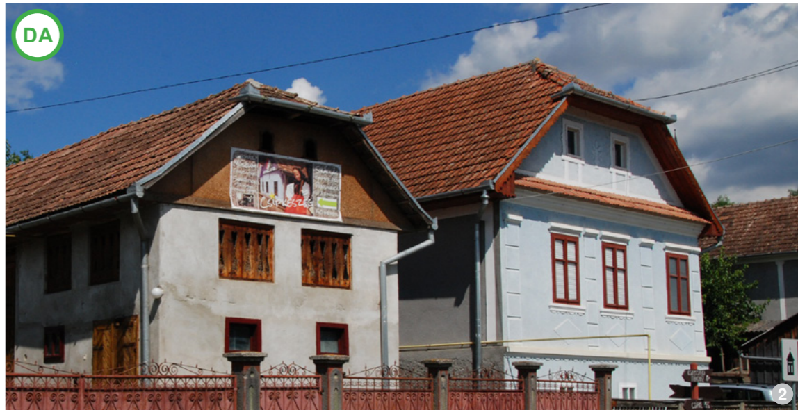
AȘA DA: Țigla trasă nouă, utilizată la o clădire restaurată
