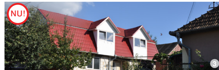
AȘA NU: Nu se recomandă complicarea soluției de acoperire. Iluminatul mansardei poate fi realizat într-un mod mai elegant.
