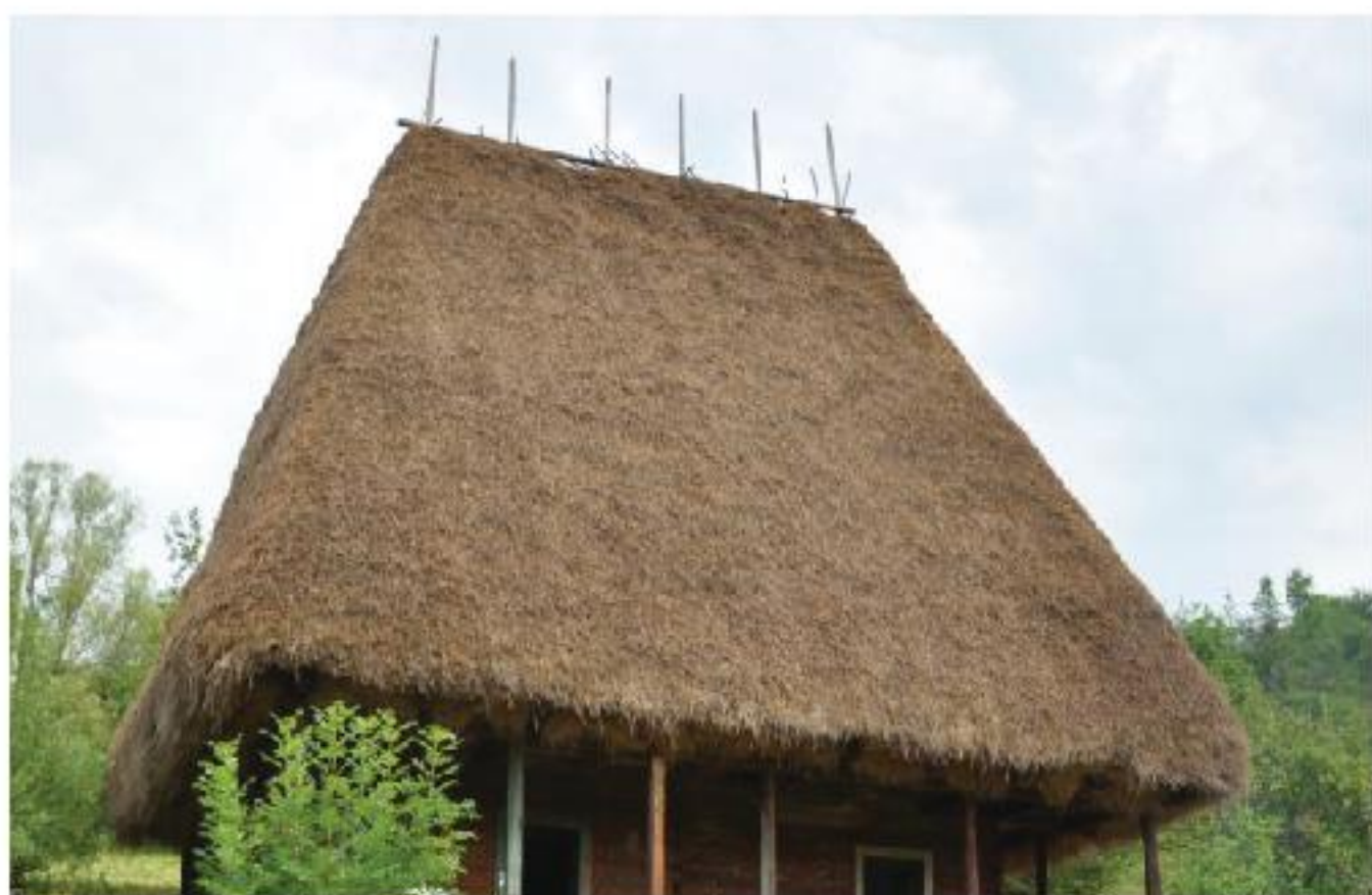
Acoperiș în 4 ape, acoperit cu paie
