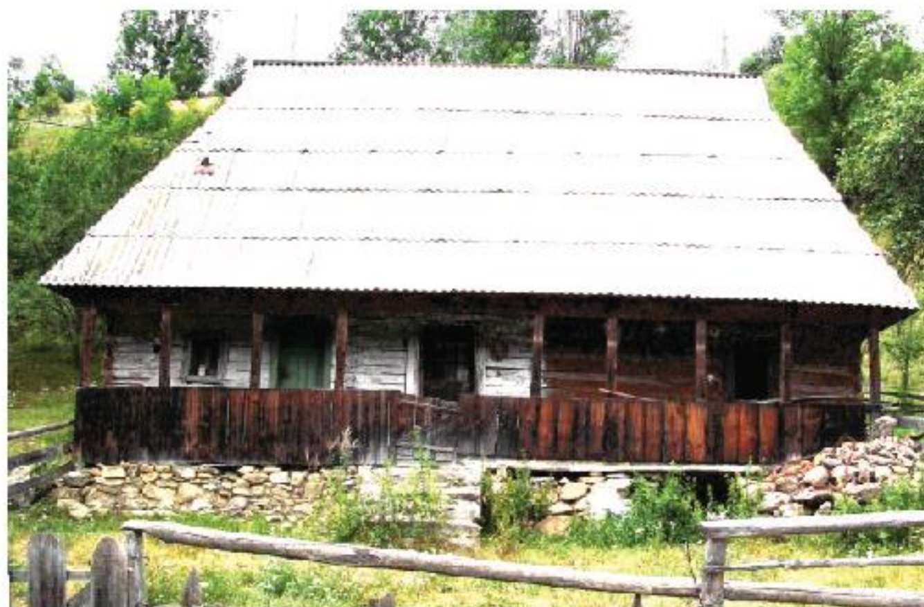
Acoperiș în 4 ape acoperit cu șindrila
