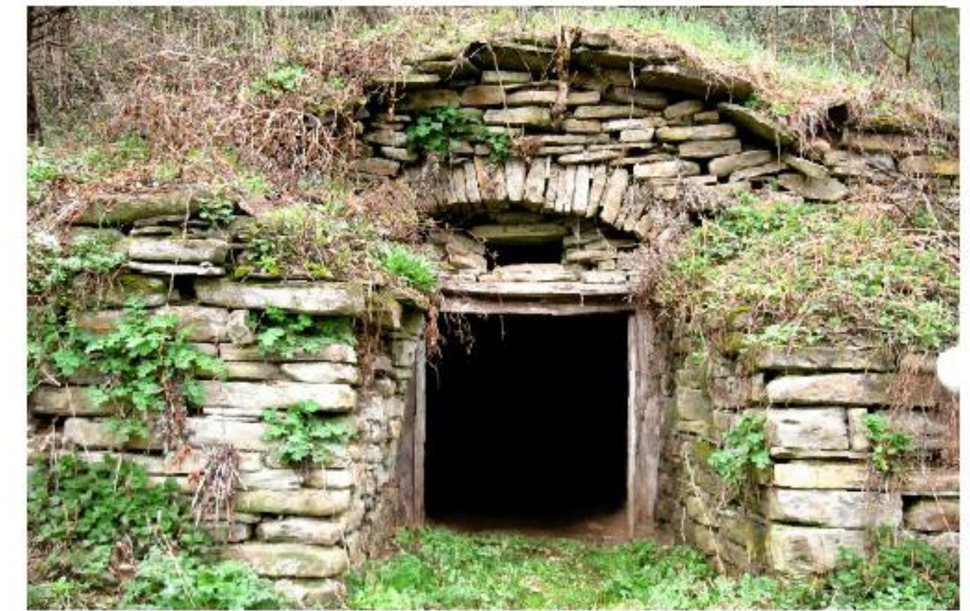
Bulbuc. Pivniță ridicată din piatră, detașată de casă
