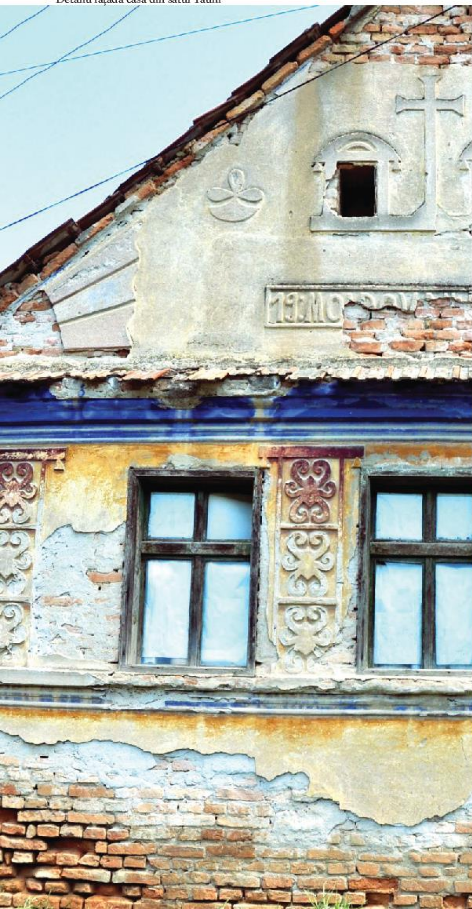
Detaliu fațadă casă din satul Tăuni
